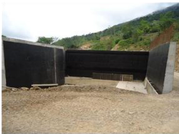
Figura 21. Eje 3 y muro de acompañamiento Puente SMR II
