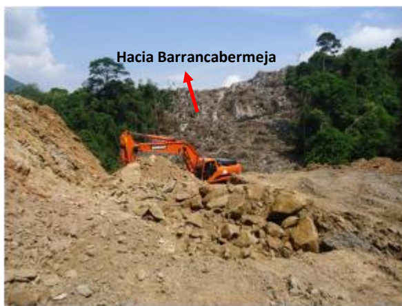
Figura 12. Excavación para acceso a Puente NN IV desde frente 2
