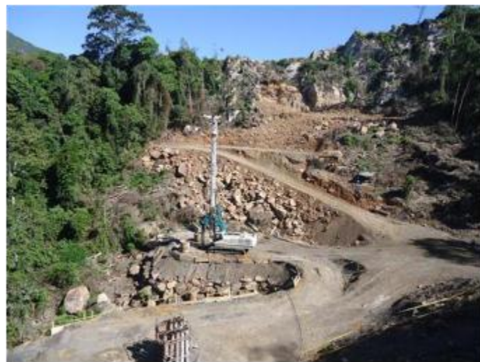
Figura 24. Panorámica de las plataformas de excavación Puente NN IV
