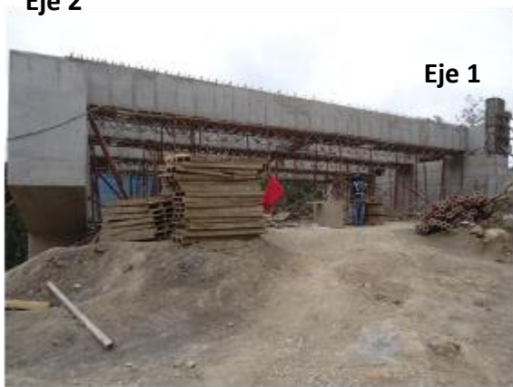
Figura 19. Ejes 1 y 2 del Puente Santa María Ramal II
