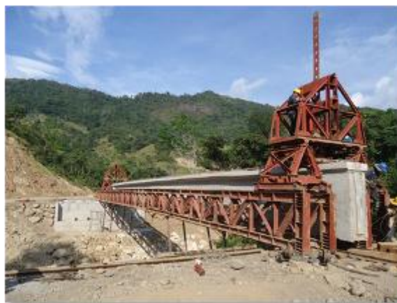
Figura 18. Lanzamiento de viga PSMR I
