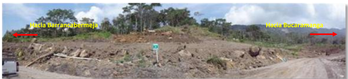
Figura 14. Conformación del talud superior como consecuencia de los deslizamientos de tierra.
