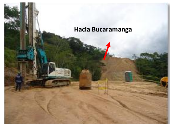
Figura 23. Excavación Pilote en Eje 1 Puente NN III
