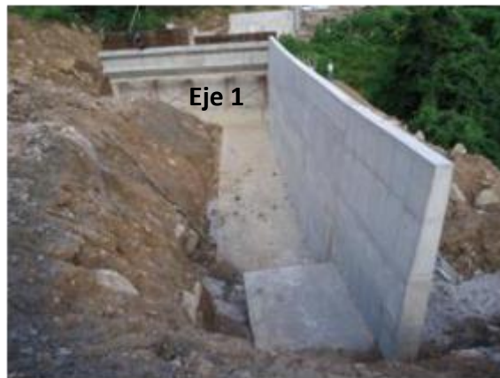
Figura 20. Muro de acompañamiento Eje 1 Puente SMR II
