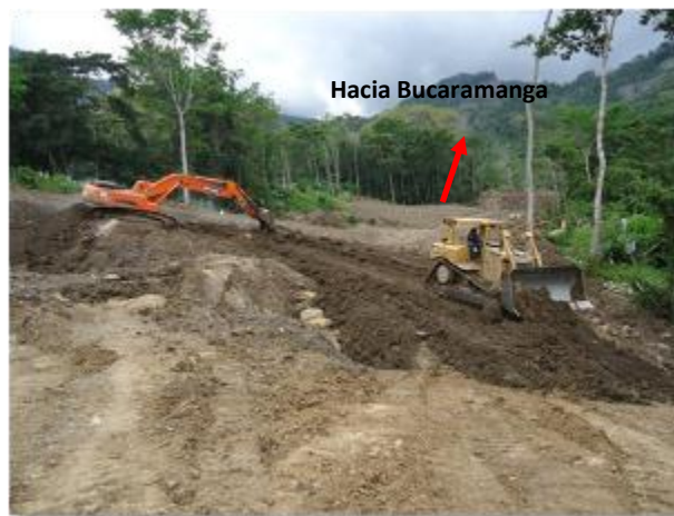
Figura 15. Descapote y excavación para arribar a las abscisas del Puente Mata de Cacao
