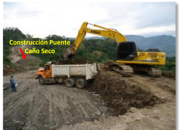
Figura 17. Excavación de producción Frente 3 B
