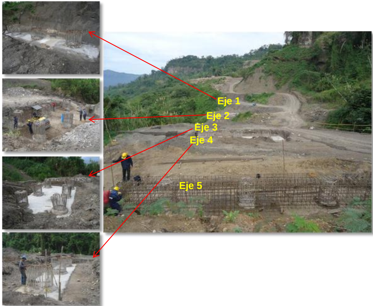
Figura 25. Panorámica de los ejes del Puente Caño Seco
