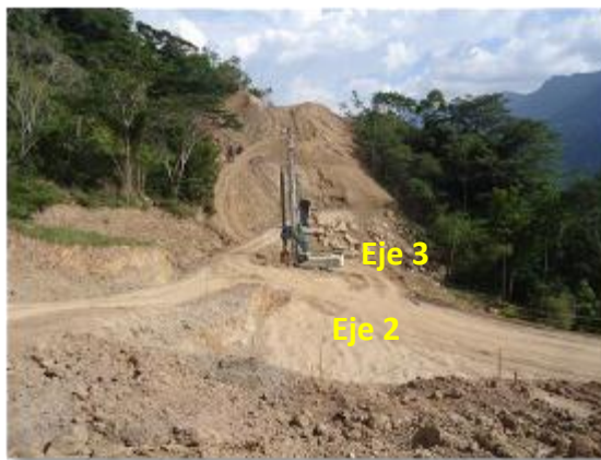
Figura 22. Ejes 2 y 3 Puente NN III
