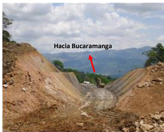
Figura 13. Explanación de producción metros atrás del NN IV
