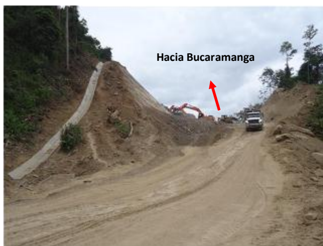
Figura 11. Explanación para acceso Puente NN III desde Frente 1
