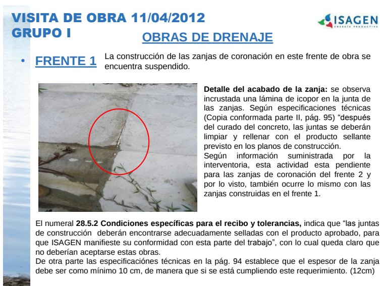
Figura 7. Verificación en obra de especificaciones
