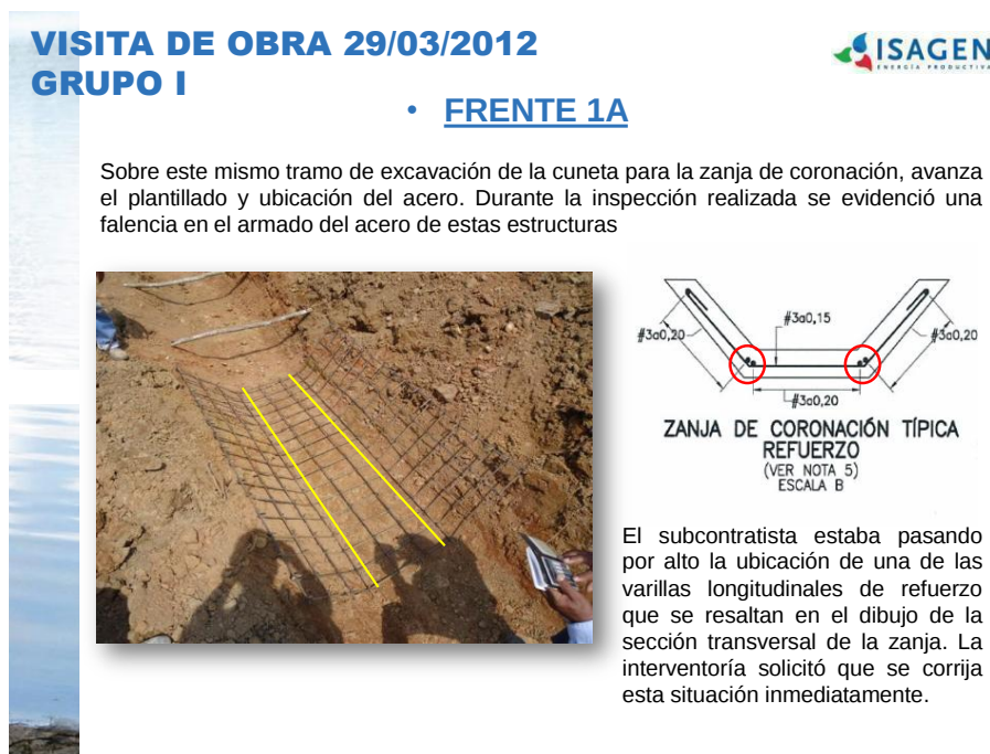
Figura 8. Verificación en obra de especificaciones
