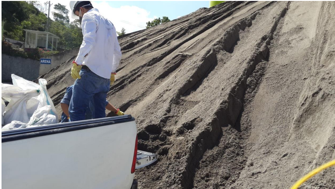
Figura 1, Extracción de materiales para la preparación de la mezcla de concreto
