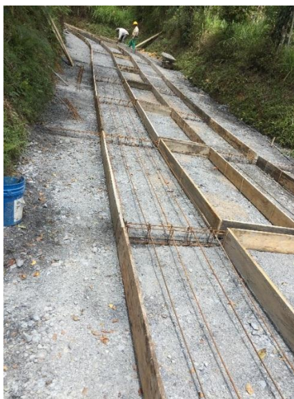
Ilustración 24 Colocación de acero en placa huella.
