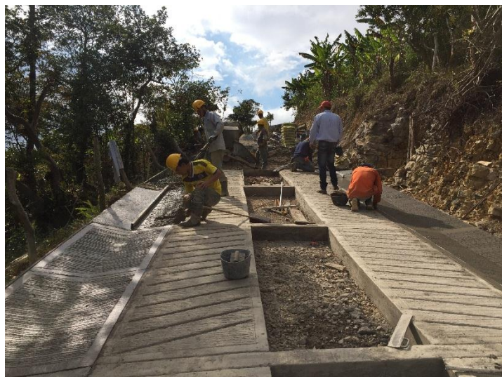
Ilustración 28 Supervision de la fundicion de cunetas.
