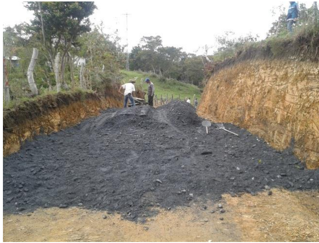
Ilustración 21 Colocación de subbase granular
