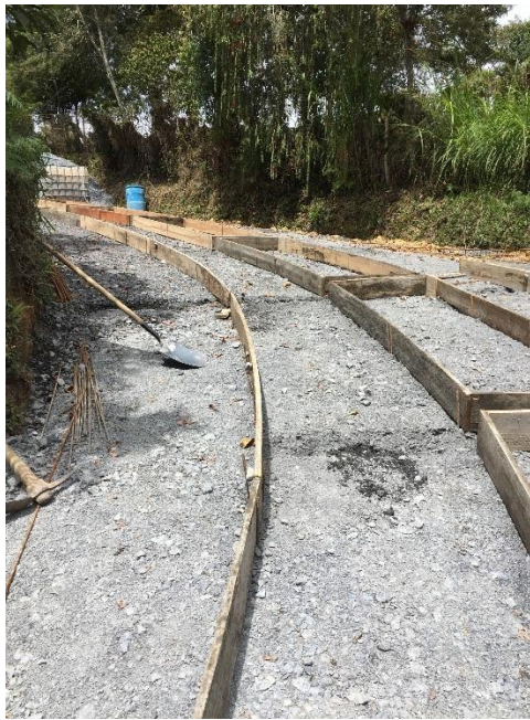
Ilustración 23 Armado de formaleta.
