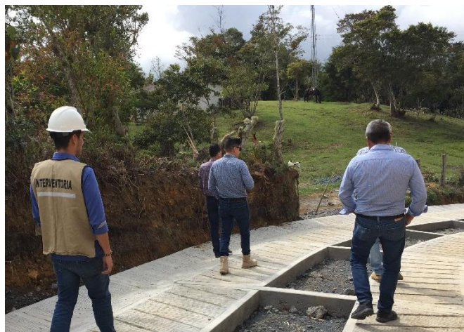
Ilustración 6 Visita de obra programada. Fuente Consorcio El Tigre la Paz
