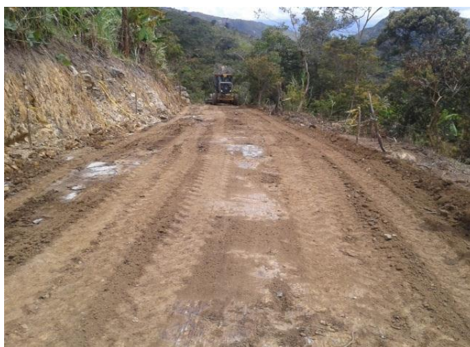
Ilustración 19 Cuneteo de vía
