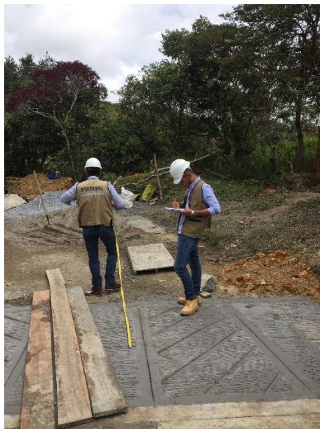
Ilustración 40 Medición y cálculo de cantidades de obra.
