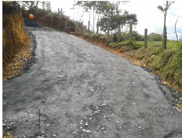
Ilustración 22 Compactación subbase granular
