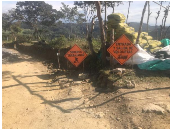
Ilustración 14 Señalización entrada y salida de maquinaria
