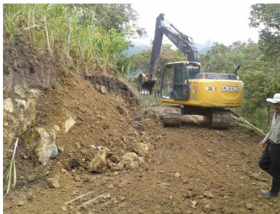
Ilustración 17 Excavación en roca
