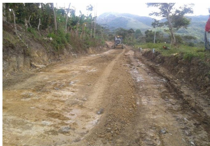
Ilustración 20 Cuneteo de vía
