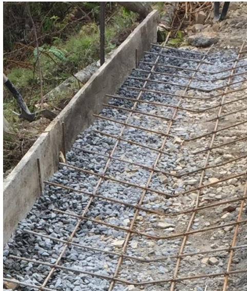
Ilustración 26 Colocación de acero en cuneta.
