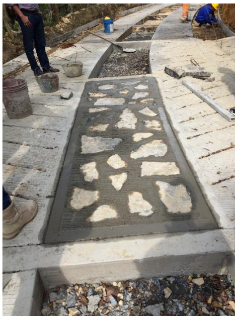
Ilustración 30 Fundición concretos clase G.
