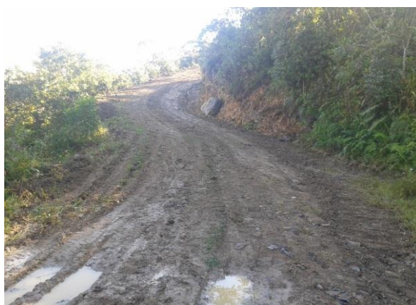
Ilustración 15 Descapote y limpieza manual
