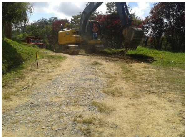
Ilustración 16 Descapote y limpieza con retroexcavadora
