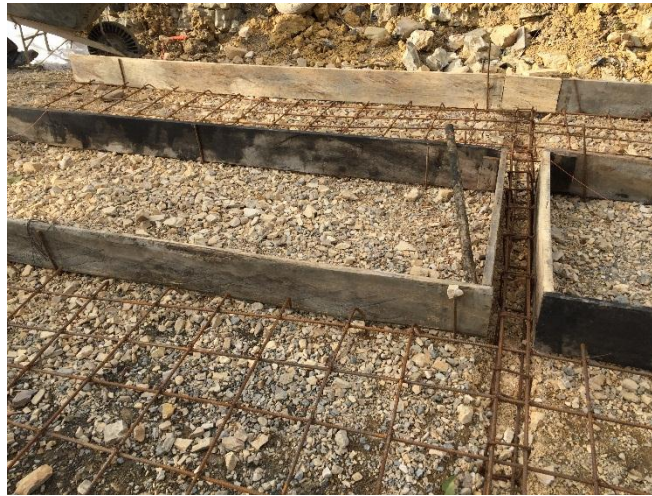
Ilustración 25 Colocación de acero en viga riostra.
