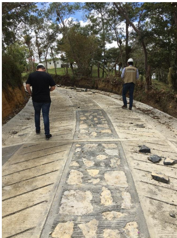
Ilustración 31 Inspección concretos clase G.
