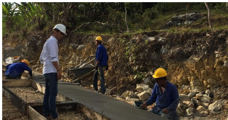
Ilustración 27 Supervisión de la fundición de placa huellas.
