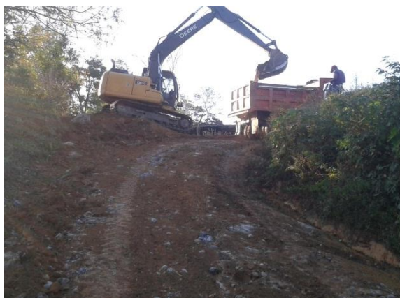
Ilustración 18 Excavación en material común
