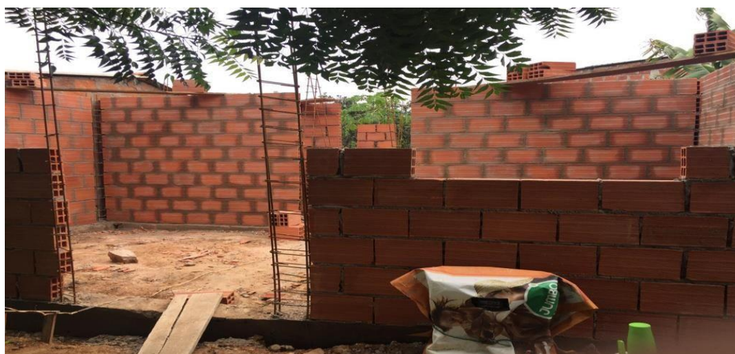
Figura 15. Levantamiento de muros internos
