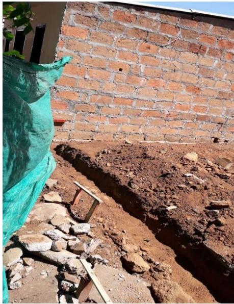
Figura 12. Replanteo y viga de cimentación
