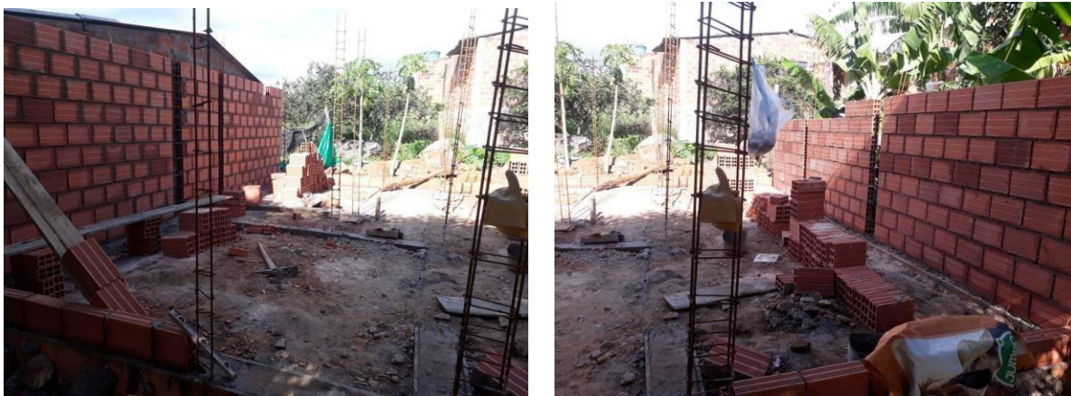
Figura 14. Mampostería Ladrillo H10
