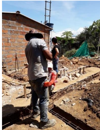
Figura 13. Amarre de columnas y vigas y armado de formaleta
