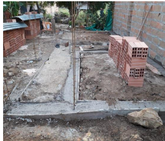
Figura 13. Amarre de columnas y vigas y armado de formaleta
