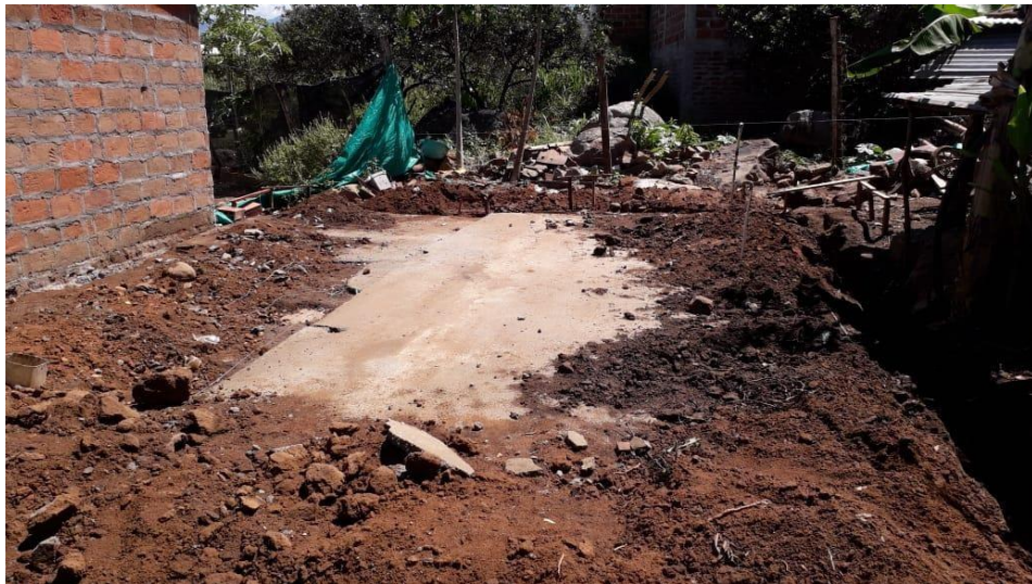
Figura 11. Remoción de escombros y excavación
