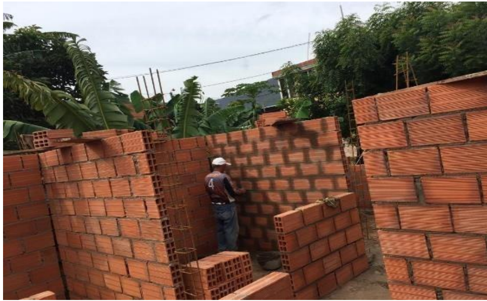
Figura 16. Levantamiento mampostería interna de la vivienda
