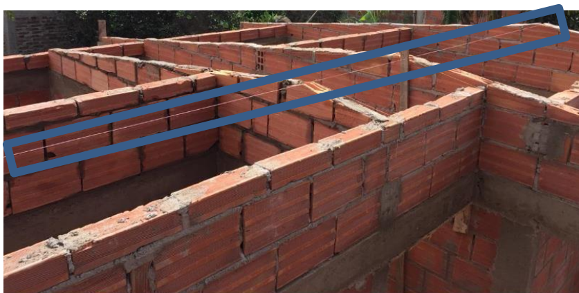
Figura 20. Terminado de mampostería y estructura
