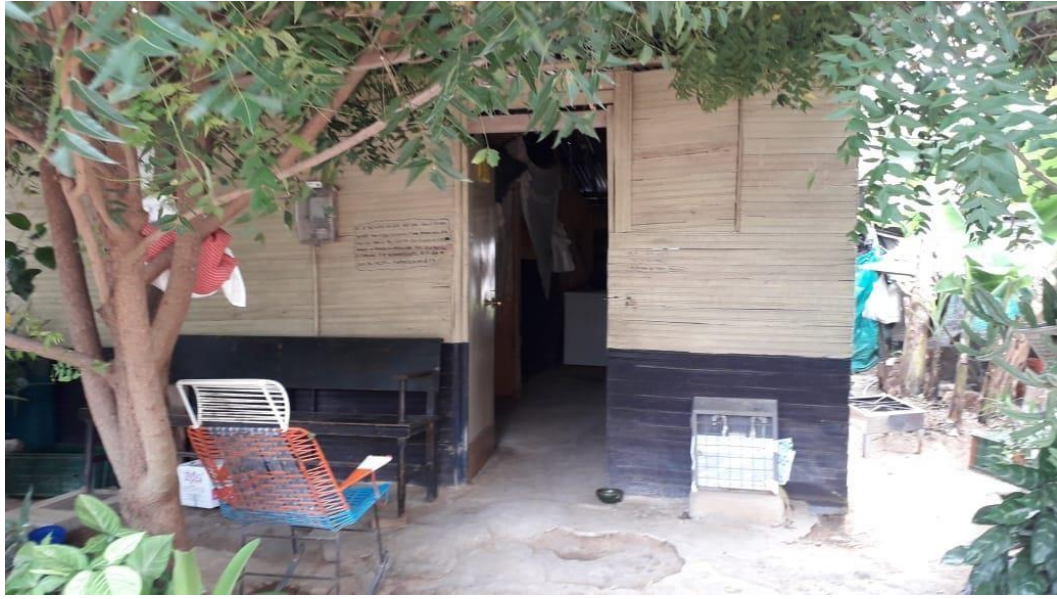
Figura 10. Vivienda antes de demolición
