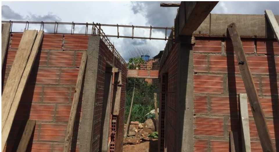
Figura 19.Colocación de formaleta en la viga
