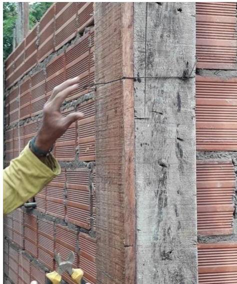
Figura 17. Colocación de formaleta para columnas
