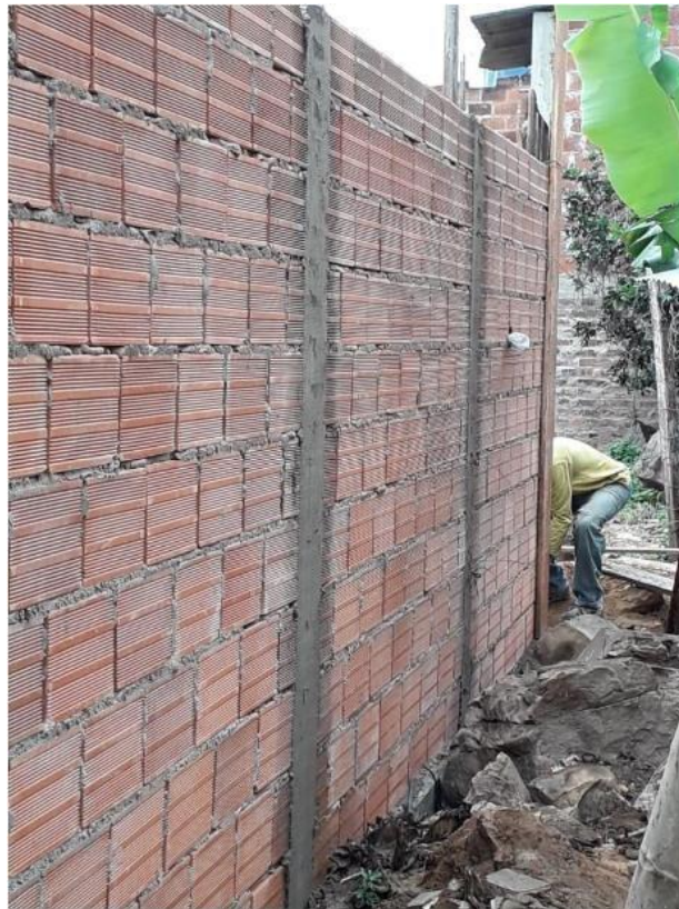
Figura 18.fundida de columnas y levantamiento total de muros
