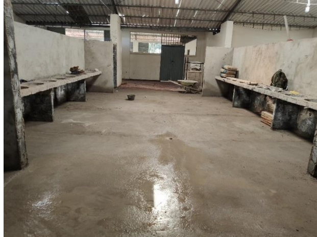
Imagen 23. Curado del mortero de nivelación en la zona de los lavamanos.
