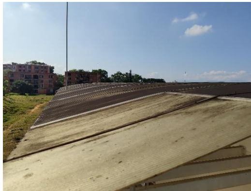
Imagen 33. Estado actual de las cubiertas en lámina de policarbonato.
