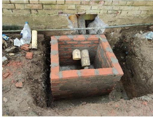
Imagen 18. Construcción de la caja de inspección.
