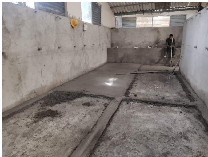
Imagen 22. Guías maestras para aplicación de mortero de piso.
