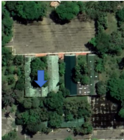
Imagen 11. Localización de batería de baños BICAL.
