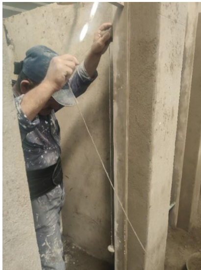
Imagen 24.Revisión de plomado del pañete liso de muro en zona de los baños.
