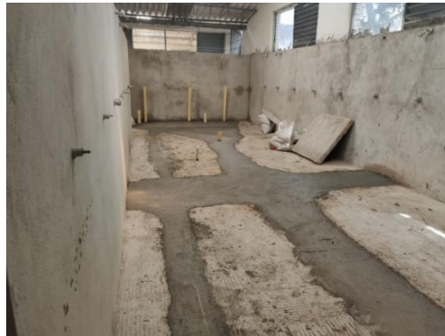
Imagen 13. Relleno de la tubería sanitaria zona de los lavamanos.
