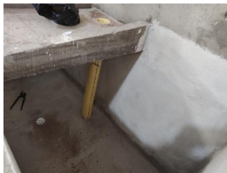
Imagen 27. Impermeabilización de la zona de los lavaderos con Sika-1.
