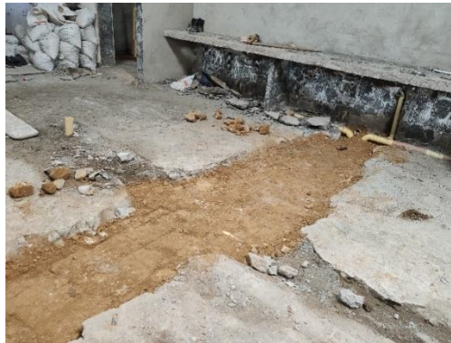
Imagen 13. Relleno de la tubería sanitaria zona de los lavamanos.
