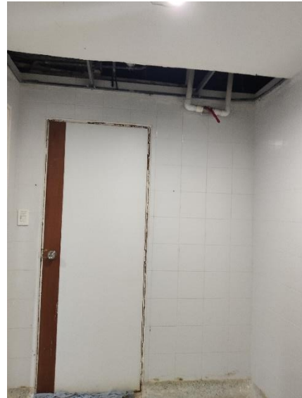
Hueco en el cielo raso y puerta con marco metálico oxidado.
