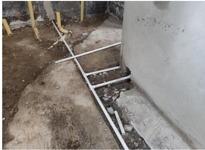
Imagen 16. Instalación de red hidráulica en un tramo de la zona de las duchas.
