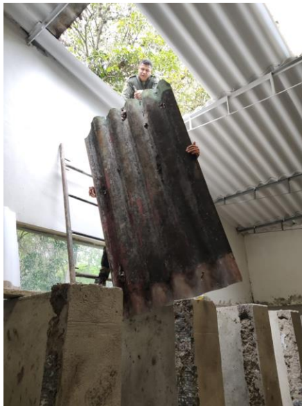
Imagen 28.Cambio de tejas en mal estado.
