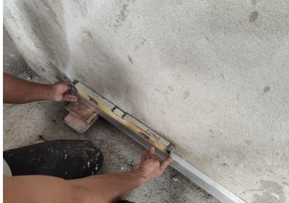
Imagen 25. Nivelación y alineación de regla para comenzar a enchapar el muro.
