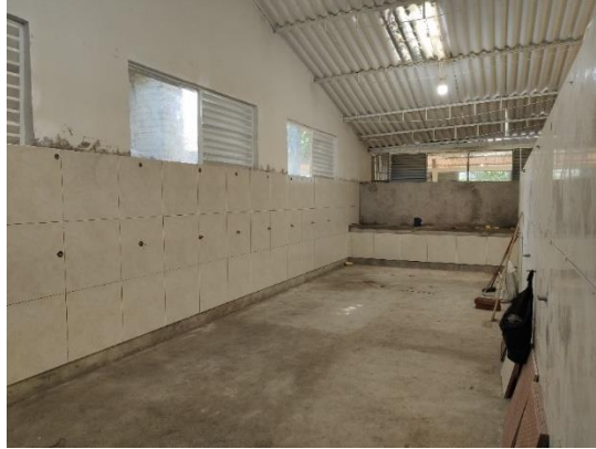
Imagen 26. Enchape de muros en la zona de las duchas
