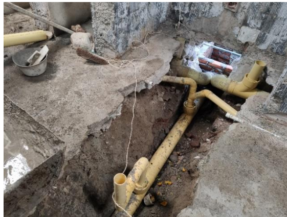
Imagen 15. Instalación de la tubería sanitaria principal en la zona de los baños.
