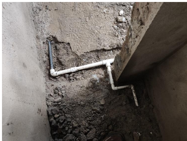
Imagen 16. Instalación de red hidráulica en un tramo de la zona de las duchas.
