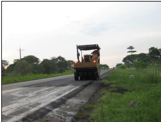
Supervisando la compactación con llantas en la carpeta rodadura
