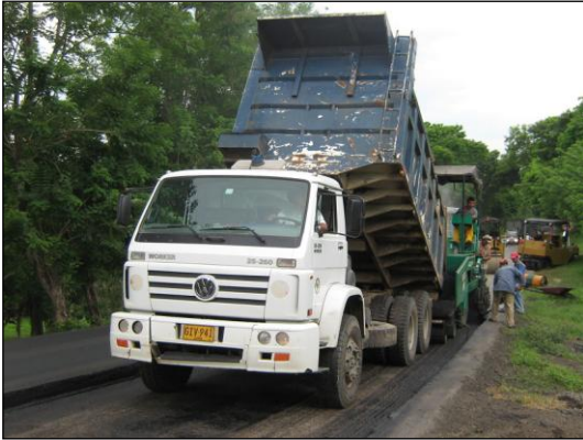
Supervisando la aplicación carpeta rodadura.
