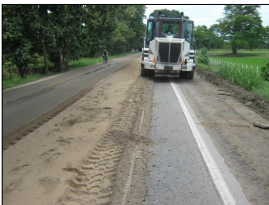
Reciclando el tramo definido para dicha actividad
