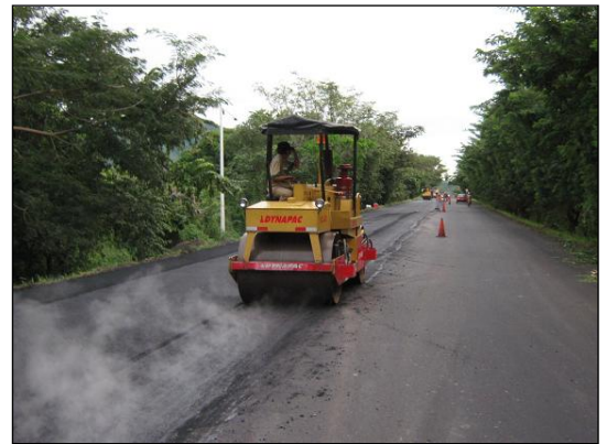
Supervisando la compactación con rodillo en la carpeta.
