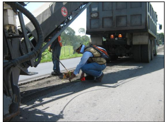
Supervisando el espesor
