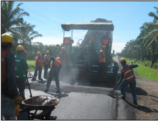
Supervisando la aplicación carpeta
