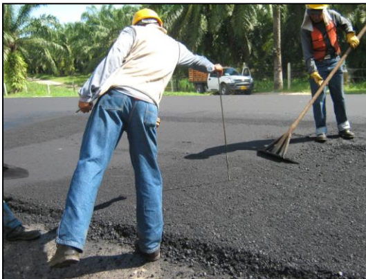
Controlando el espesor de la carpeta
