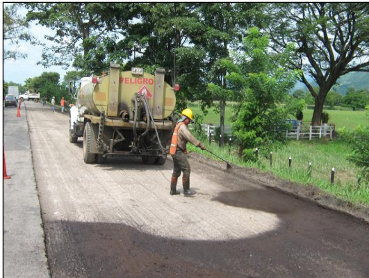
Supervisando para que la irrigación sea homogénea.
