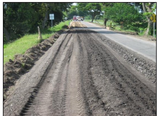
Homogenización de la superficie.
