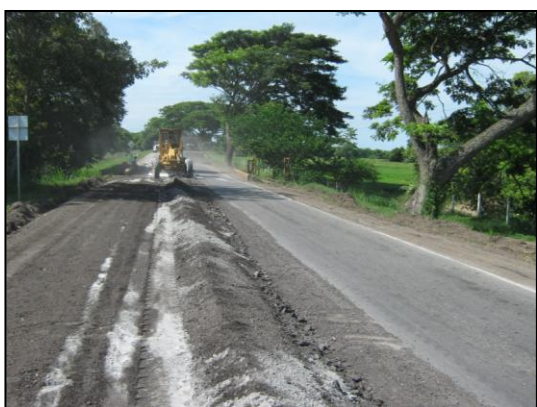
Homogenización de la superficie.
