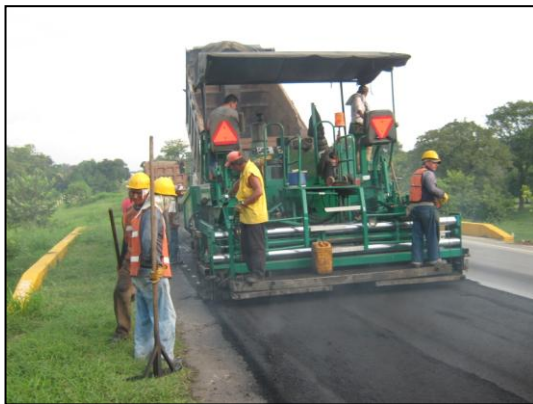
Supervisando la aplicación carpeta de rodadura
