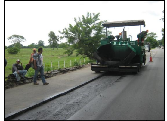
Área lista para aplicación de la mezcla, Pr 35+600
