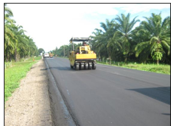
Supervisando la compactación con llantas en carpeta rodadura.
