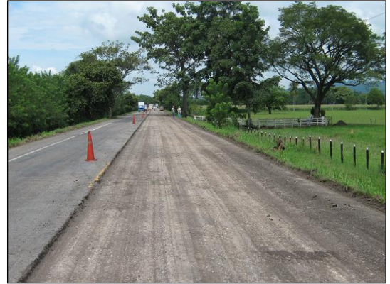
Tramo completamente fresado y libre de material.
