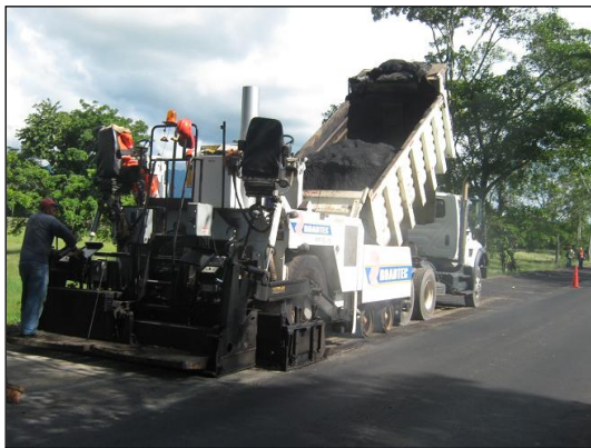
Supervisando la aplicación de la carpeta .
