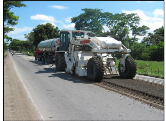
Aplicación de emulsión a la superficie.
