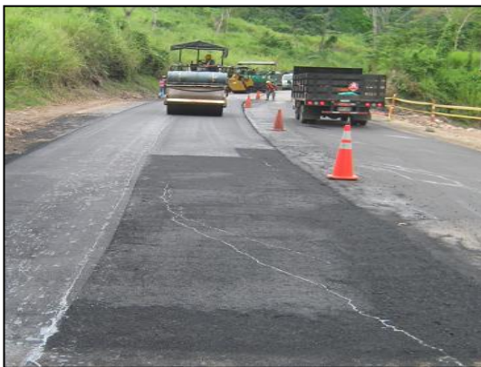
Supervisando la compactación con rodillo en la carpeta.
