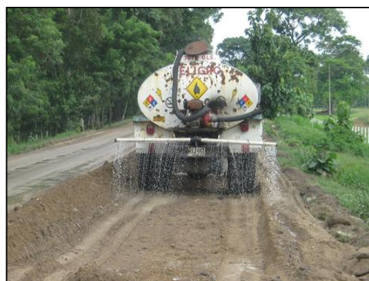
Humedeciendo la superficie para proceder a compactar
