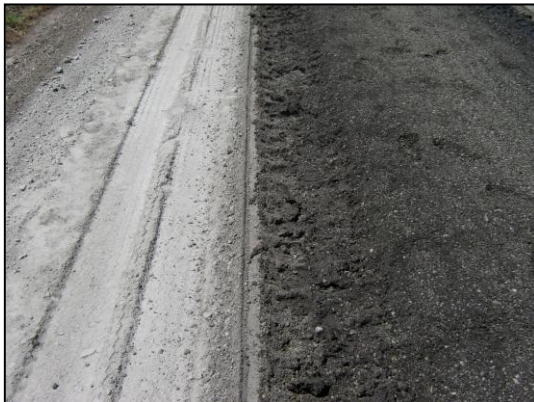
Diferencia entre superficie ya reciclada con asfalto.
