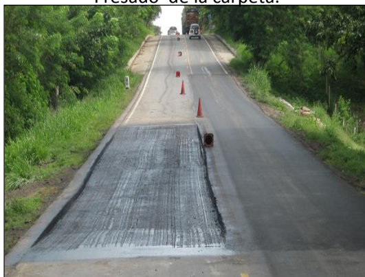
Tramo completamente irrigado.
