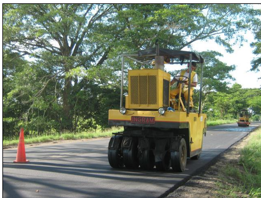
Supervisando la aplicación de la carpeta .
