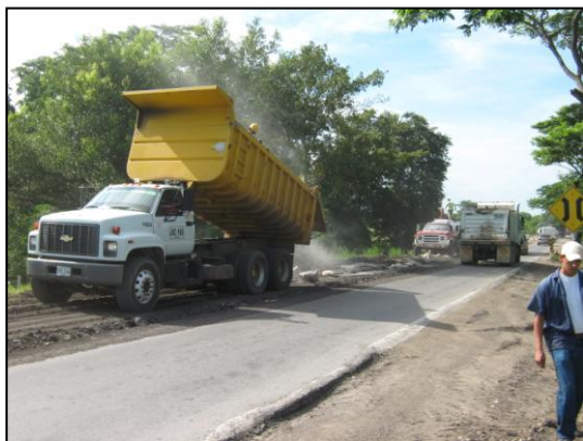
Colocación de los bultos de cemento.
