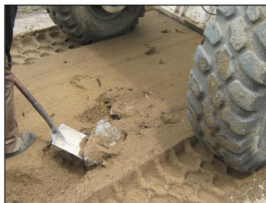
Retiro de sobre-tamaños de la carpeta de rodadura
