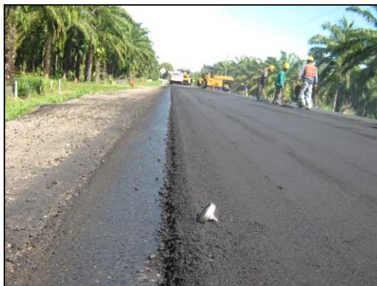
Controlando la temperatura para la respectiva compactación
