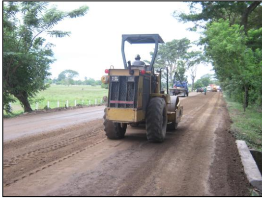
Compactando la superficie
