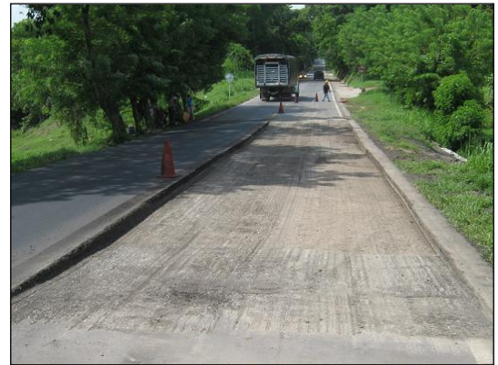
Tramo completamente fresado y libre de material.
