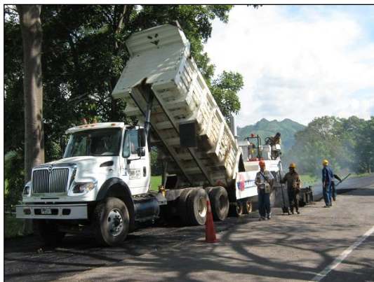
Supervisando la aplicación de la carpeta .
