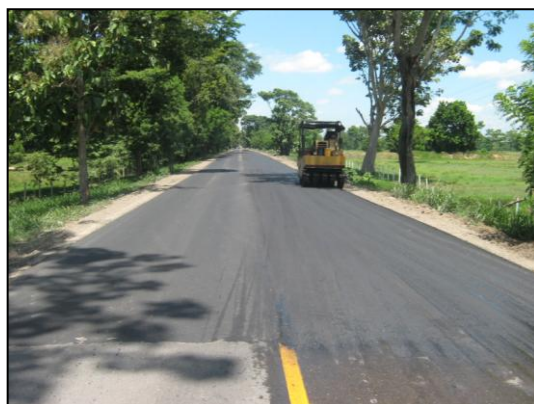
Supervisando la compactación con llantas .
