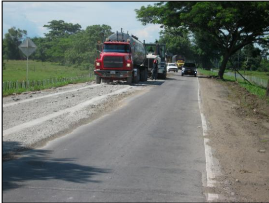
Aplicación de emulsión a la superficie.
