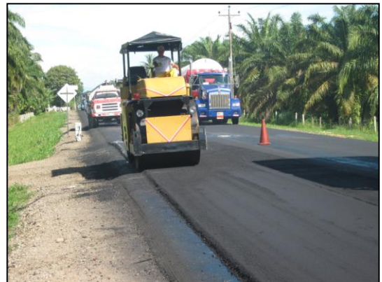
Vigilando la compactación con rodillo.
