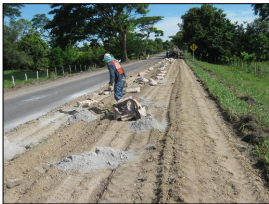
Retiro de las bolsas de cemento.
