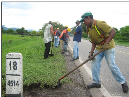
Supervisando la adecuada limpieza de berma.
