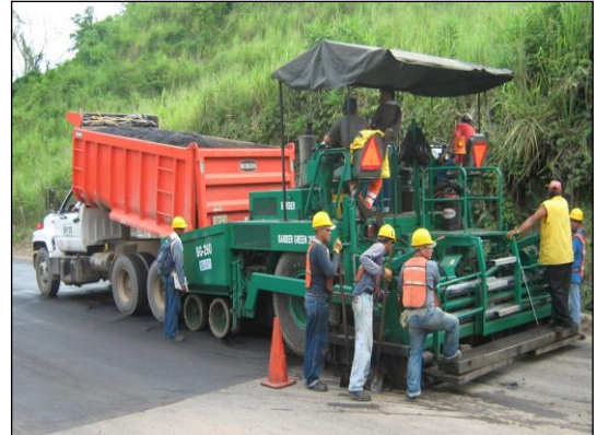
Supervisando la aplicación carpeta rodadura .
