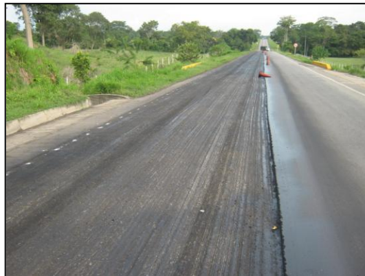
Tramo completamente fresado
