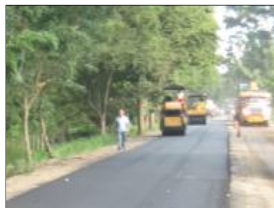
Vigilando la compactación con rodillo en la carpeta de rodadura
