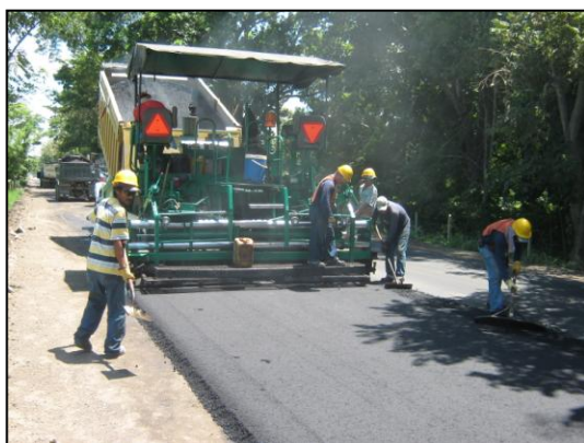
Supervisando la aplicación carpeta rodadura
