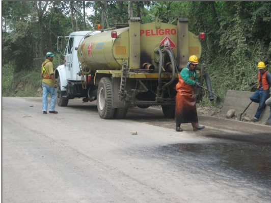
Supervisando para que la irrigación sea homogénea.
