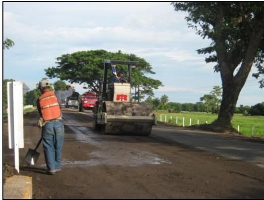
Compactando la superficie.
