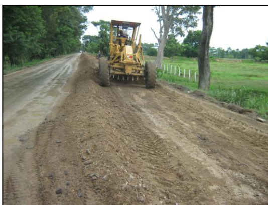
Homogenizando la superficie reciclada
