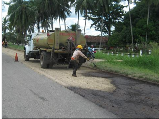
Supervisando para que la irrigación sea homogénea.
