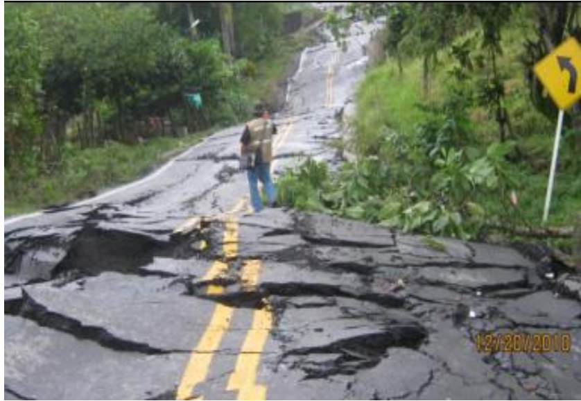
Figura 4. Panorama de la vía diciembre 20 del 2010.
