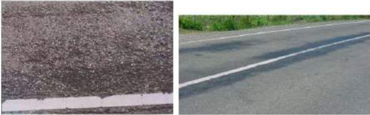
Figura 5. Perdida de áridos y exudación en el pavimento. Tomado de (Dirección de Vialidad, 2016)
