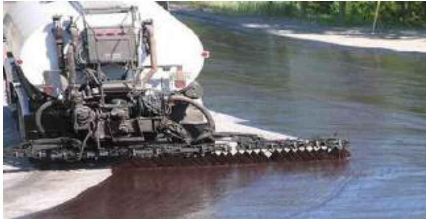
Figura 30. Aplicación de lechada asfáltica. Tomado de ( mantoasfalticoconstruya.com, 2021 )
