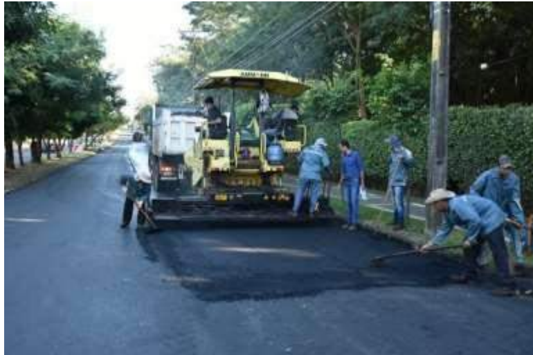
Figura 29. Aplicación de pavimento reforzado. Tomado de ( El Sol de San Luis , 2019)
