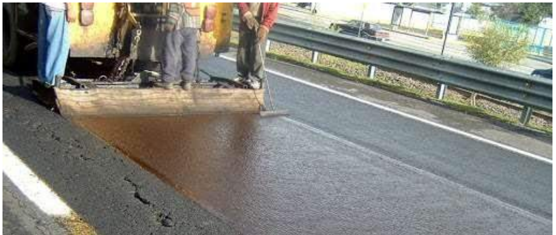
Figura 31. Aplicación de microcarpeta. Tomado de ( http://oi68construcciones.com/ , 2017)
