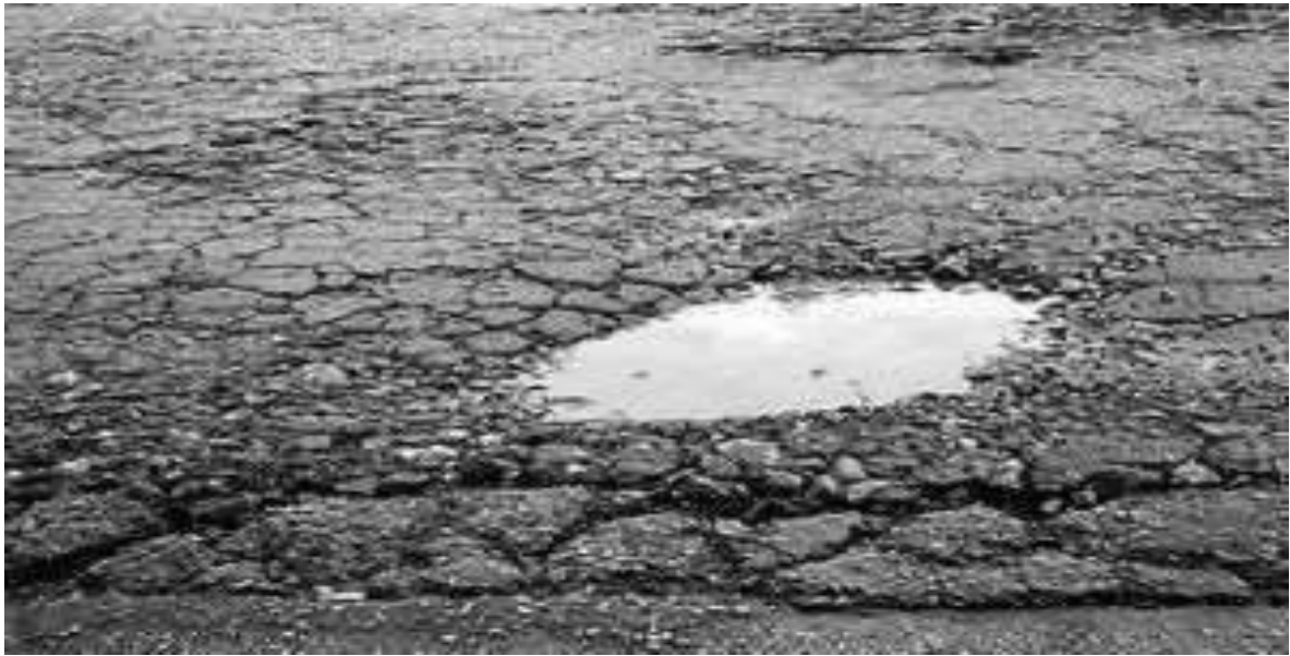
Figura 8. Desintegración del borde con nivel de gravedad alto. Tomado de (Arqhys, 2012)
