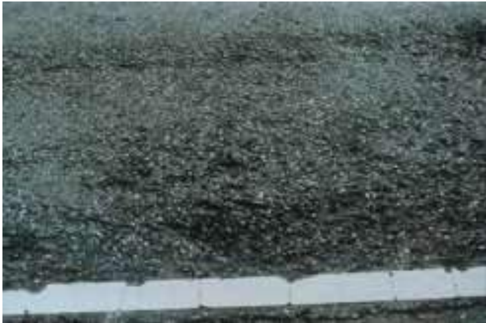
Figura 16. Perdida de agregados por desgaste. Tomado de (US Department of Transportation, 2014)
