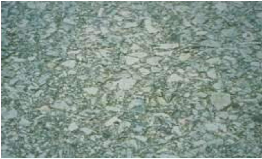
Figura 20. Pavimento con agregado grueso expuesto. Tomado de (US Department of Transportation, 2014)
