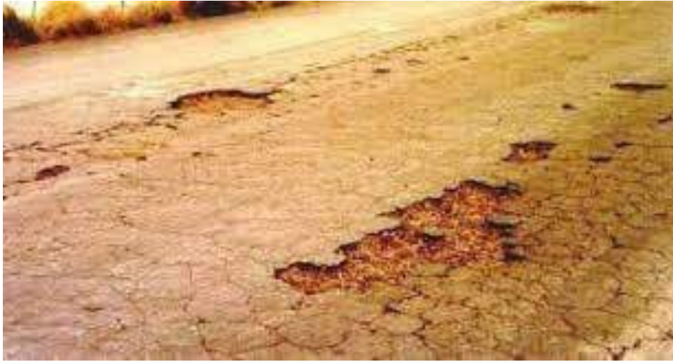
Figura 17. Descascaramiento. Tomado de (Ingeniería Salvador, 2009)
