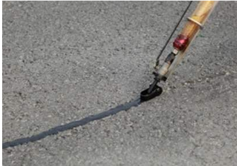
Figura 32. Sellador de grieta con emulsión asfáltica. Tomado de ( Asfaltos Brimax, 2020 )
