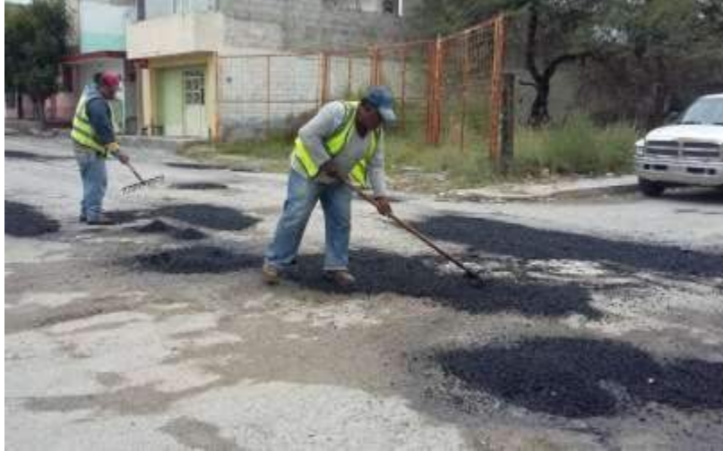
Figura 28. Aplicación de bacheo. Tomado de ( El Sol de San Luis , 2019)
