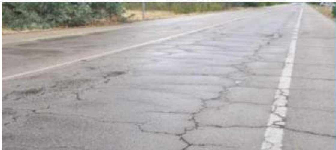
Figura 19. Falla longitudinal y transversal. Tomado de (Andrade, Hernández, & Salomón, 2020)
