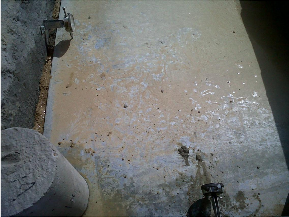
Deformímetros para lecturas de asentamiento.
