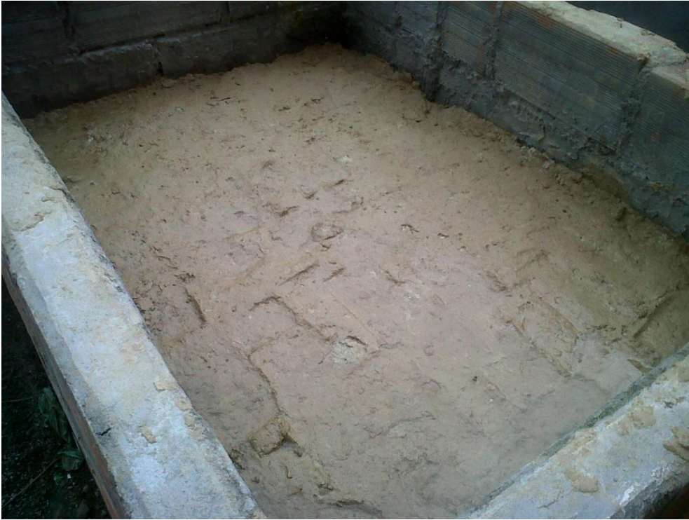
Última capa de 10 cm compactada.
