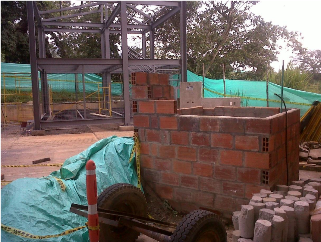
Cajón en mampostería que se usó para el modelo a escala.
