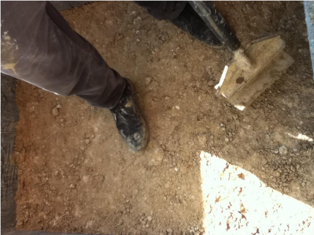
Compactando el material con su humedad óptima.
