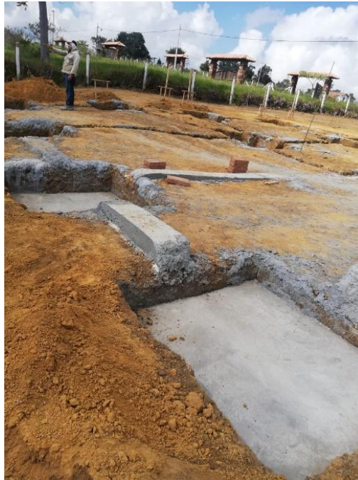
Ilustración 24. Solado para zapatas.
