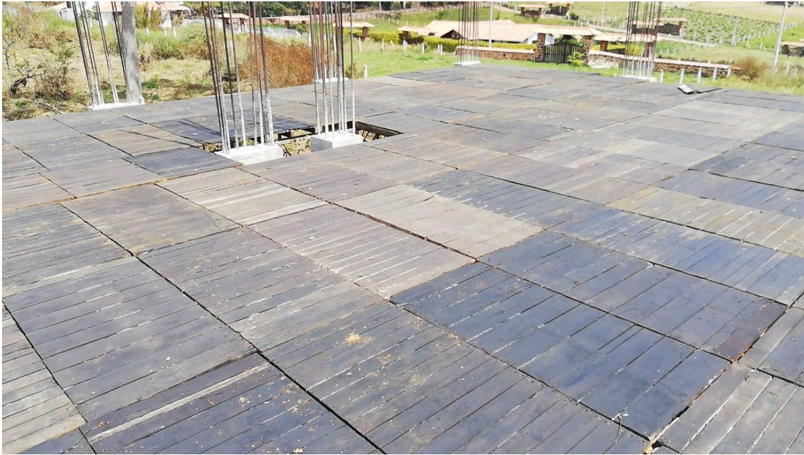
Ilustración 34. Tableros de placa aligerada.
