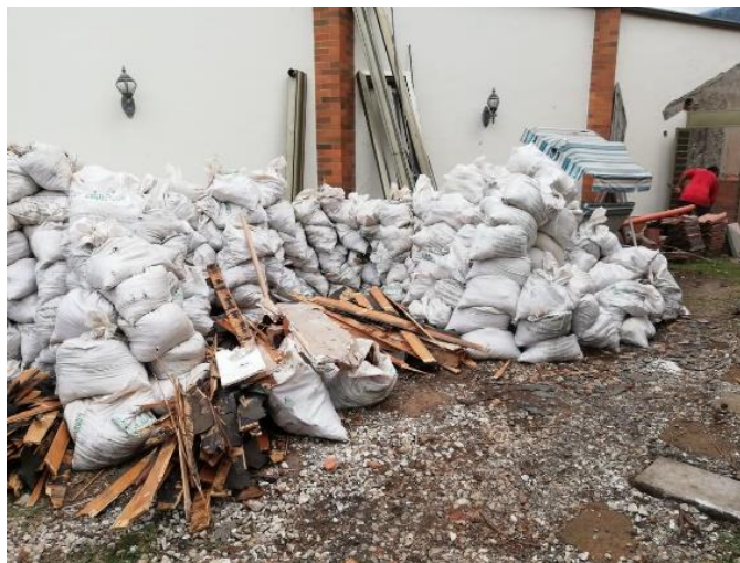
Ilustración 43. Retiro de escombros.
