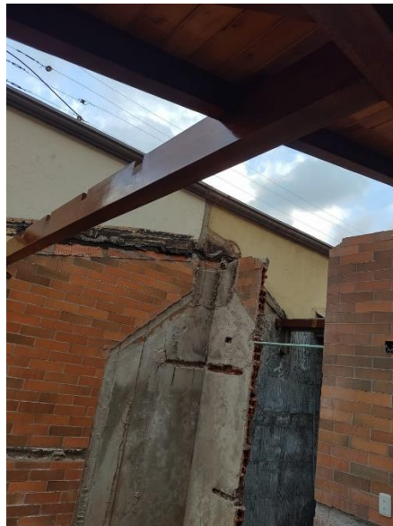
Ilustración 36. Desmonte de techos para zona bbq.
