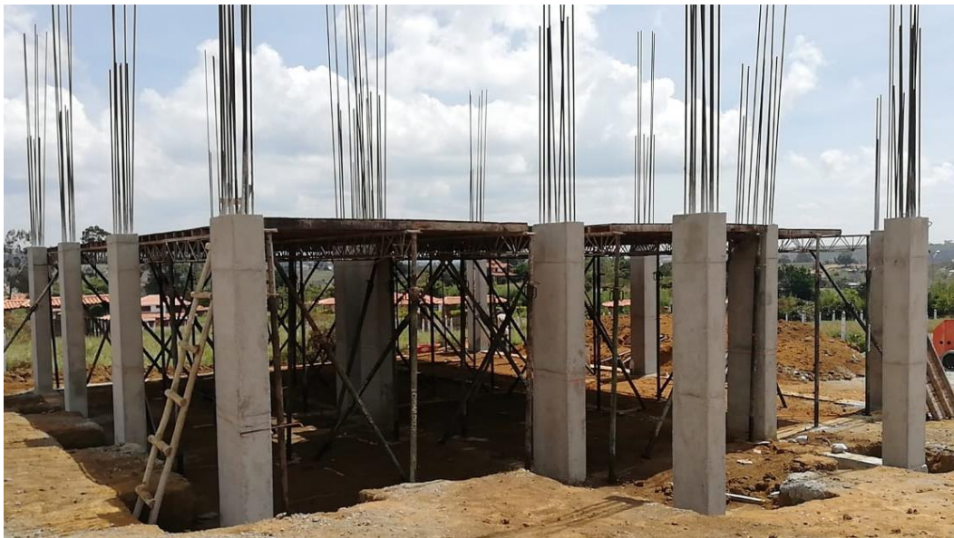
Ilustración 33. Formaleta de placa aligerada.
