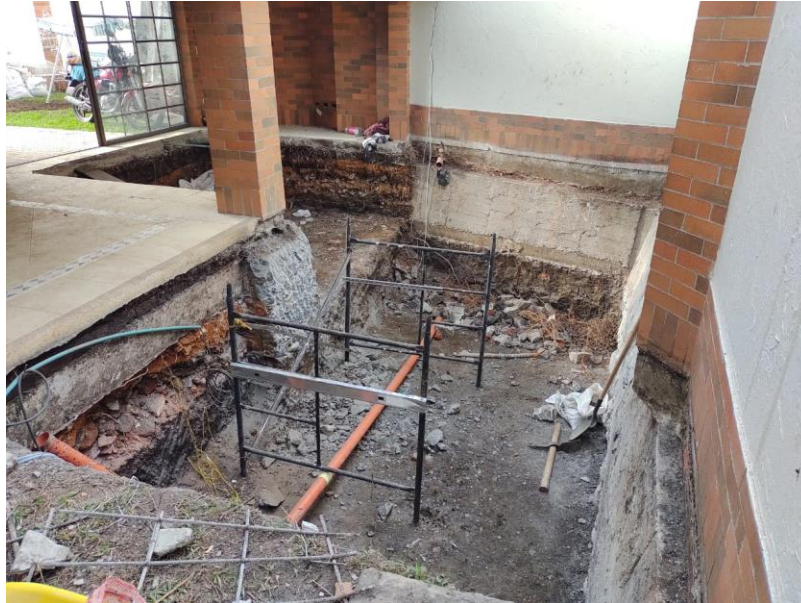
Ilustración 39. Excavaciones para piscina y jacuzzi.
