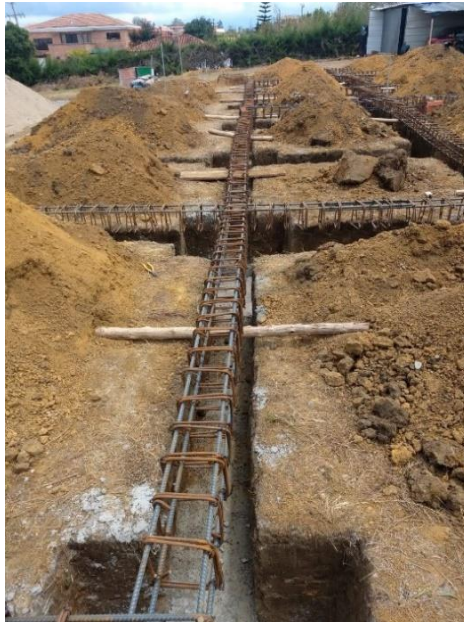
Ilustración 9. Armado de vigas y zapatas.
