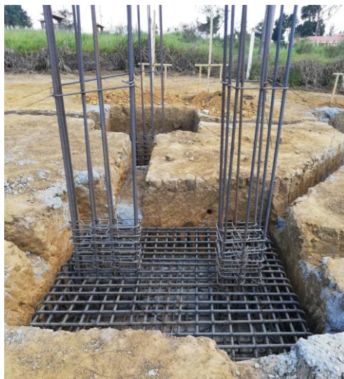
Ilustración 25. Armado de parrillas para zapatas.
