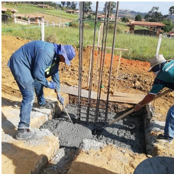
Ilustración 27. Fundida de zapatas.
