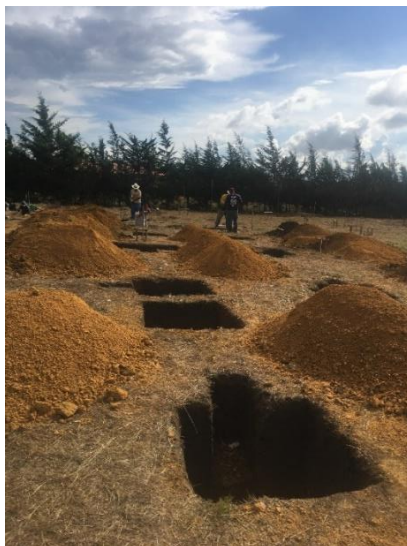
Ilustración 5. Inicio de excavaciones.
