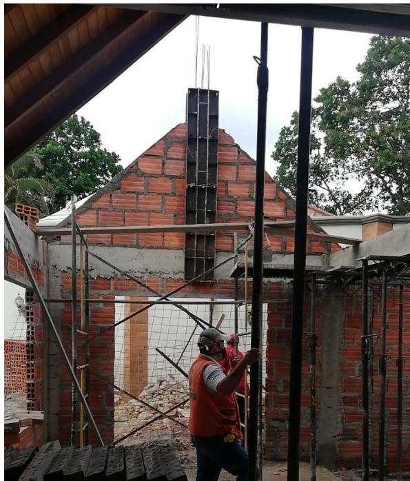
Ilustración 50. Fundida de vigas aéreas y columnas.
