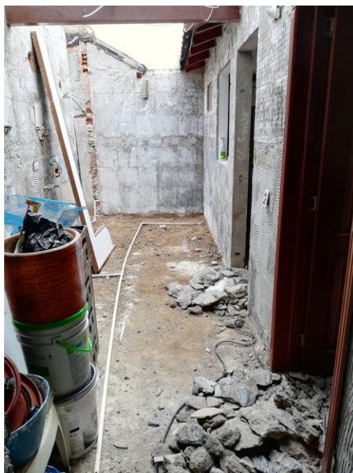
Ilustración 37. Retiro de pisos en zona de ropas.
