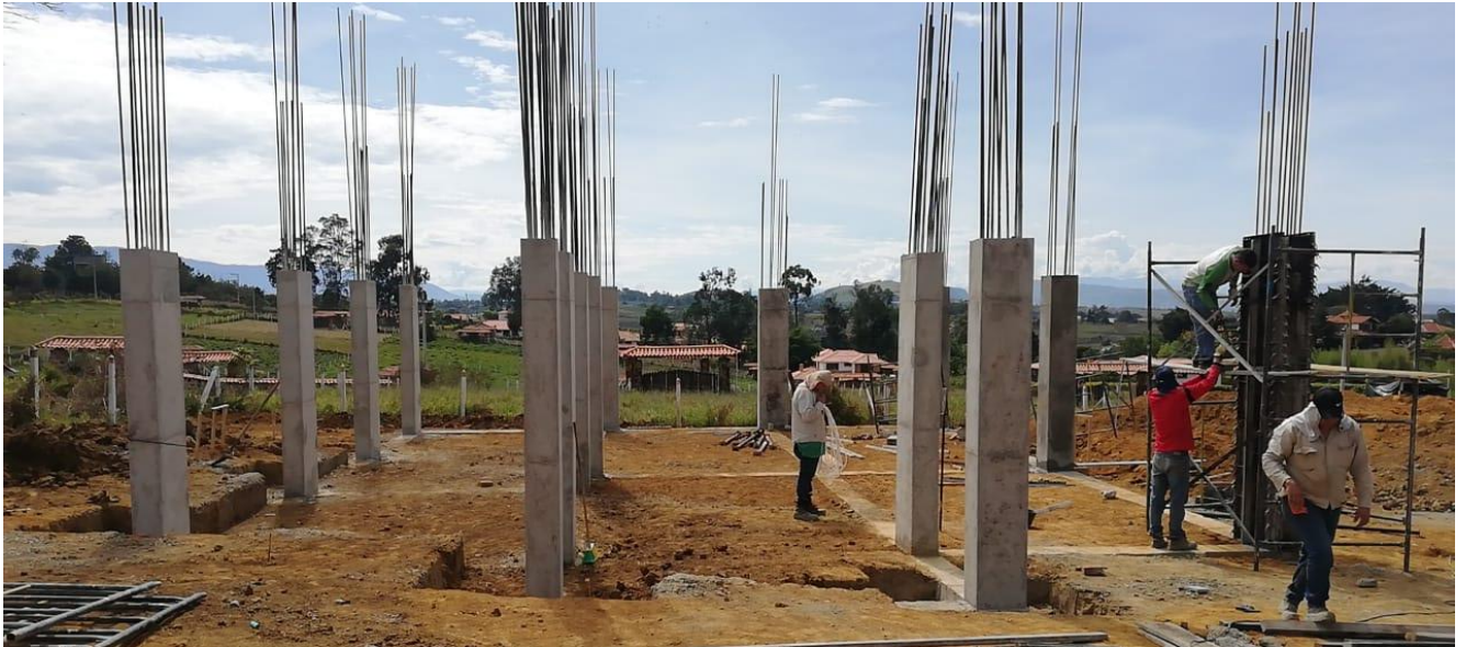
Ilustración 32. Columnas fundidas.
