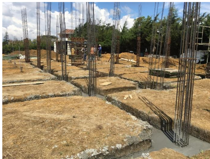
Ilustración 11. Fundida de vigas y zapatas.
