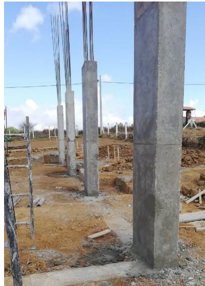
Ilustración 31. Columnas fundidas.
