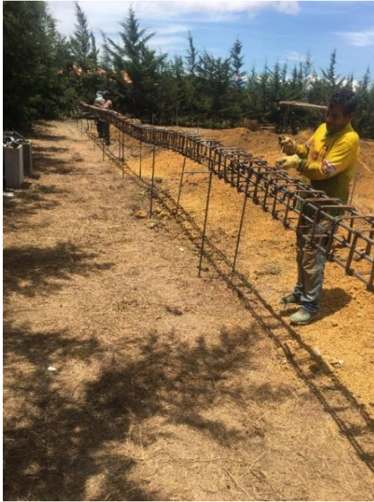
Ilustración 8. Figurado de acero.
