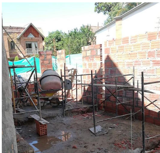
Ilustración 51. Mampostería para sala principal.
