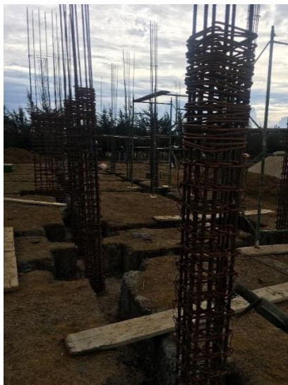
Ilustración 12. Estribos en columnas.
