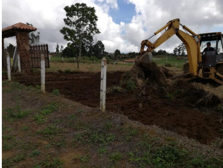
Ilustración 15. Descapote del lote.
