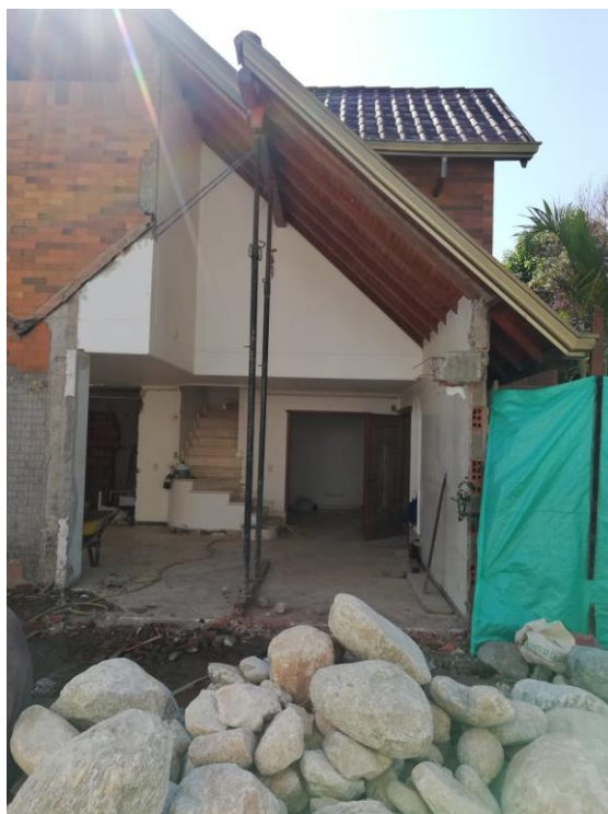
Ilustración 38. Demolición de muros en sala principal.
