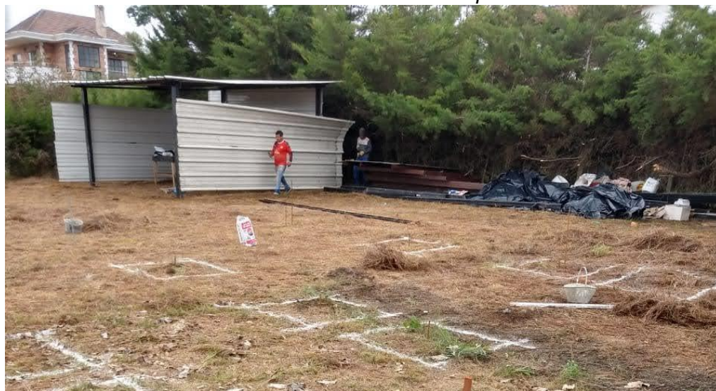
Ilustración 2. Adecuación de campamento
