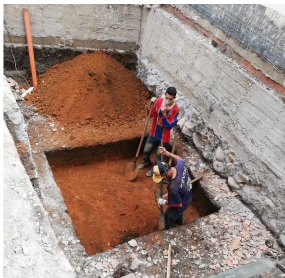
Ilustración 40. Excavación de cimentación.
