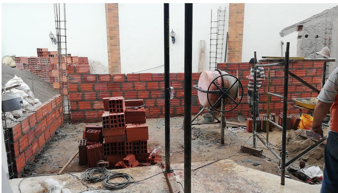
Ilustración 48. Armado de columnas
