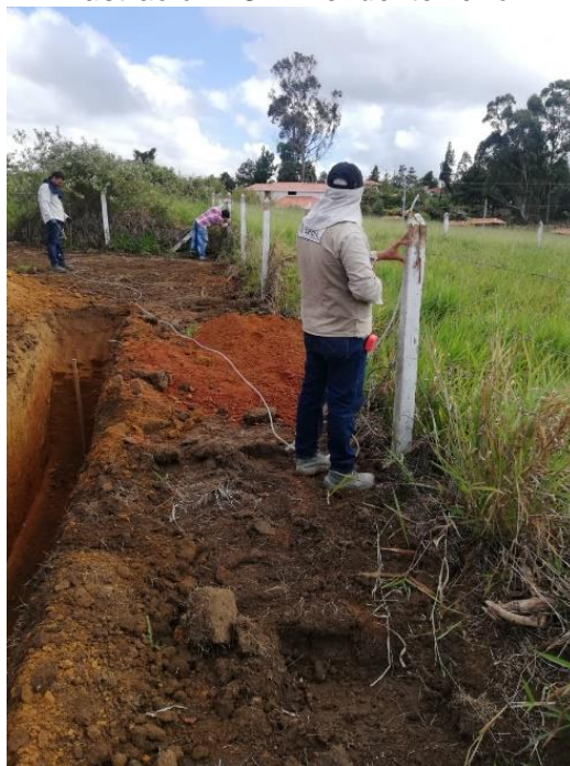
Ilustración 18. Nivel del terreno.
