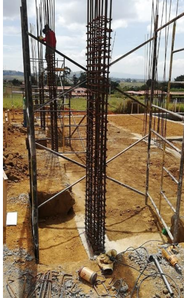
Ilustración 30. Armado de columnas.
