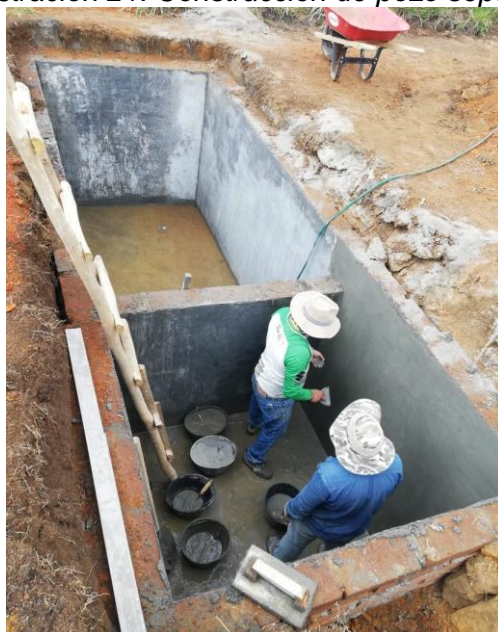
Ilustración 21. Construcción de pozo séptico.
