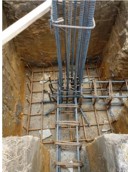
Ilustración 10. Armado de columnas.
