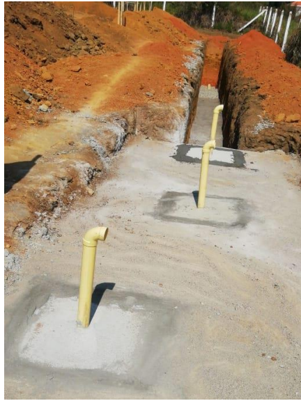
Ilustración 22. Pozo séptico.
