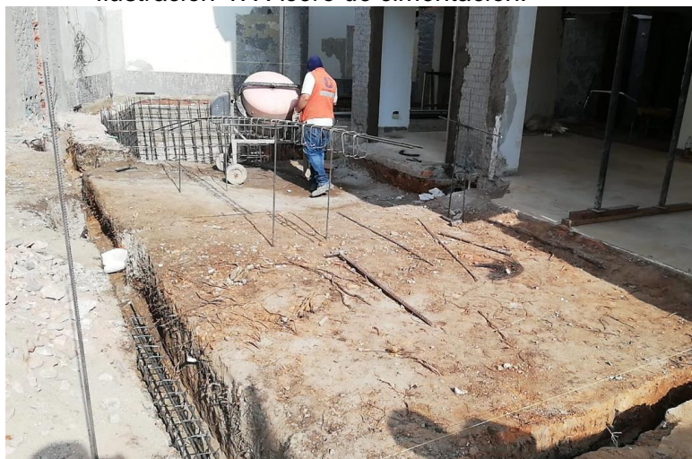
Ilustración 47. Acero de cimentación.
