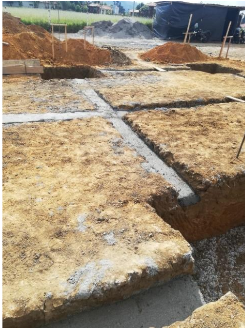
Ilustración 23. Solados para vigas de cimentación.
