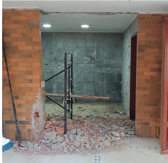
Ilustración 35. Demolición de enchapes de cocina.
