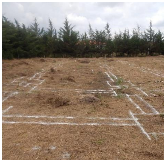
Ilustración 4. Replanteo de la cimentación de la casa.
