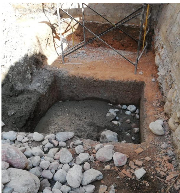
Ilustración 44. Concreto ciclópeo para cimentación.
