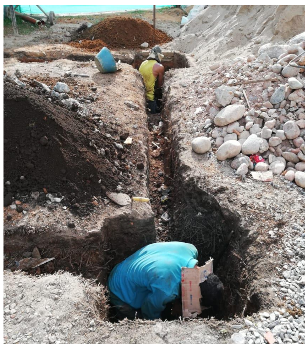
Ilustración 42. Excavaciones para cimentación de sala principal.
