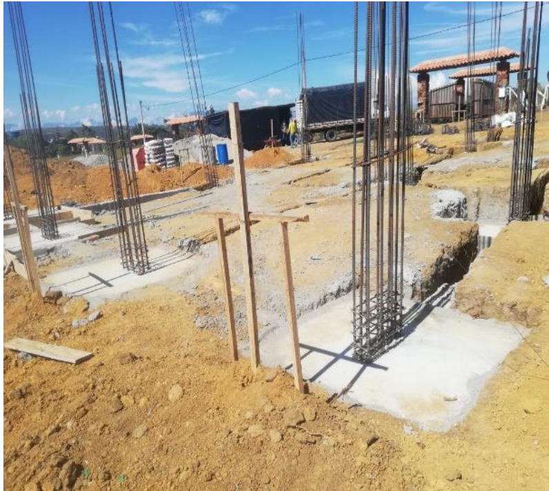
Ilustración 28. Zapatas fundidas.
