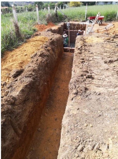
Ilustración 20. Construcción de pozo séptico.
