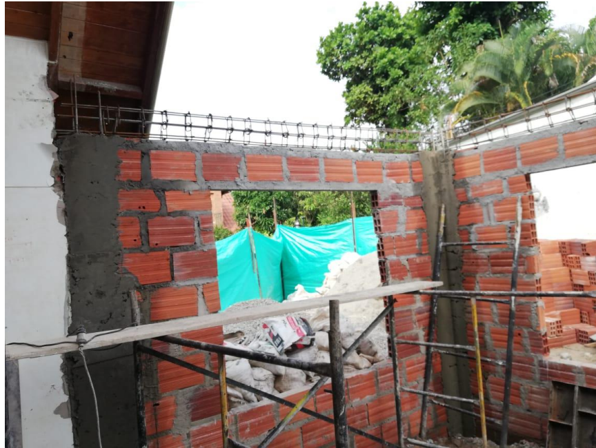
Ilustración 49. Armado de vigas aéreas.
