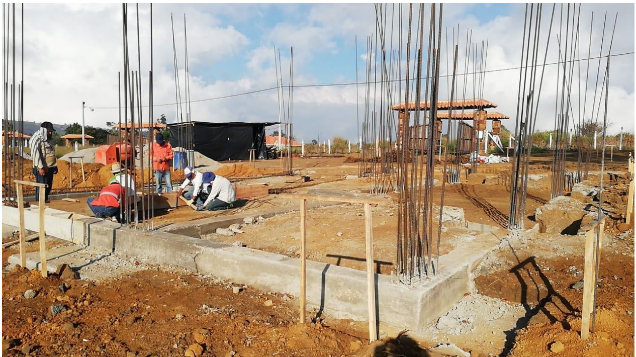
Ilustración 29. Vigas fundidas.
