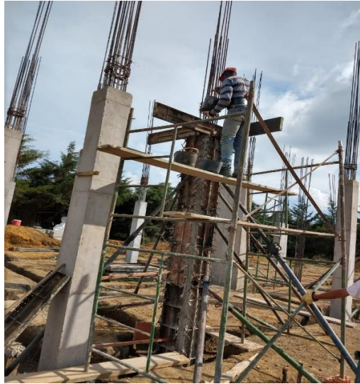
Ilustración 14. Columnas fundidas.
