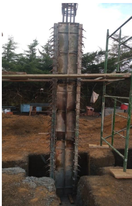
Ilustración 13. Formaleta para fundir columna.
