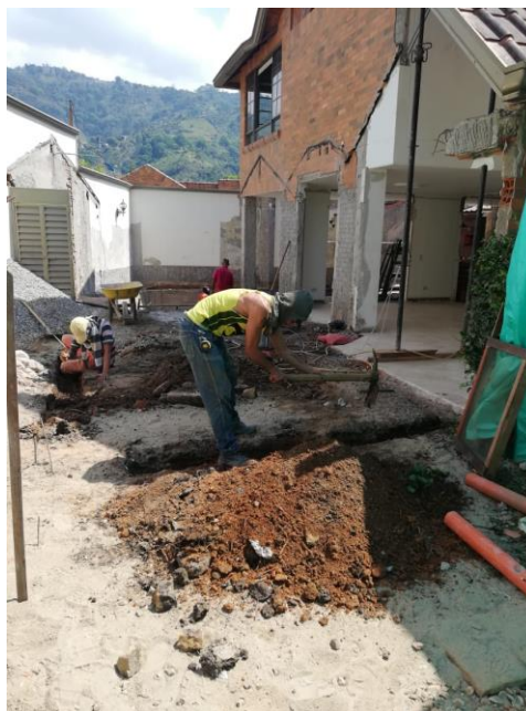
Ilustración 41. Excavaciones para cimentación de la sala.
