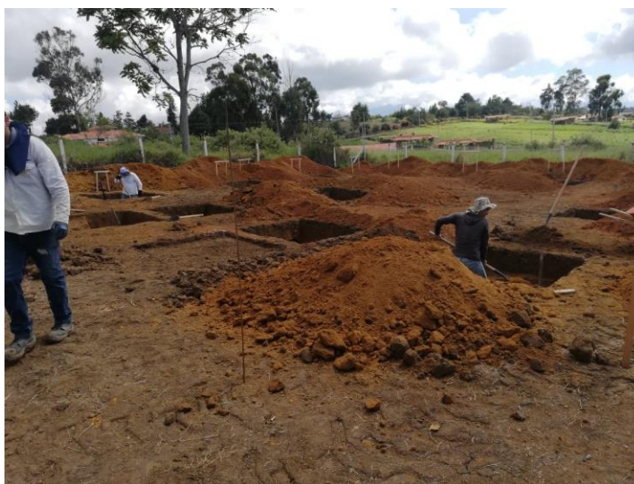
Ilustración 19. Excavación de zapatas de cimentación.
