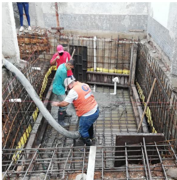
Ilustración 52. Fundida de piso de piscina.
