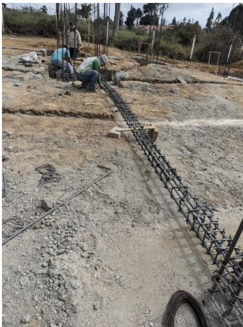
Ilustración 26. Armado de vigas de cimentación.
