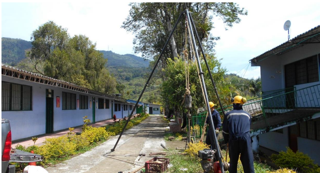
Imagen 26. Ejecución de ensayo SPT
