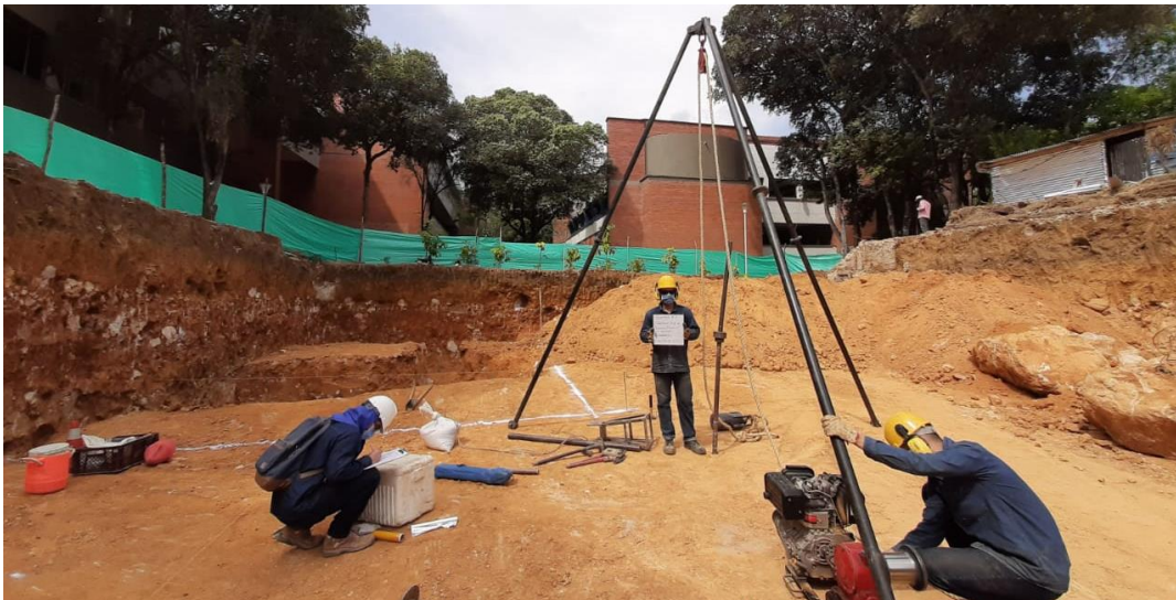
Imagen 30. Ejecución de ensayo de campo SPT
