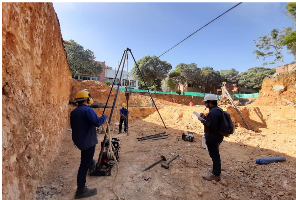
Imagen 10. Ejecución de ensayo SPT sobre el área de interés.
