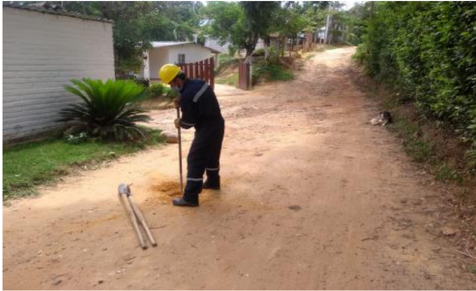
Imagen 12. Ejecución de apiques para el estudio.
