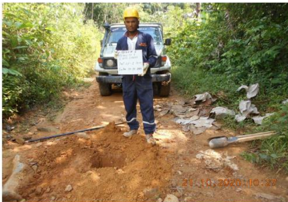
Imagen 4. Ejecución de Apiques sobre el tramo vial.
