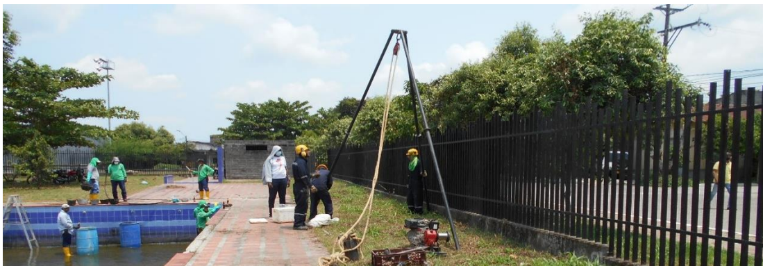
Imagen 24. Ejecución de ensayo SPT
