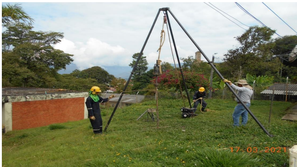
Imagen 28. Ejecución de ensayo SPT
