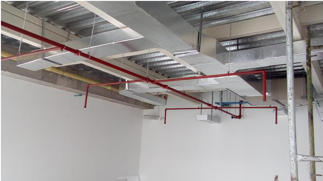
Fuente: Proecons S.A.S Reforma oficina 1005
