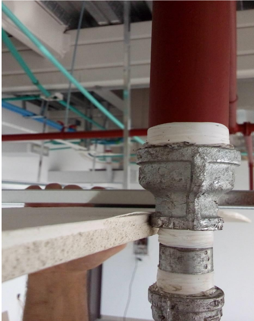
Figura 7 Correspondiente a Etapa 2, Montura de la reducción Copa de 1" a ½"
