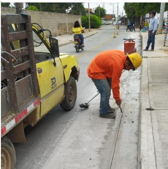
Imagen 32. Limpieza de juntas para instalación de cordón.
