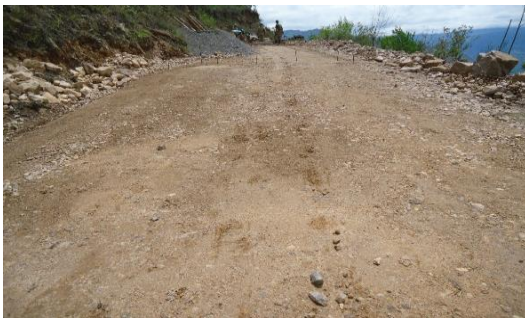
Figura 8 Compactación del afirmado
