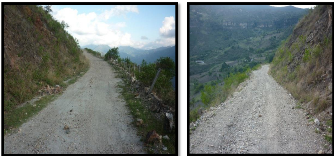
Figura 1 K0+000 vía Buraga-Macaravita vista frente y posterior
