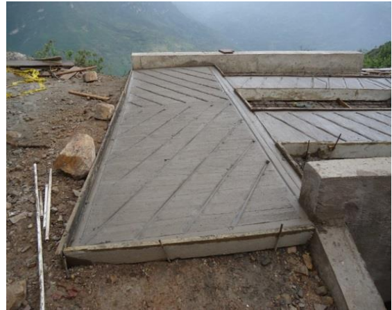
Figura 17 Estructura de entrada al K0+000
