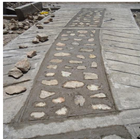
Figura 21 Concreto clase G para relleno entre
