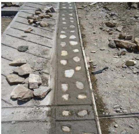
Figura 20 Concreto clase G para sobre anchos
