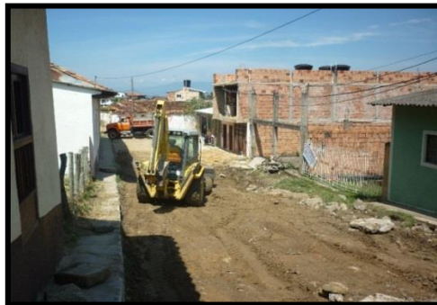
Figura 3 Proceso demolición y retiro del pavimento
