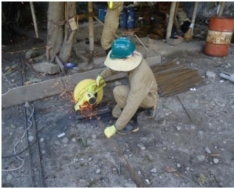
Figura 24 Corte de acero según diseños
