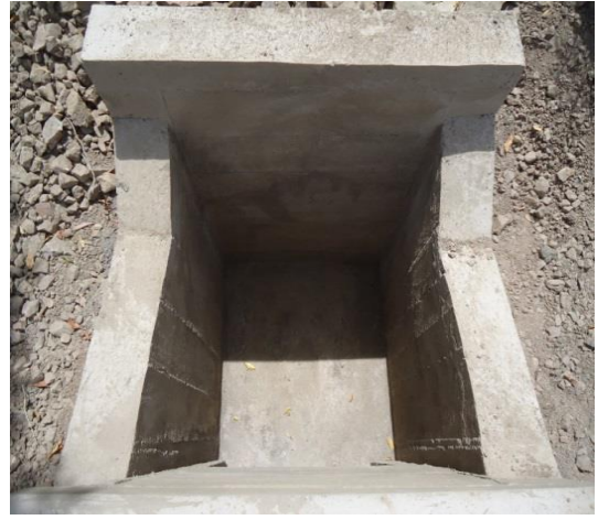
Figura 13 Concreto clase G para poceta
