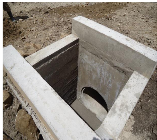
Figura 11 Poceta de entrada de la alcantarilla
