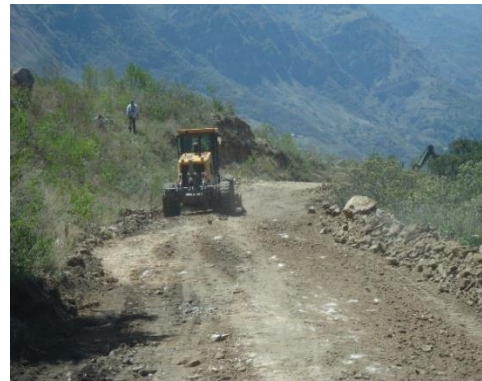
Figura 15 Nivelación del material de afirmado
