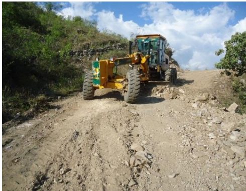
Figura 14 Extendido del material de afirmado
