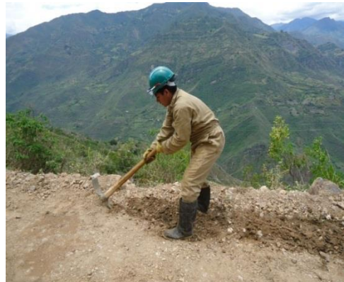
Figura 27 Excavación para cuneta
