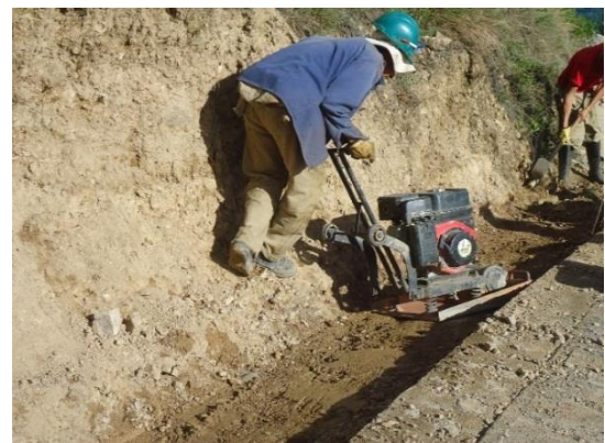
Figura 33 Compactación de zanja
