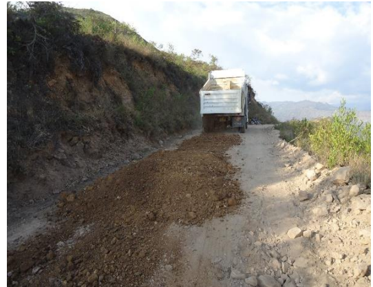
Figura 7 Descargue del material de afirmado
