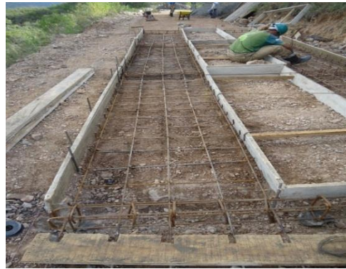
Figura 25 Amarre de aceros para placa huellas
