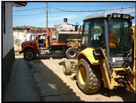
Figura 4 Carga y retiro de escombros.
