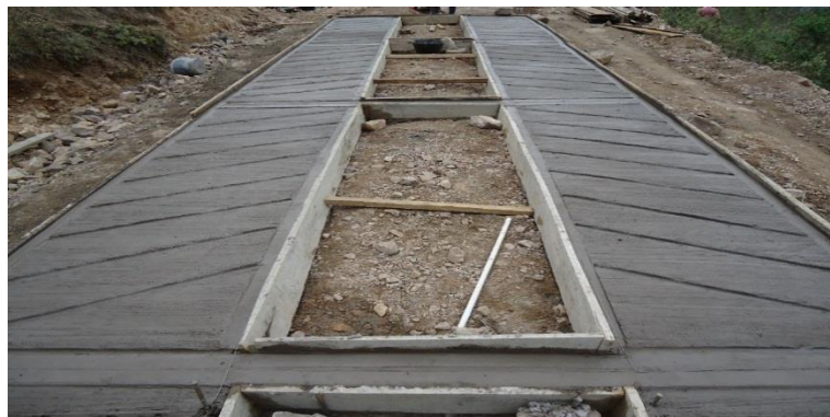
Figura 16 Concreto clase D para placa huellas
