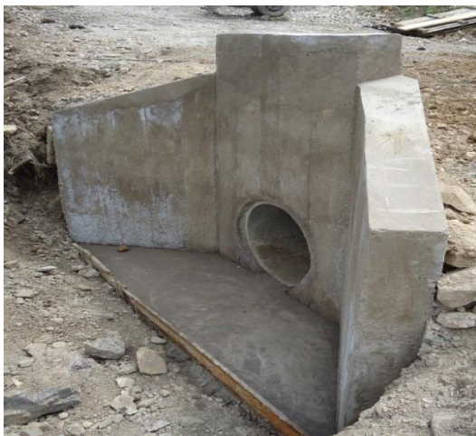
Figura 10 Cabezote de salida de la alcantarilla
