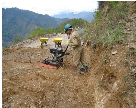
Figura 29 Compactación de afirmado
