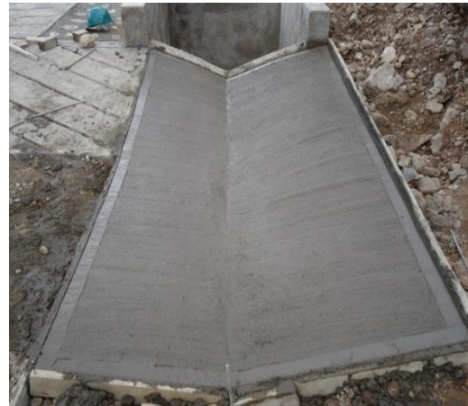
Figura 23 Concreto clase D para cuneta
