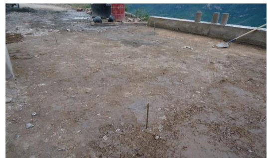
Figura 9 Nivelación de la rasante con el afirmado
