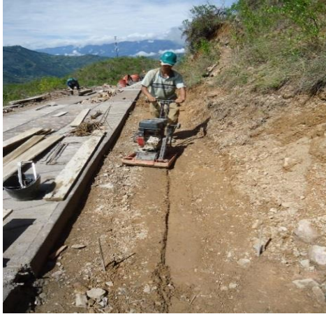
Figura 28 Compactación de relleno para cunetas
