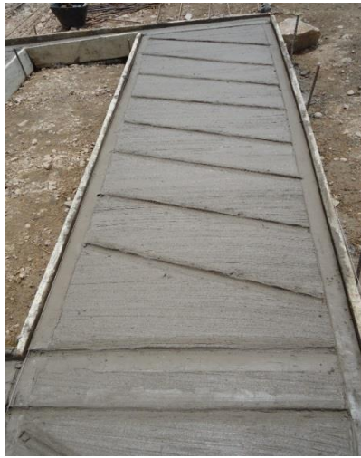
Figura 18 Espina de pescado para desagües
