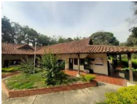
Ilustración 12 CASONA-Actual ubicación del laboratorio. Tomada en visita técnica a la planta.
