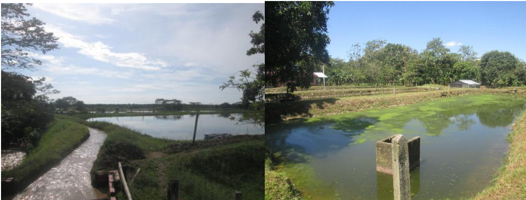
Foto A3-2. Estructuras hidráulicas. Año: 2025. Área: Entradas y salidas de agua. Descripción: Documentar la infraestructura hidráulica responsable del manejo de caudales y circulación del agua dentro del sistema.
