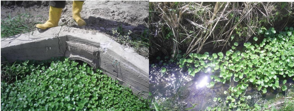
Foto A3-8. Lodos, sedimentadores o filtros. Año: 2025. Área: Sistema de manejo de efluentes Descripción: Evidenciar prácticas de gestión ambiental relacionadas con el tratamiento de lodos y control de descargas.
