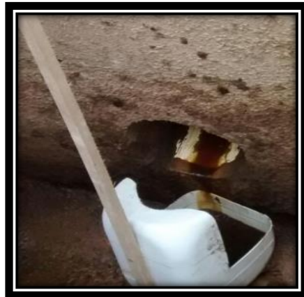
Toma de Muestra Caja de inspección de la Sección de Corrales
