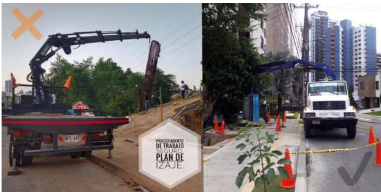
Figura 24. Evidencia en el procedimiento de trabajo seguro para izaje de cargas
