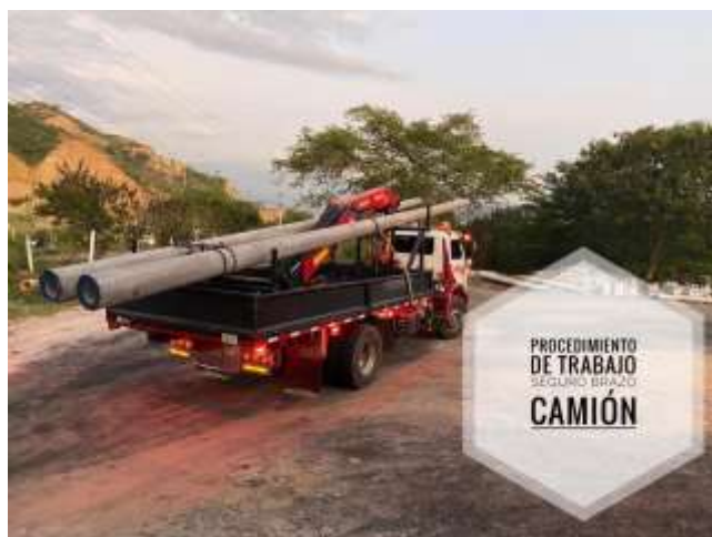
Figura 22. Procedimiento izaje de carga (Poste de concreto)
