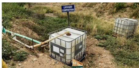
Almacenamiento de lixiviados de la compostera
