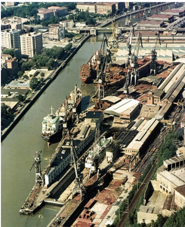
Ilustración 9 El Astillero Euskalduna antes de la demolición. Fotografía de 20/06/1975.
