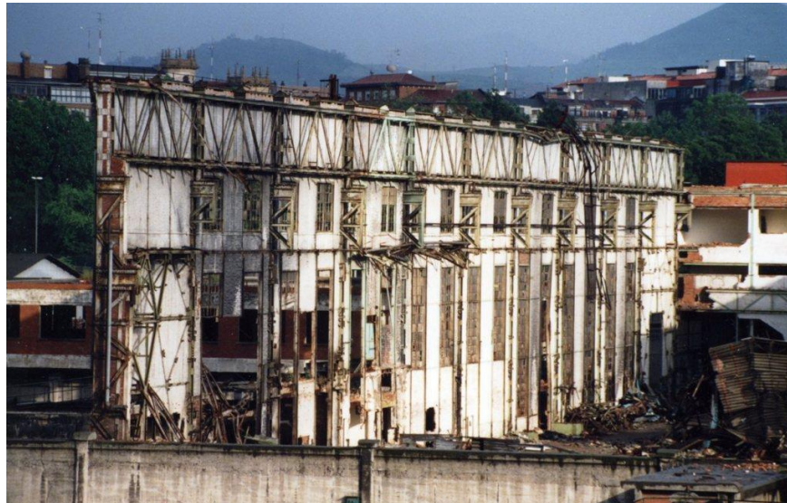
Ilustración 10 Las instalaciones de la Compañía Euskalduna durante los procesos de derribo en 1992 / Foto: Joaquín Cárcamo.
