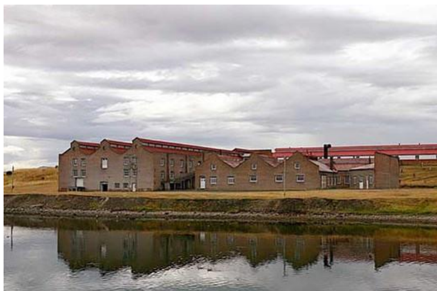
Ilustración 4 Frigorífico Bories, Patrimonio Industrial Chileno, Hoy Hotel cinco estrellas
