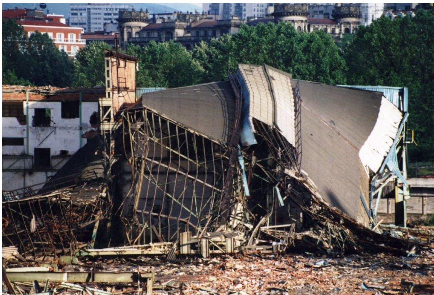
Ilustración 11 Las instalaciones de la Compañía Euskalduna durante los procesos de derribo en 1992 / Foto: Joaquín Cárcamo.
