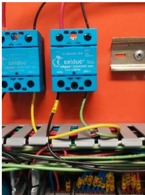
Figura 42. SSR instalado
