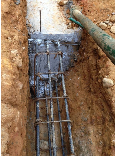
Foto 16 Aplicación de SIKA DURE 32 para empalmar concreto viejo con concreto nuevo y tratar juntas frías.
