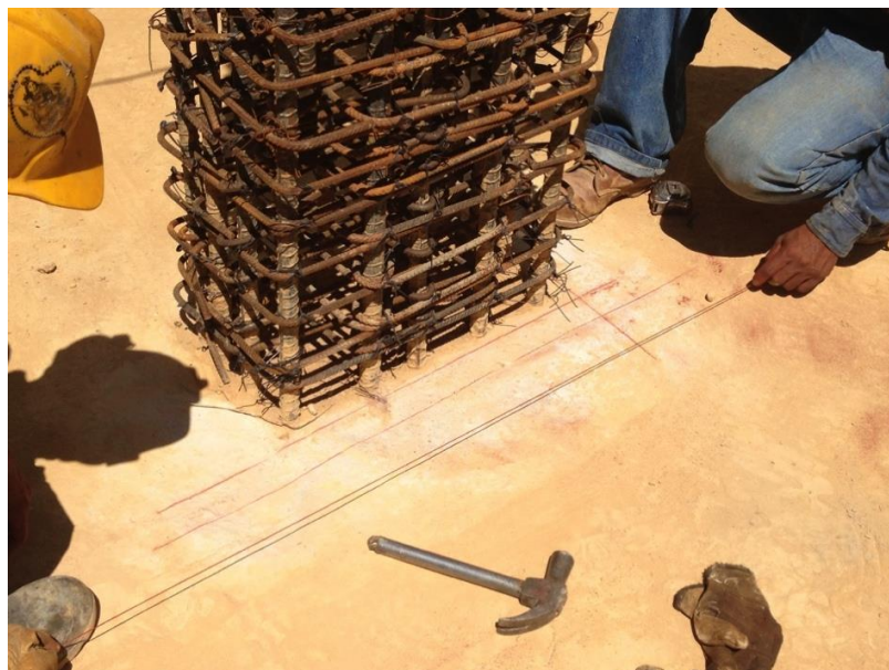
Foto 82 Cimbrado de la sección de la formaleta, la sección de concreto y línea de referencia.
