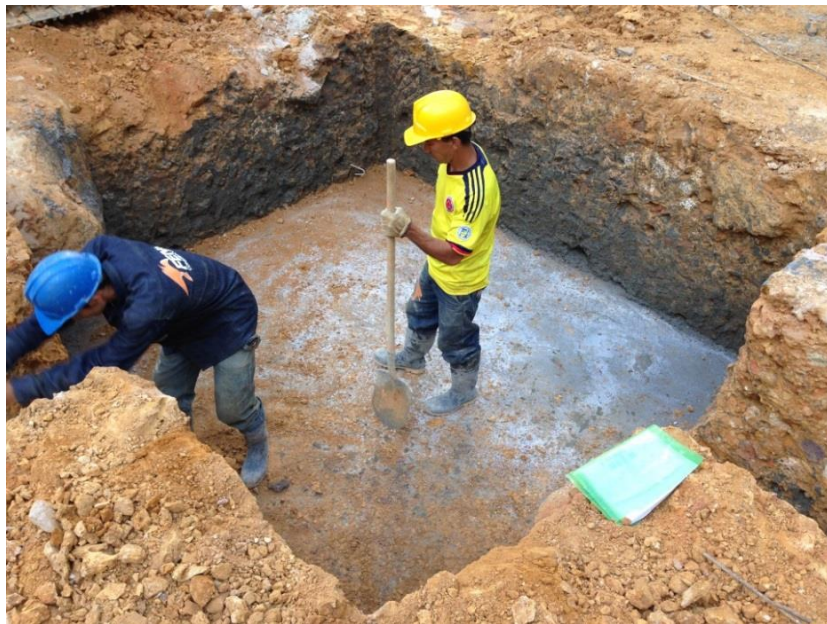
Foto 12 Terminado del concreto ciclópeo.
