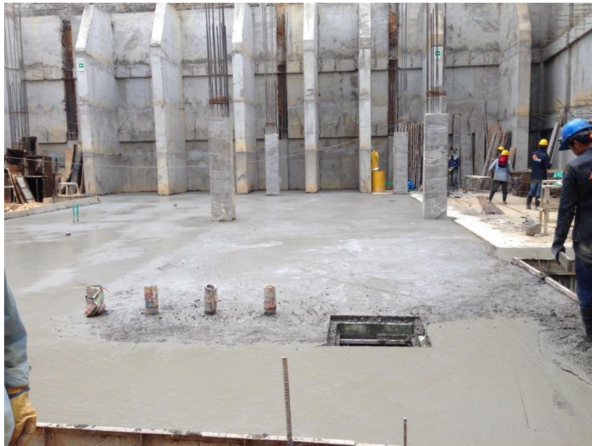
Foto 51 Aspecto final de la tapa del tanque.
