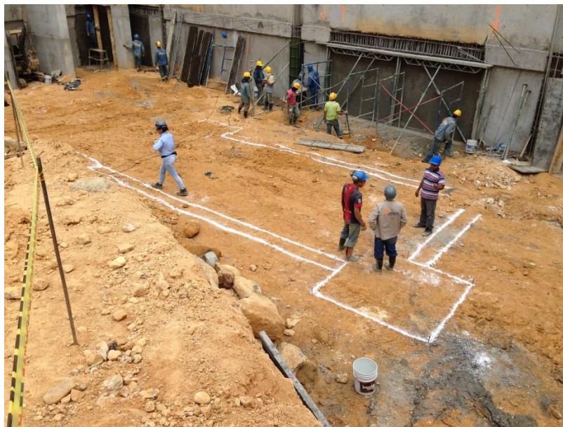
Foto 30 Demarcación del tanque y la cimentación próxima con cal.
