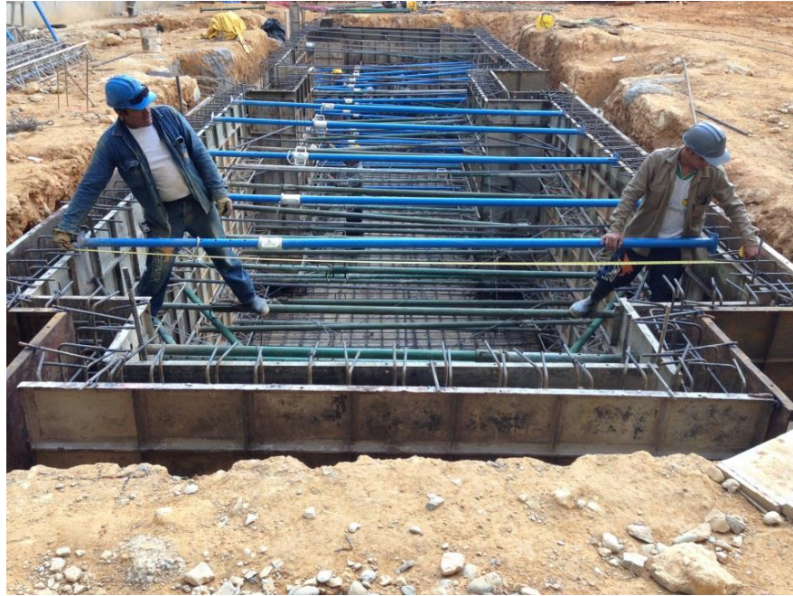
Foto 42 Encofrado y retrancado del tanque.
