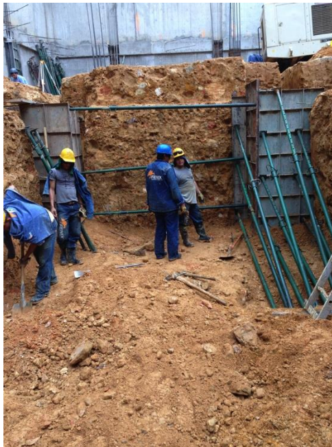
Foto 32 Encofrado para el vaciado del concreto ciclópeo de las zapatas del costado oriental.
