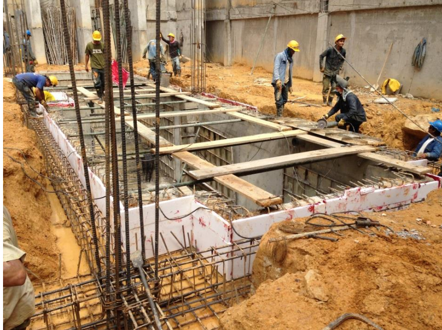
Foto 44 Armado de las vigas de amarre, zapatas y arranques de columnas perimetrales al tanque.
