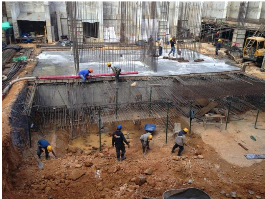
Foto 71 Ejecución del primer tramo o junta vertical de construcción.
