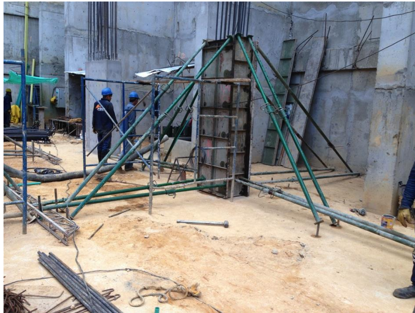
Foto 85 Columna encofrada, aplomada y retrancada, dispuesta para el vaciado.
