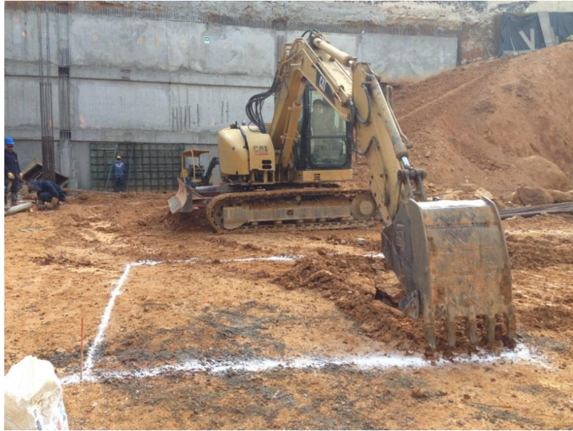
Foto 9 Excavación mecánica (Retro excavadora) de la zanja.
