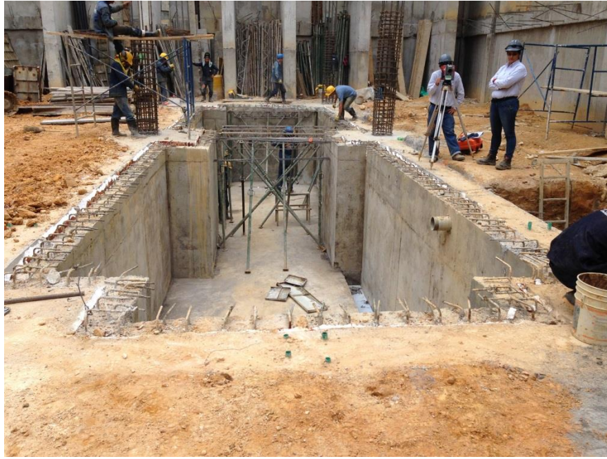
Foto 46 Aspecto final vaciado de elementos perimetrales al tanque.
