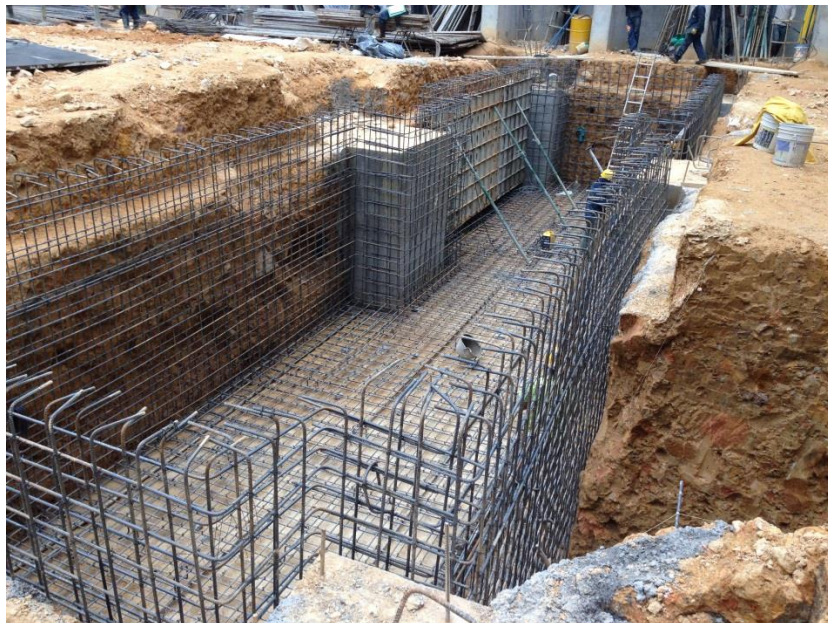
Foto 40 Armado parrilla interior tanque.
