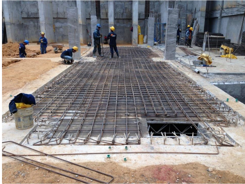
Foto 50 Armado parrilla inferior y superior de la tapa del tanque.
