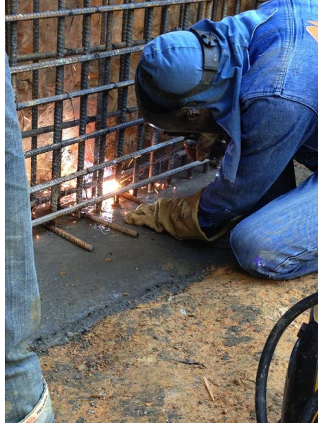
Foto 26 Instalación de soldadura para apoyar la formaleta metálica de las pantallas.
