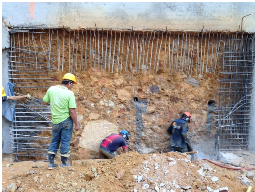
Foto 22 Excavación y armado acero viga cimienta muro.
