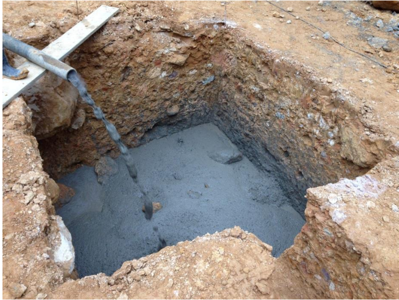
Foto 11 Concreto ciclópeo (60% concreto- 40% piedra rajón).
