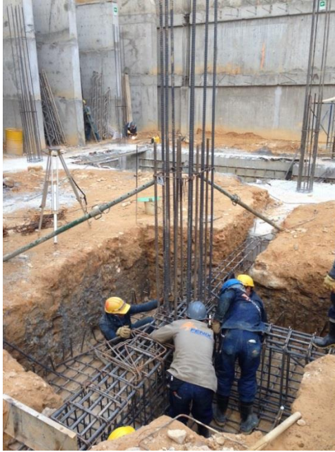
Foto 15 Acero longitudinal de la columna T-7.
