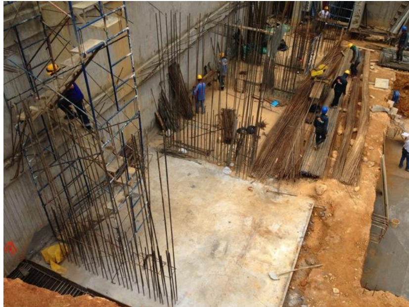
Foto 69 Aspecto actual (hasta el tercer tramo) de la losa de cimentación PC-2.
