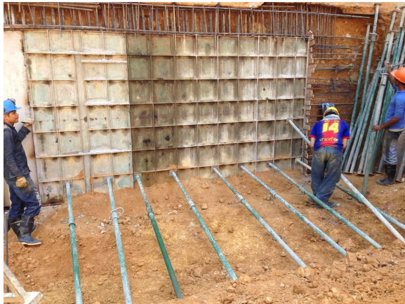
Foto 27 Retrancado de la formaleta metálica, mediante el uso de trincheras en el suelo.
