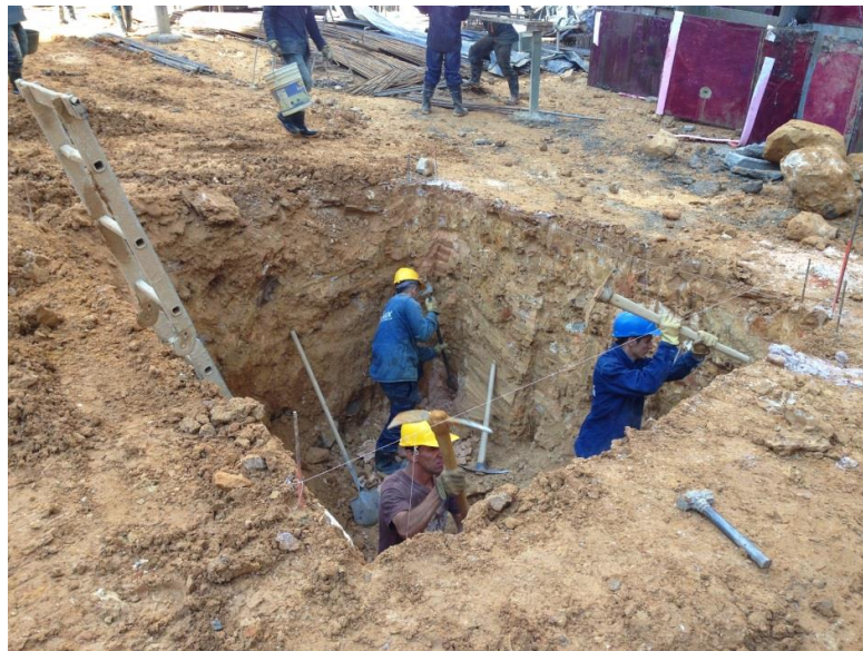
Foto 10 Excavación manual y perfilada del terreno (verificación de dimensiones).
