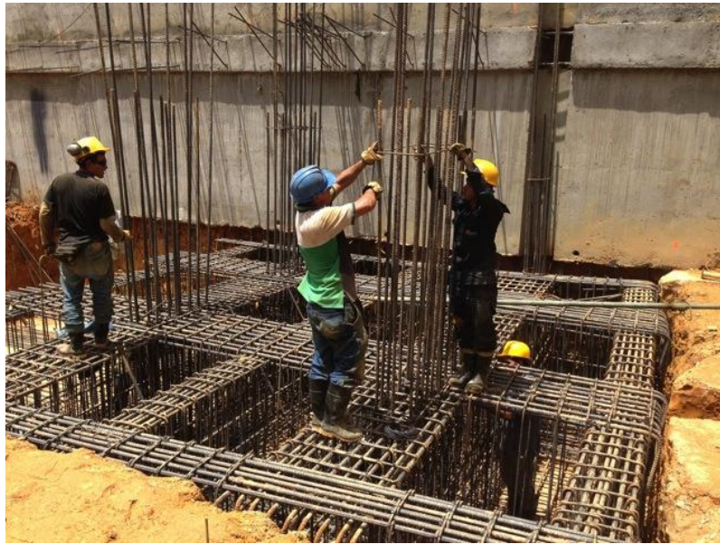
Foto 61 Introducción de arranques para columnas o pantallas ubicadas en el tramo de losa de cimentación.
