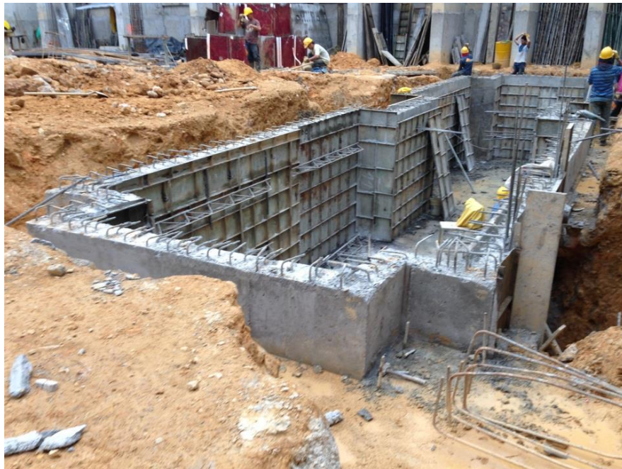
Foto 43 Aspecto final tanque subterráneo.
