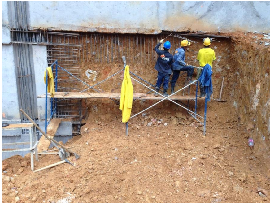
Foto 18 Rectificación de los aceros de las pantallas previamente fundidas.
