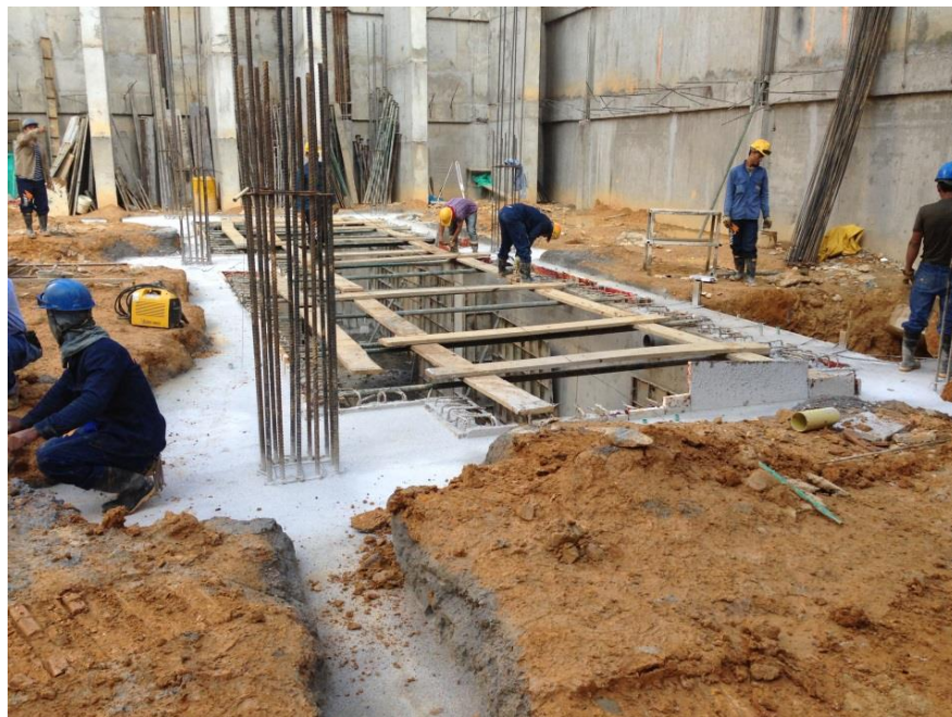
Foto 45 Aspecto final vaciado de elementos perimetrales al tanque.
