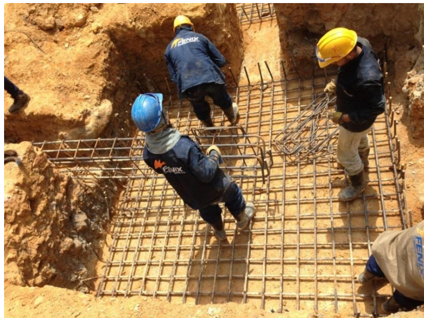
Foto 14 Armado de vigas de amarre perimetrales.
