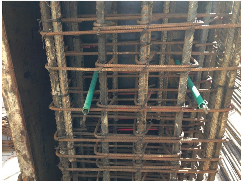
Foto 83 Bujes plásticos y tornillos que aseguran la sección del elemento.
