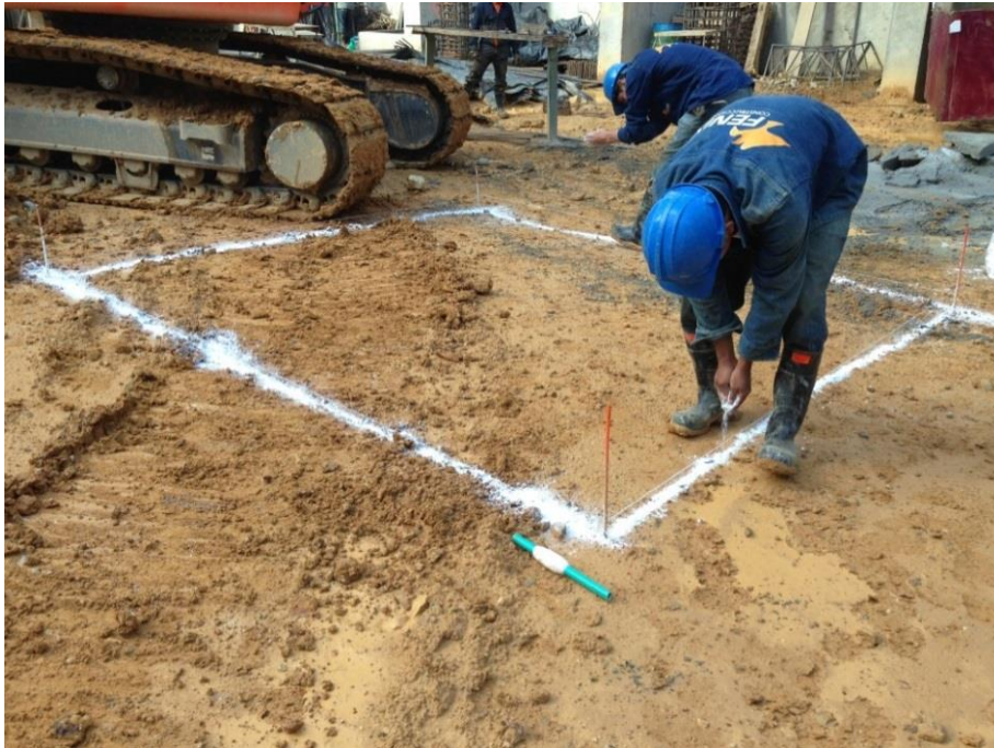
Foto 8 Demarcación con cal de la zapata D-6 (2.90m x 3.10m x 1.0m).
