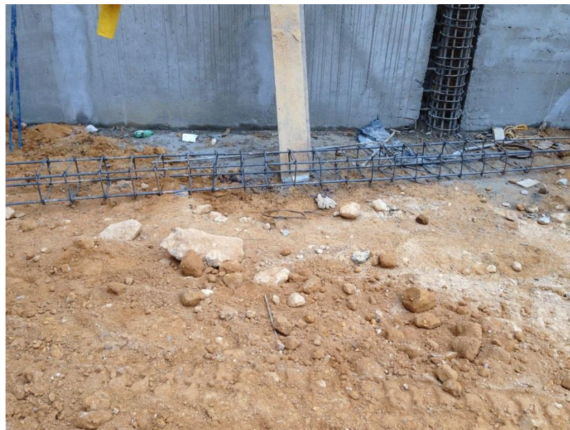
Foto 23 Viga superior armada en el exterior.
