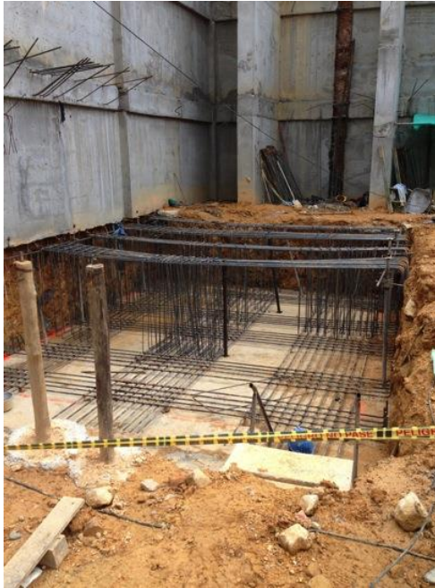
Foto 57 Introducción de acero longitudinal superior y estribos de viguetas y vigas cimiento en una dirección.
