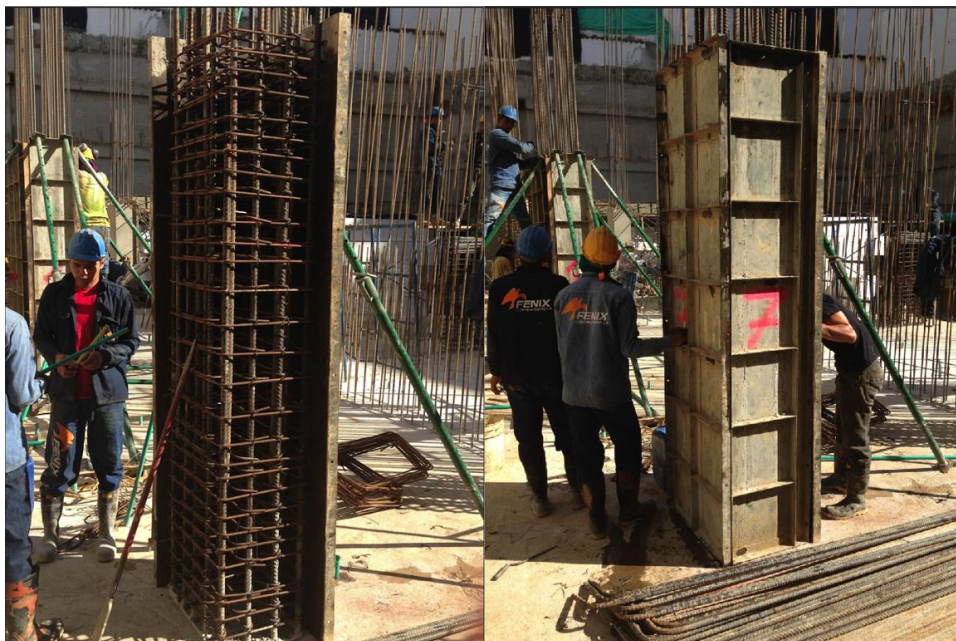
Foto 84 Formaleta metálica utilizada para encofrar columnas o pantallas.
