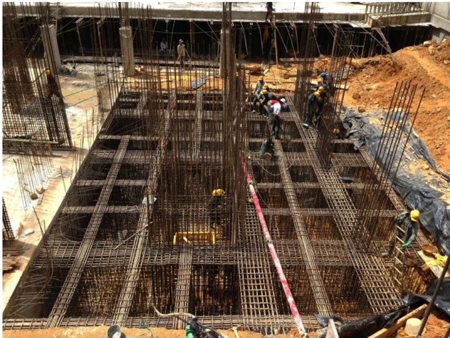
Foto 73 Armado del acero de refuerzo segundo tramo o junta vertical de construcción.
