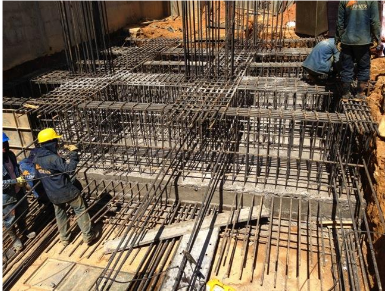
Foto 63 Terminado de la primera junta horizontal de construcción (placa inferior).
