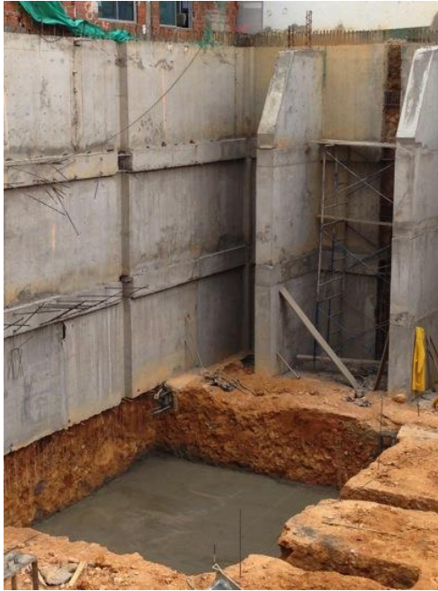
Foto 53 Limpieza de la superficie mediante la aplicación del solado (0.05m).
