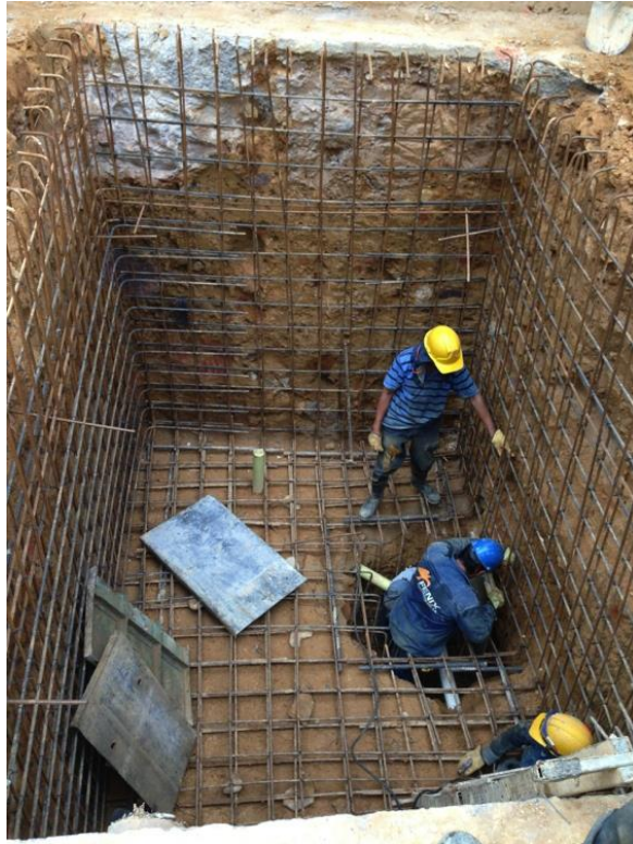
Foto 48 Armado de la parrilla interior y exterior del cuarto de máquinas.
