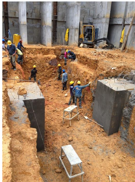
Foto 36 Aspecto final del concreto ciclópeo de las zapatas centrales.
