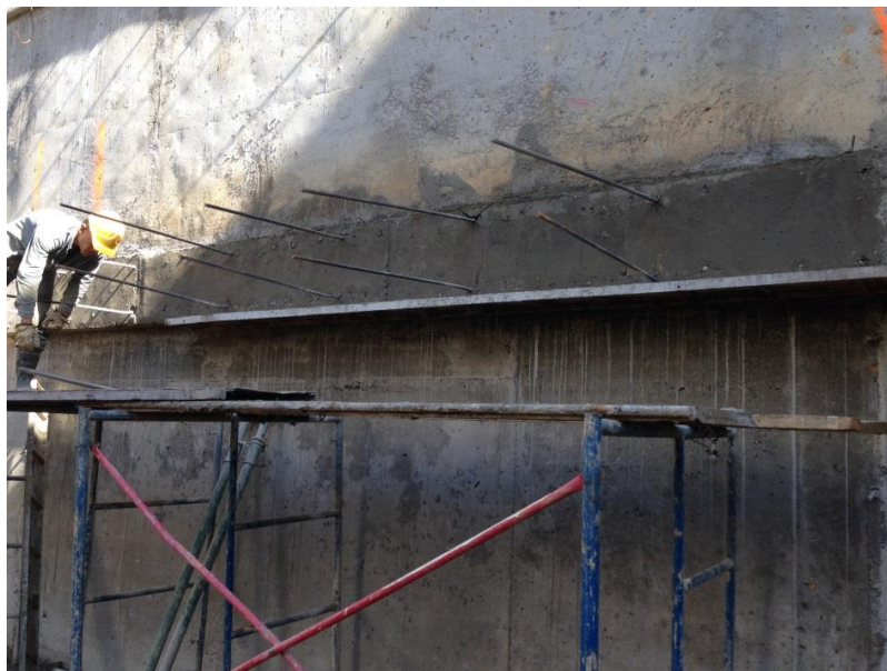
Foto 29 Detalle del acero de refuerzo para las viguetas y acabado de la viga superior.
