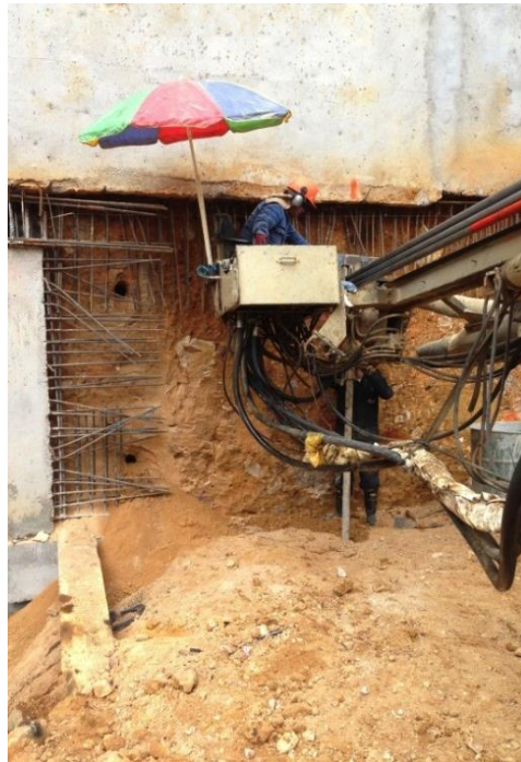
Foto 20 Perforaciones de los anclajes pasivos.
