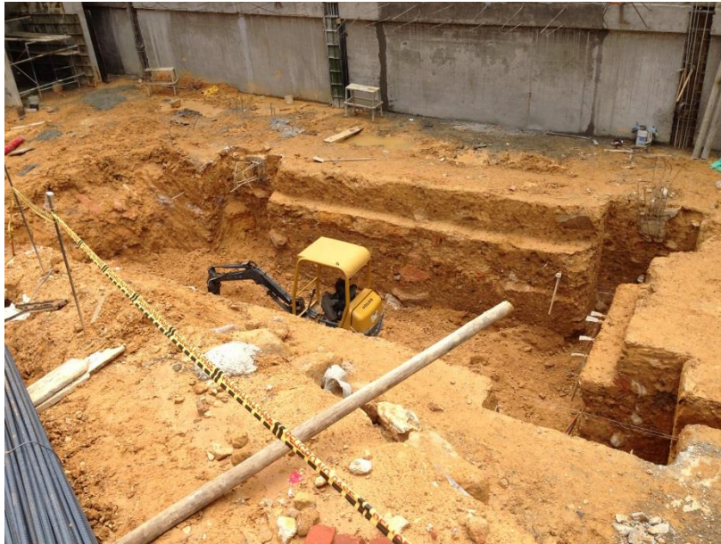
Foto 31 Excavación mecánica del tanque subterráneo con la mini-excavadora Volvo EC 20B.
