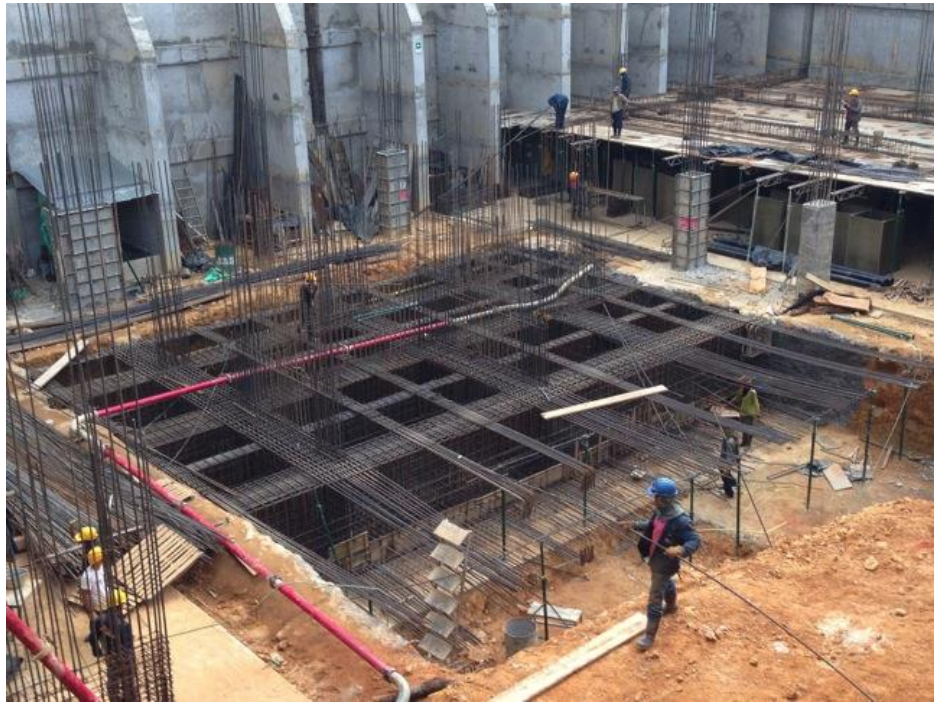
Foto 70 Armado del acero de refuerzo hasta el primer tramo o junta vertical de construcción.
