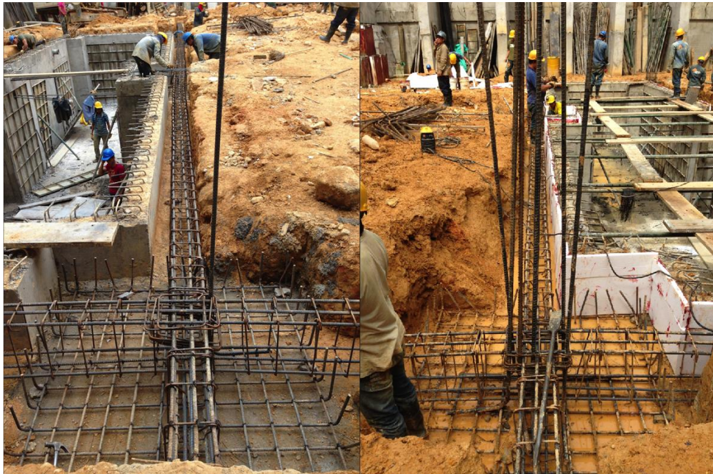
Foto 78 Introducción del acero longitudinal de la columna.
