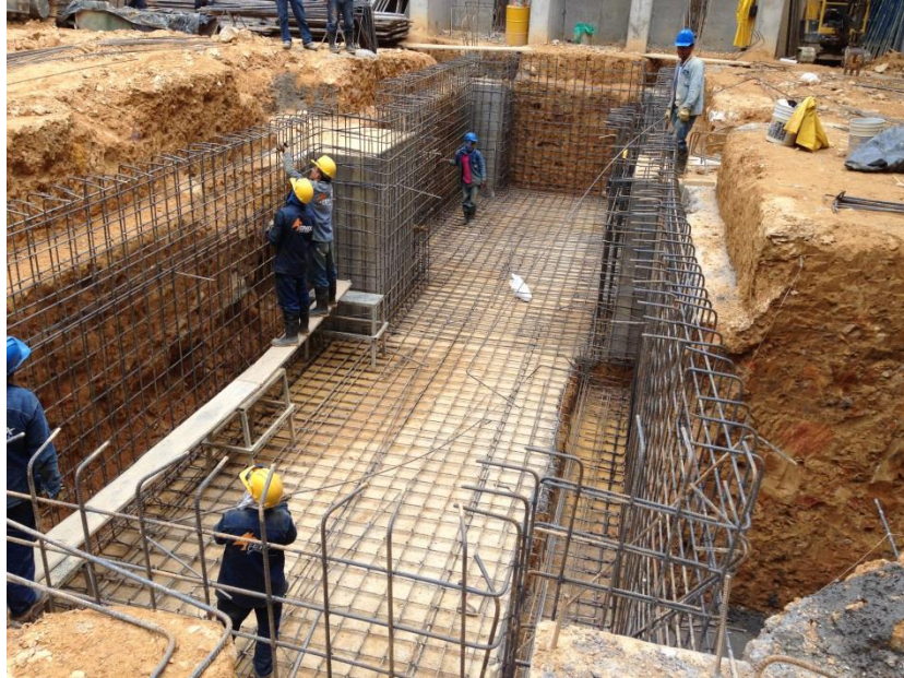
Foto 39 Armado parrilla exterior tanque.
