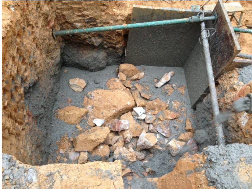
Foto 33 Vaciado del concreto ciclópeo de zapatas costado oriental.
