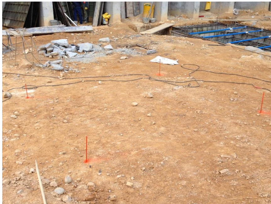
Foto 7 Localización zapata D-6.
