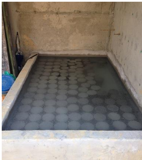
Foto 87 Tanque de almacenamiento de especímenes en obra.
