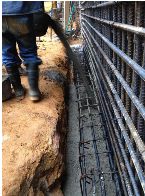
Foto 25 Vaciado viga cimiento muro.
