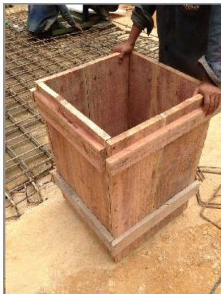
Foto 3 Recipiente para calcular el volumen del material.
