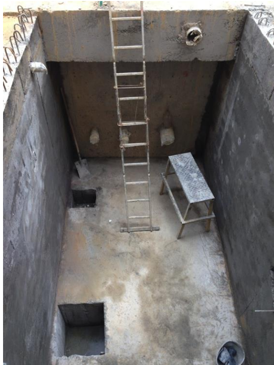
Foto 49 Aspecto final del cuarto de máquinas.
