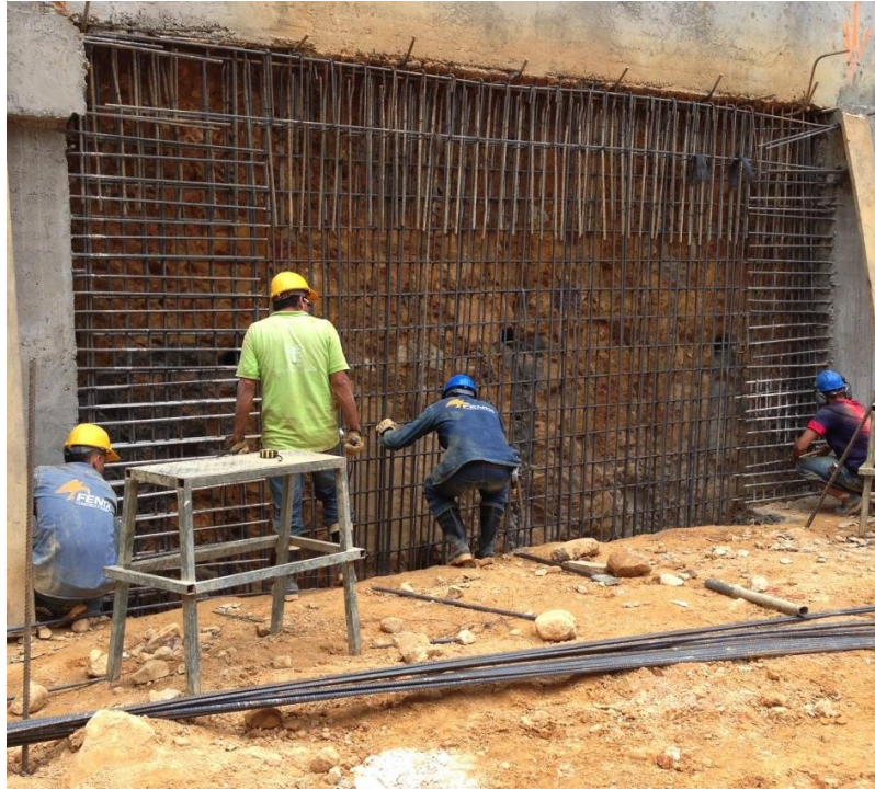
Foto 24 Armado del acero de la parrilla exterior de la pantalla.
