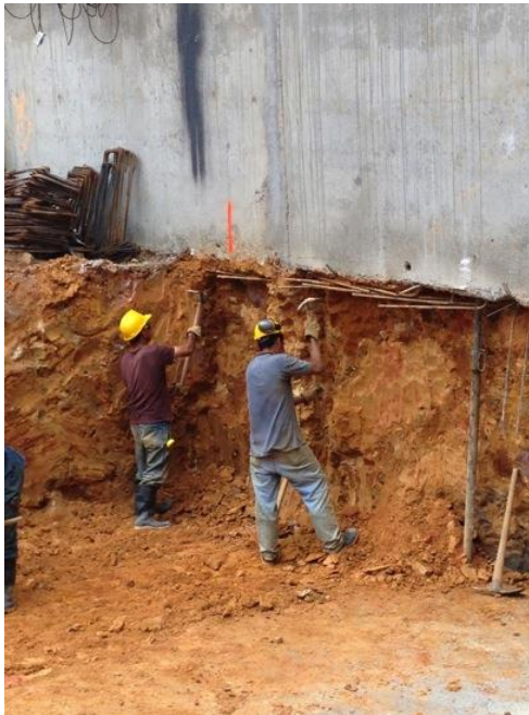
Foto 54 Perfilado manual de los taludes interiores del foso.
