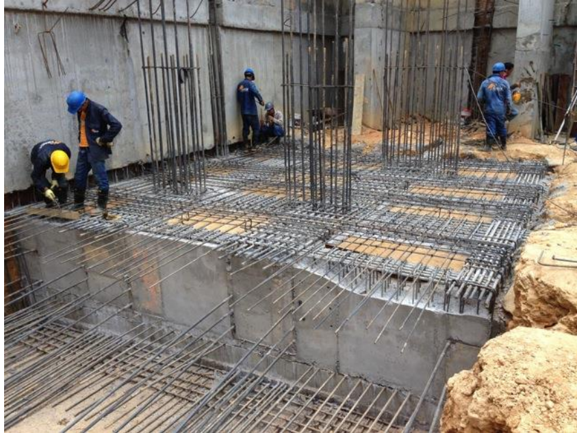
Foto 67 Llenado del aligeramiento haciendo uso del suelo presente en el proyecto.
