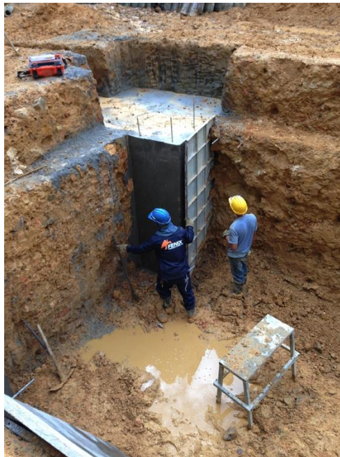
Foto 34 Aspecto final del concreto ciclópeo de las zapatas costado oriental.
