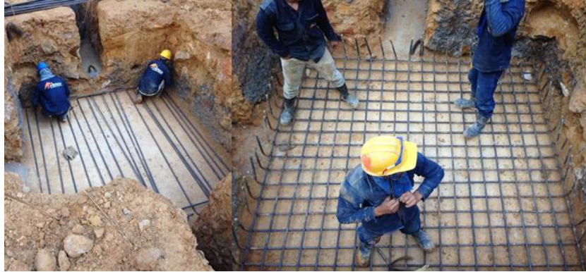
Foto 13 Transporte del acero para armado de la parrilla inferior de la zapata D-6.
