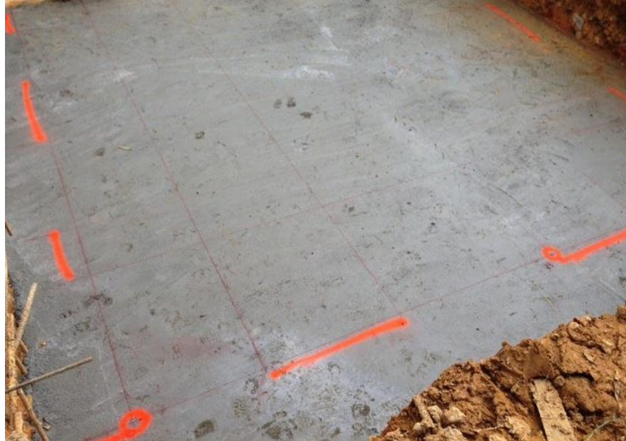
Foto 55 Cimbrado y localización de las vigas cemento, viguetas y casetones sobre el solado de limpieza.
