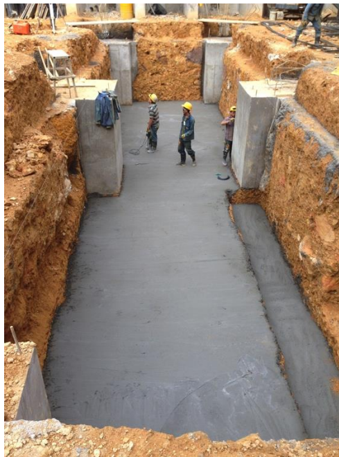
Foto 38 Excavación del cárcamo y vaciado del solado de limpieza.
