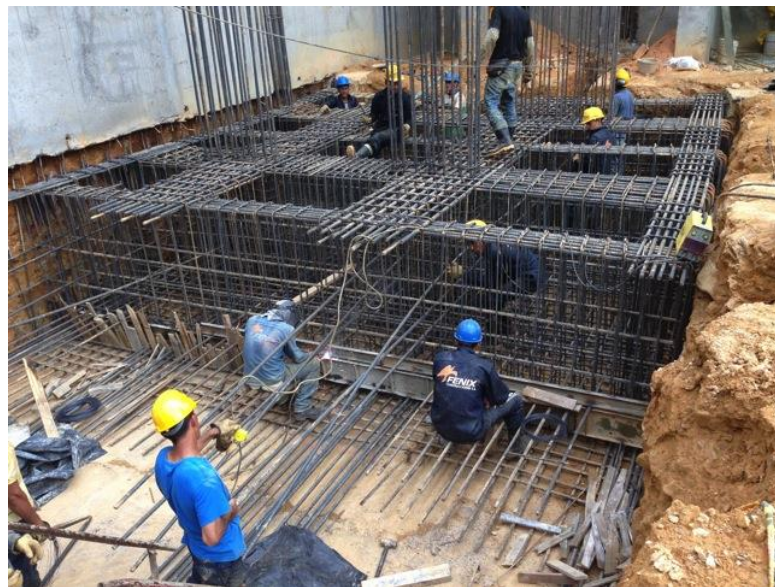
Foto 62 Introducción de la parrilla superior de la placa inferior y construcción del tapón.
