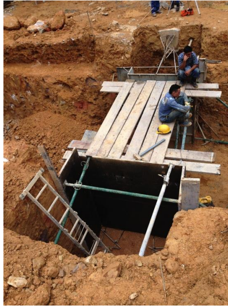
Foto 35 Encofrado del concreto ciclópeo zapatas centrales del tanque subterráneo.
