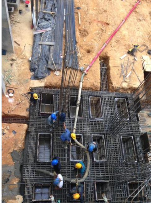
Foto 65 Detalle en planta del aligeramiento para el primer tramo de losa de cimentación PC-2.
