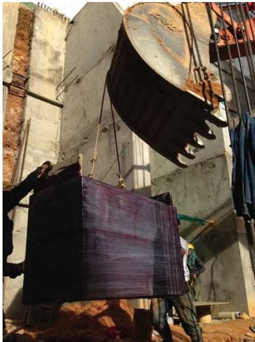
Foto 64 Izado e introducción de los casetones en madera y metálicos.
