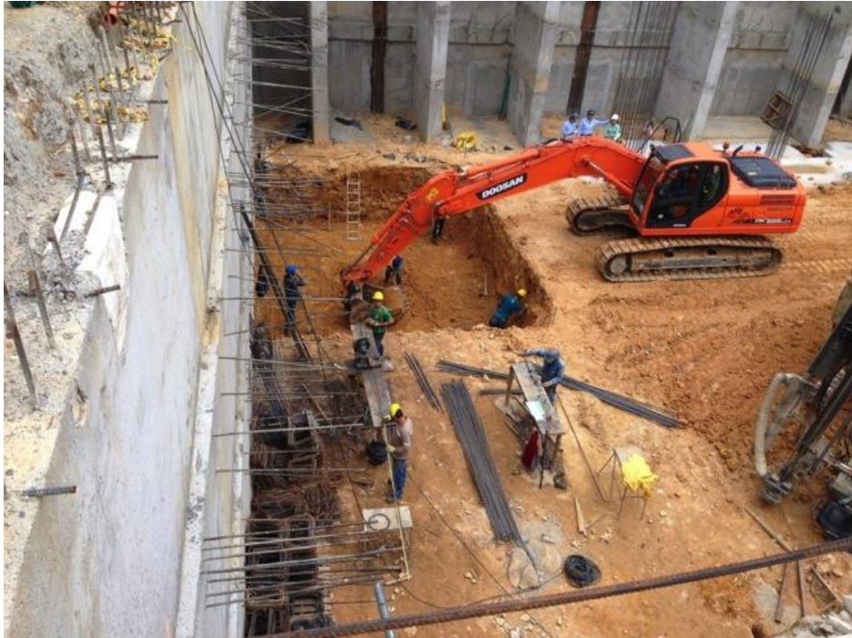
Foto 52 Excavación y conformación del foso para el primer tramo de la losa de cimentación PC-2.
