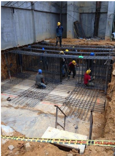
Foto 58 Introducción de acero longitudinal inferior de vigas cimiento y viguetas en una dirección.
