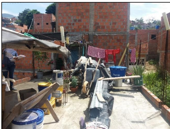
Imagen 30. Estado actual del predio identificado con GDT 4276-23/3 Segundo piso en obra activa.
