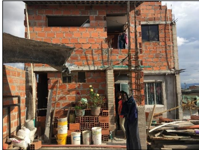
Imagen 24. Estado actual del predio identificado con GDT 4068-2 Tercer y cuarto piso en obra activa
