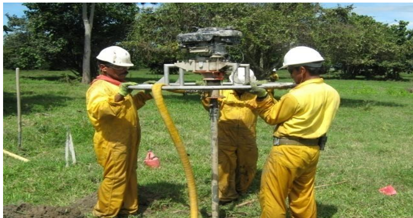
Foto 4. Taladro utilizado en la perforación para instalar los geófonos
