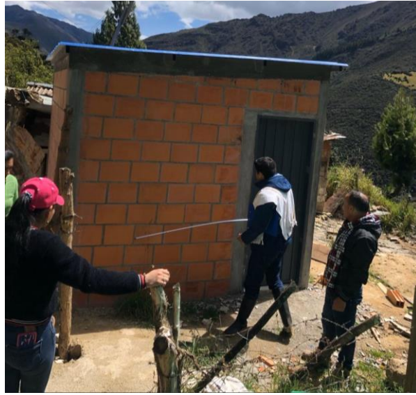
Ilustración 10. Resultado final fachada 1 habitación de Vetás, Santander. Fuente: propia.
