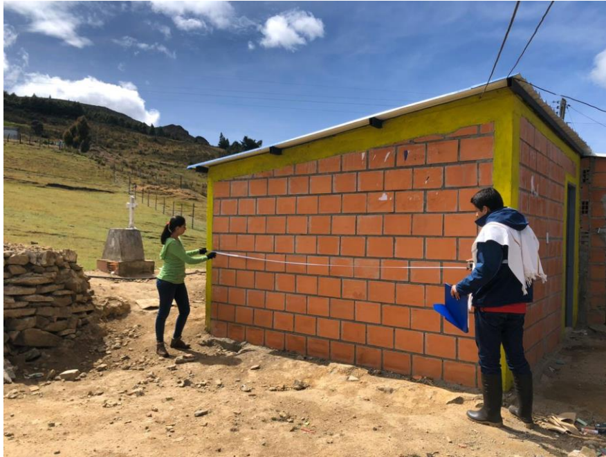
Ilustración 14. Resultado final fachada 2 habitación Vetás, Santander. Fuente: propia.
