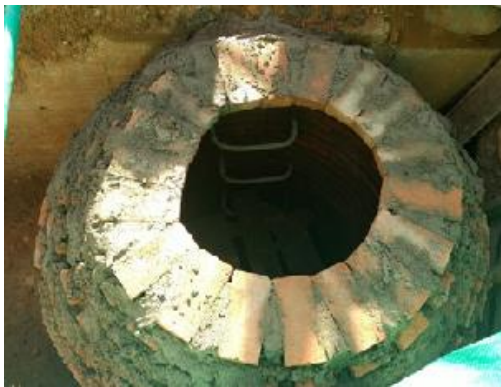
Figura 16. Vista superior Pozo de inspección
