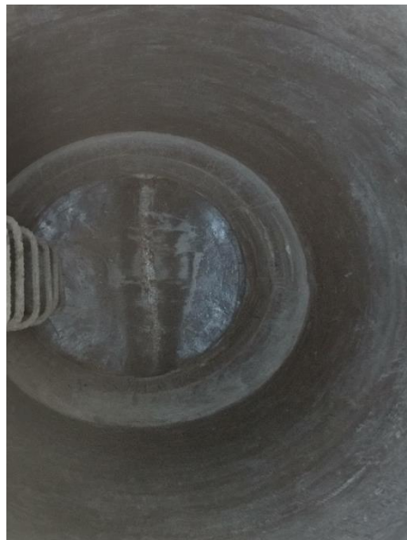
Figura 18. Cañuela Pozo de alcantarillado
