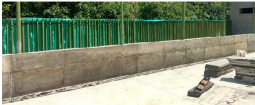
Figura 43. Segundo tramo de antepecho
