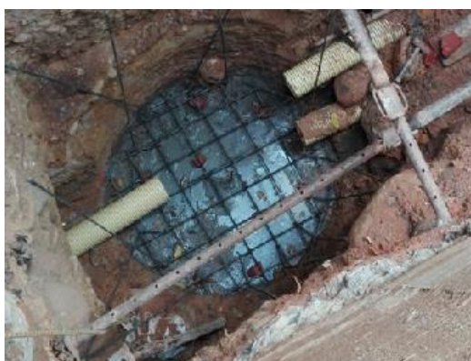
Figura 9. Acero Refuerzo placa base del Pozo de alcantarillado
