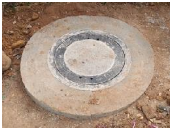
Figura 21. Acabado final pozo alcantarillado
