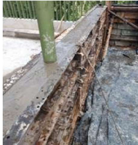
Figura 38. Antepecho después de colocado el concreto
