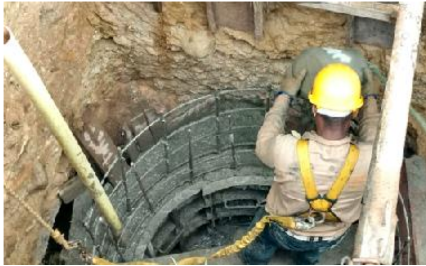
Figura 11. Vaciado de concreto cuerpo cilíndrico inferior estructura-pozo
