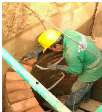
Figura 14. Instalación pasos pozo de inspección
