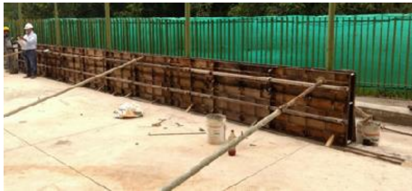
Figura 42. Encofrado segundo tramo
