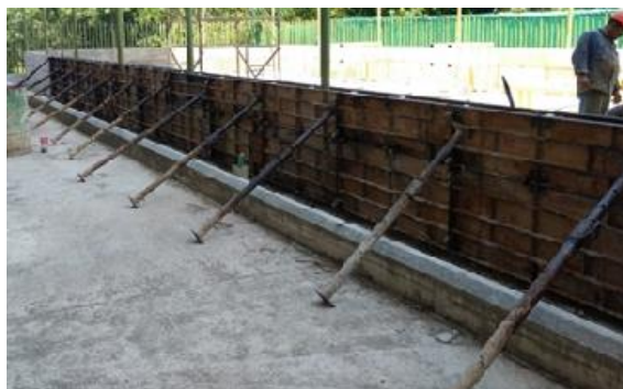
Figura 44. Encofrado tercer tramo
