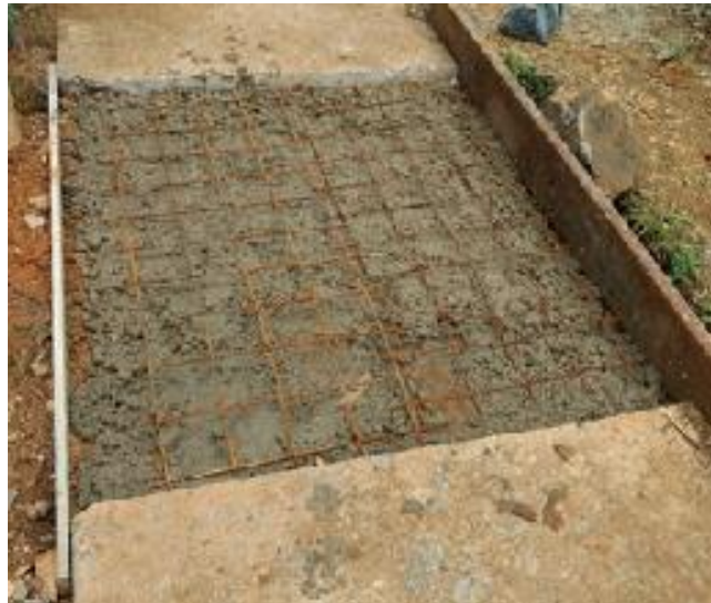
Figura 23. Malla de refuerzo losa de concreto andén
