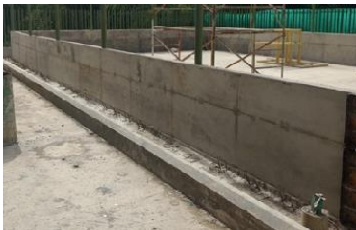
Figura 45. Tercer tramo de antepecho
