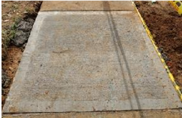
Figura 24. Acabado final losa de concreto para andén
