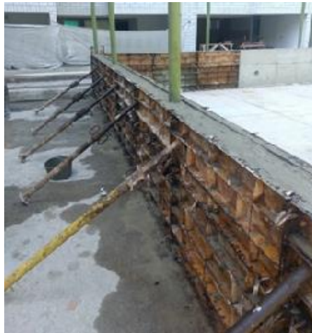
Figura 46. Cuarto tramo después de colocado el concreto
