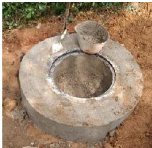
Figura 20. Anillo de concreto terminado y aro metálico
