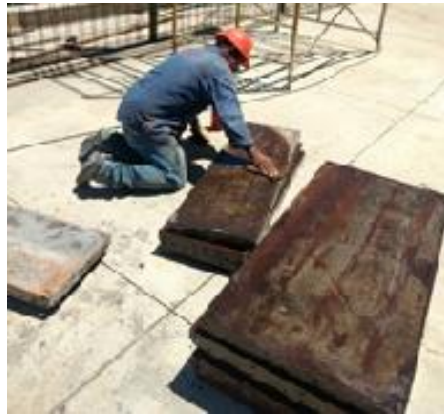
Figura 41. Aplicación desencofrante de formaleta
