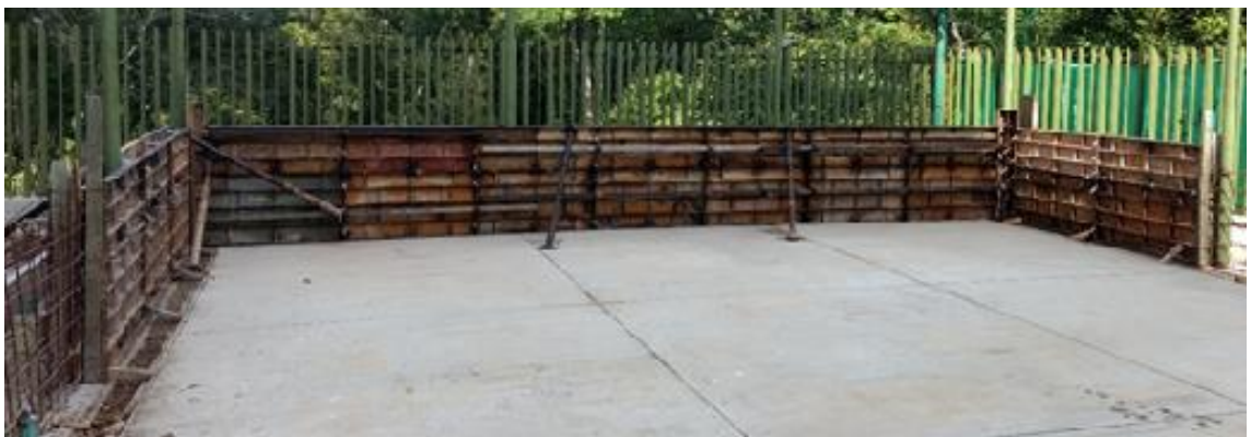
Figura 34. Encofrado primer tramo
