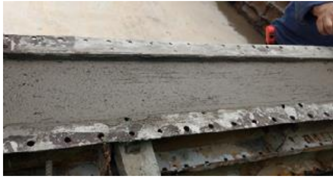
Figura 39. Acabado con llana de madera
