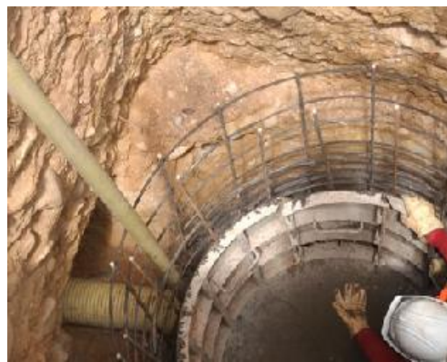
Figura 10. Acero de refuerzo de cuerpo cilíndrico de concreto
