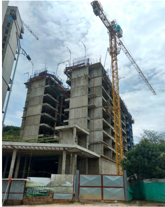
Figura 4. Vista lateral de la torre 3 proyecto IRAWA
