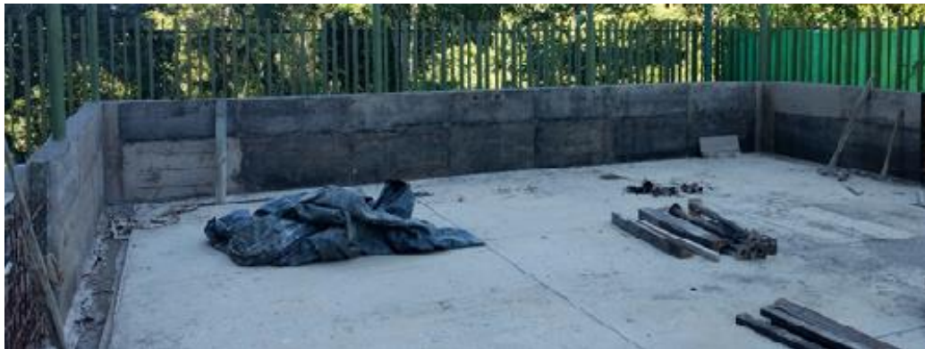
Figura 40. Primer tramo de antepecho
