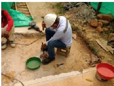
Figura 25. Extracción material ensayo de densidad de cono
