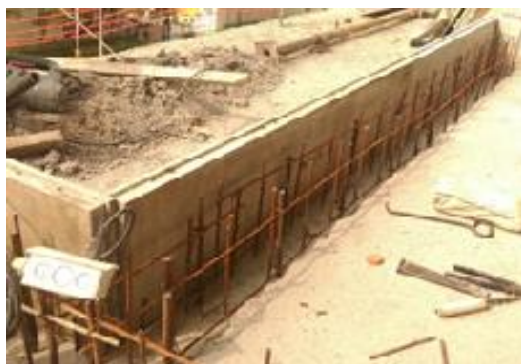
Figura 50. Malla de refuerzo bordillo
