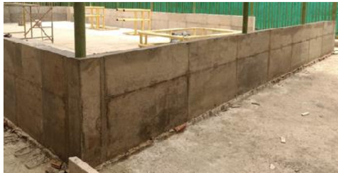
Figura 47. Cuarto tramo de antepecho
