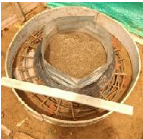
Figura 19. Armado de acero refuerzo anillo de concreto
