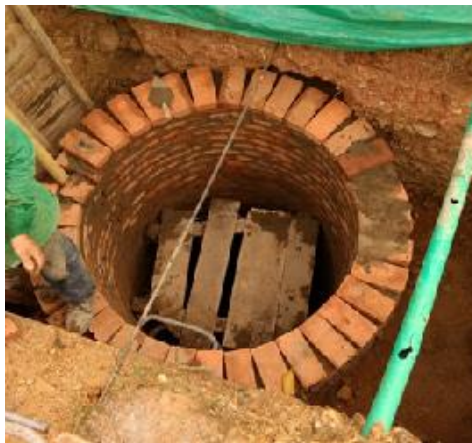
Figura 13. Avance mampostería pozo de inspección
