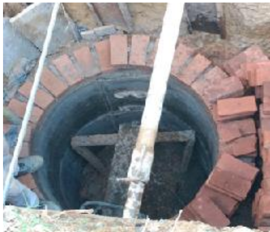
Figura 12. Estructura-pozo finalizada, inicio mampostería
