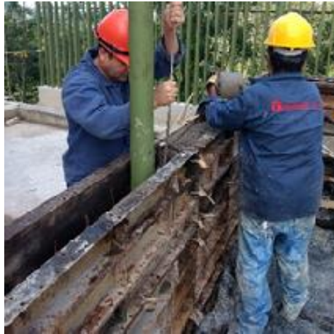
Figura 37. Colocación del concreto en antepecho
