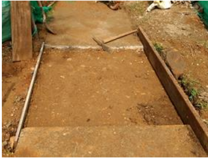
Figura 22. Adecuación terreno para placa de andén
