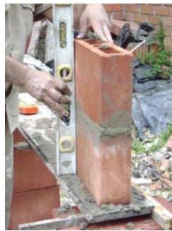
Figura 21. Verificación del Nivel de los Muretes.
