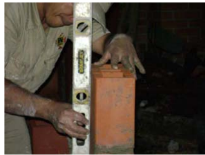
Figura 21. Verificación del Nivel de los Muretes.
