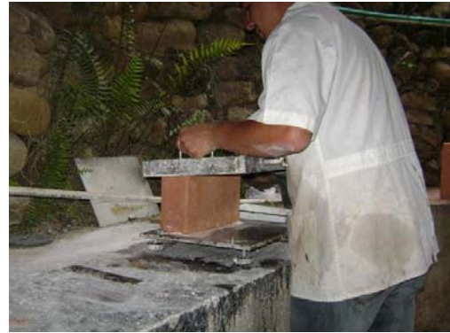
Figura 13. Extendida de la Mezcla y Asentamiento de la Pieza.
