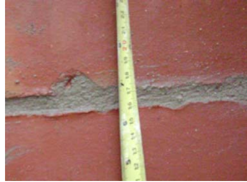
Figura 24. Cumplimiento del Espesor de la Junta.
