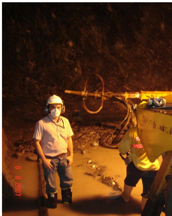
Figura 1 - Ingeniero practicante acompañando Robojet Sika PM500 durante lanzado de concreto
