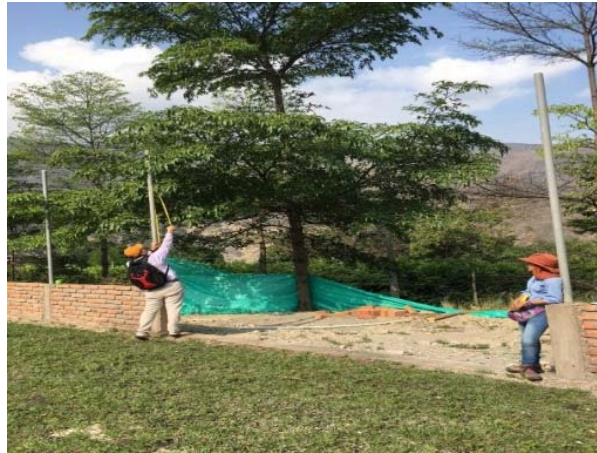
Imagen 9. Camerinos en proceso de construcción.
