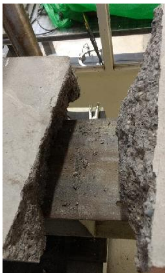
Ilustración 43. Falla placa normal
