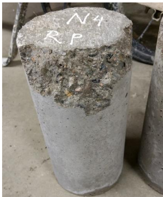
Ilustración 28. Falla concreto normal
