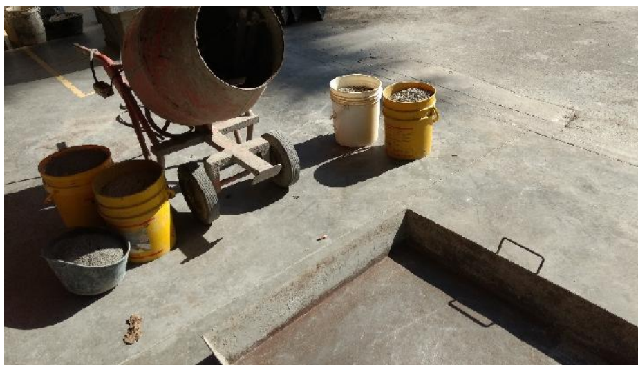
Acopio de materiales para realizar una mezcla satisfactoria en la elaboración de los cilindros, vigas y placas
