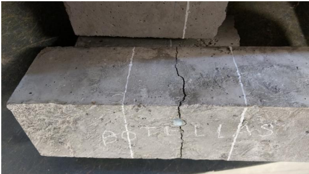
Ilustración 41. Falla superior de viga con botella
