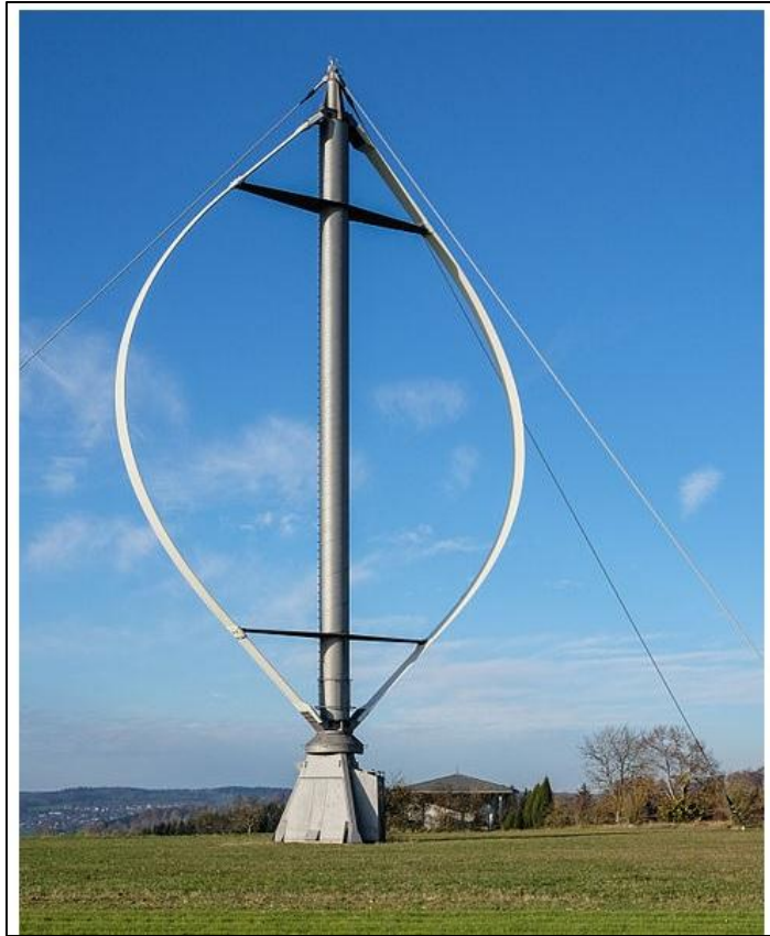
Figura 7. Aerogenerador de eje vertical tipo Darrieus
