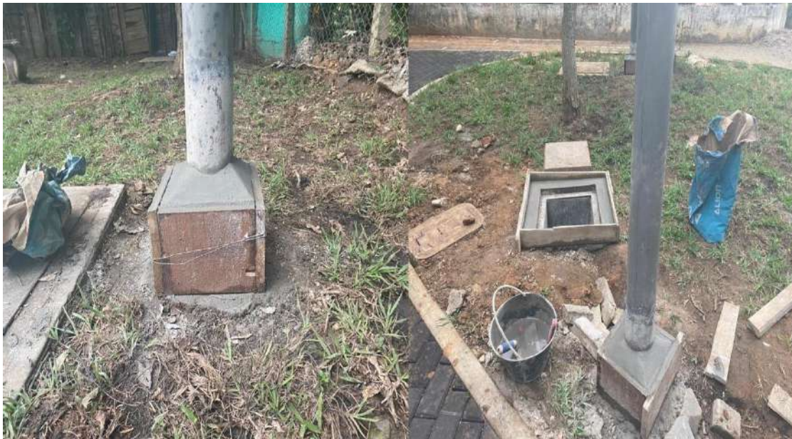
Figura 30. Zapata para postes de luz pública.
