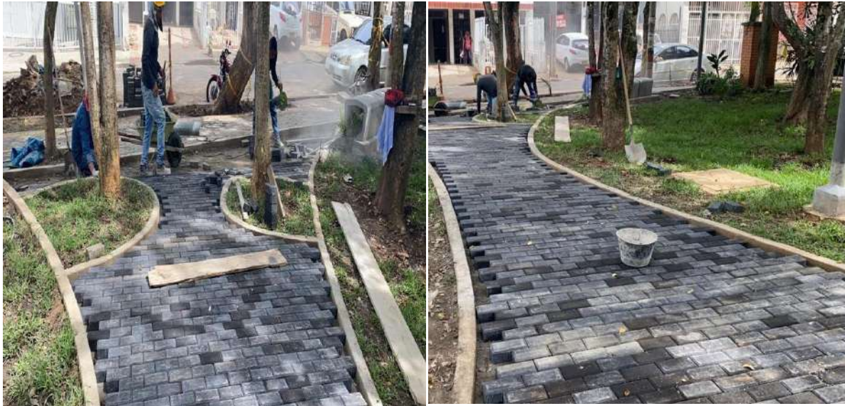
Figura 28. Instalación de adoquines.
