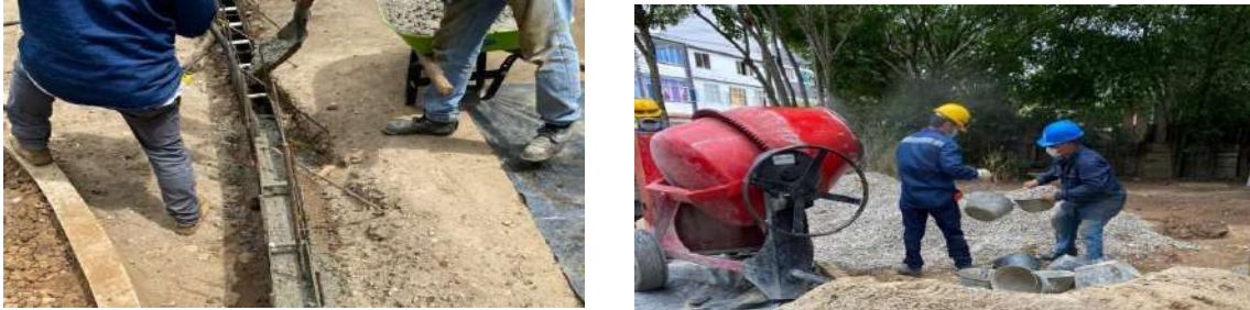
Figura 13. Fundida de concreto para bordillos
