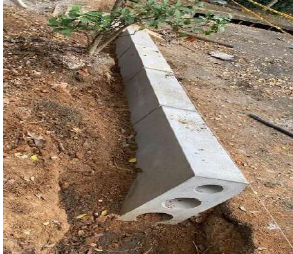
Figura 7. Instalación de sardinel.
