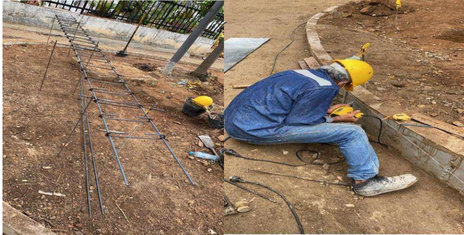
Figura 11. Armado de acero
