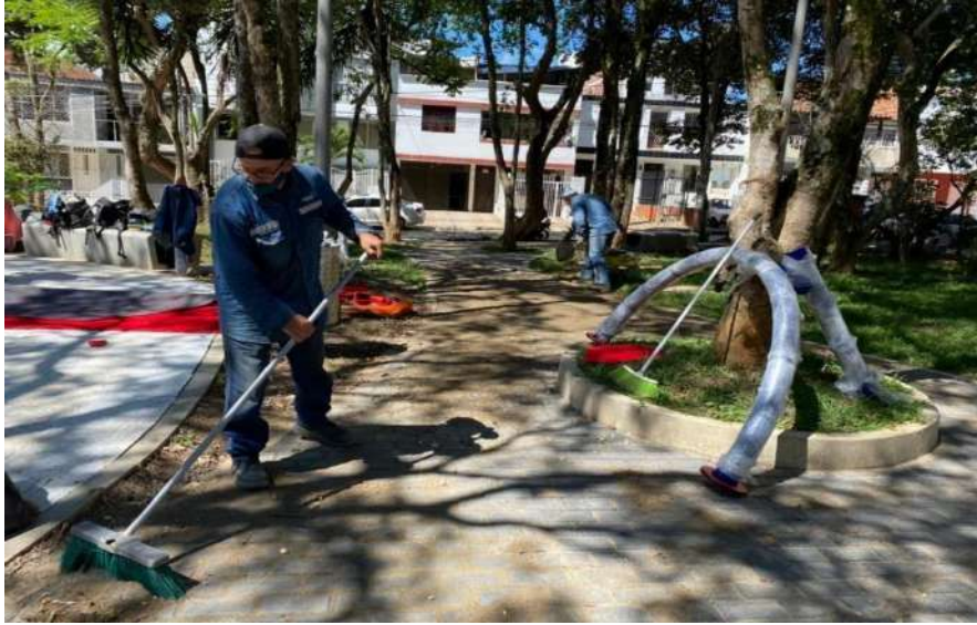
Figura 29. Limpieza de zona.
