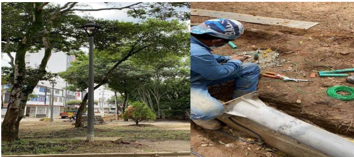
Figura 24. Suministro e instalación de cables para alumbrado
