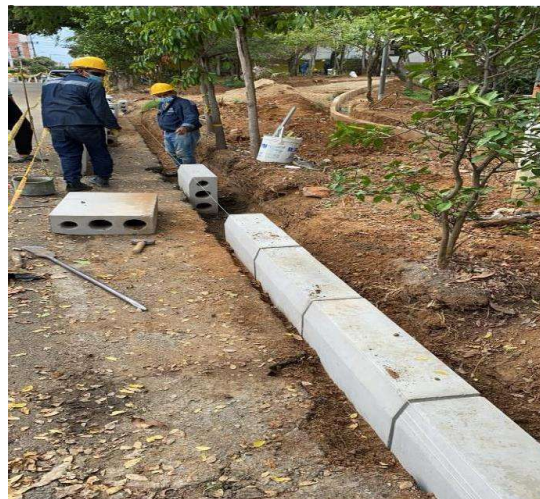
Figura 8. Instalación de sardinel
