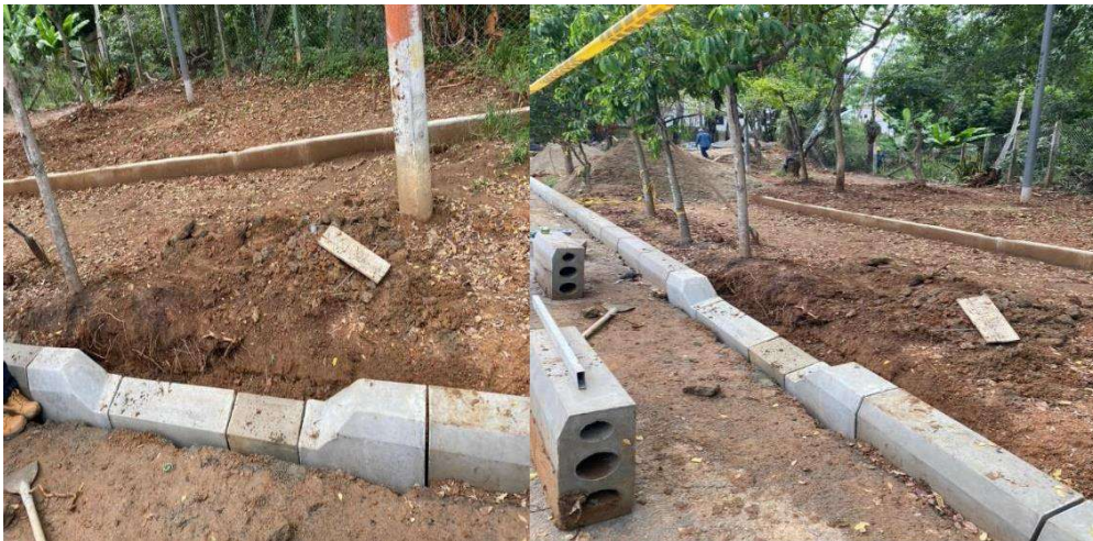
Figura 22. Instalación de sardineles
