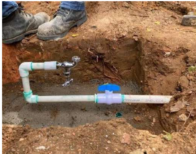
Figura 5. Vista lateral Tubería de 1/21 "
