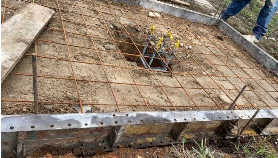
Figura 25. Instalación de malla electrosoldada 1.20 x 0.15 m
