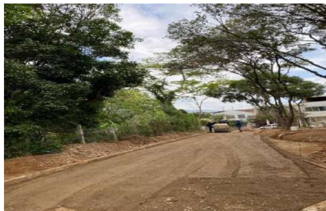
Figura 6. Compactación de la subbase
