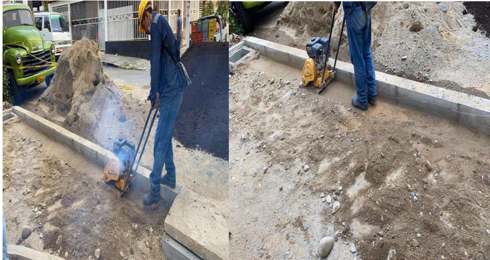
Figura 19. Relleno y compactación de subbase granular
