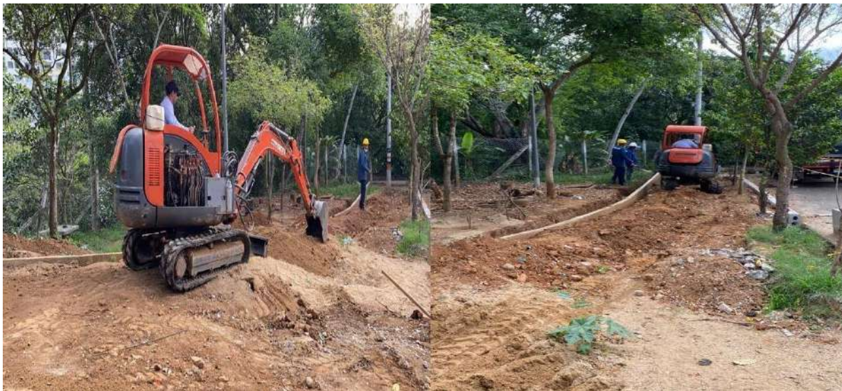
Figura 2. Localización y replanteo
