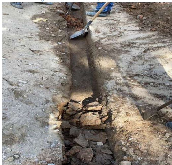
Figura 10. Excavación para sardineles
