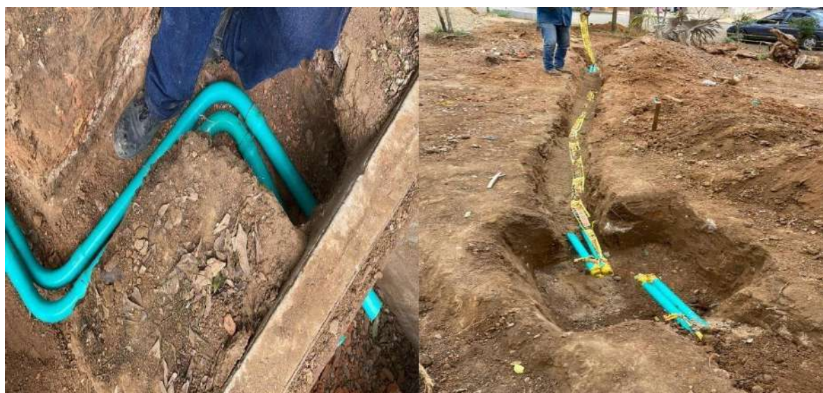
Figura 9. Instalación de tubería eléctrica
