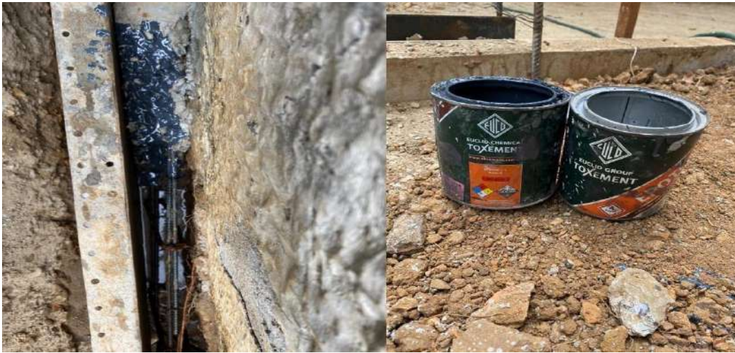
Figura 15. Aplicación de adhesivo epóxico
