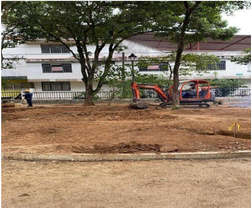
Figura 4. Desmonte y descapote.
