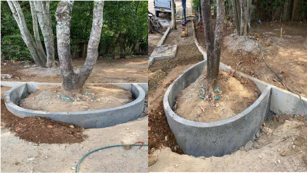
Figura 21. Instalación de formaleta para bordillo de árboles
