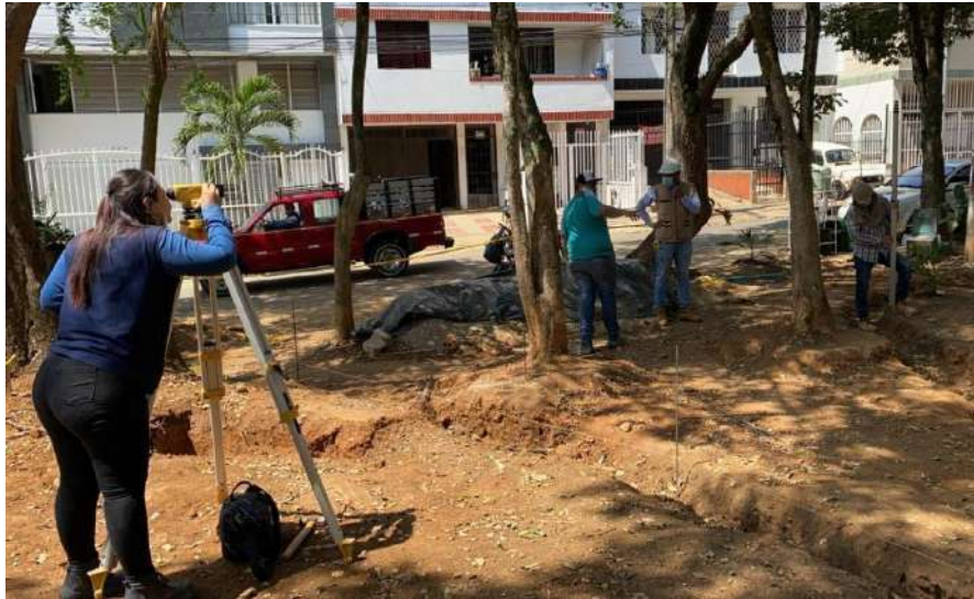
Figura 3. Localización y replanteo.
