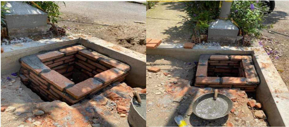
Figura 16. Cajas eléctricas 40x40 cm
