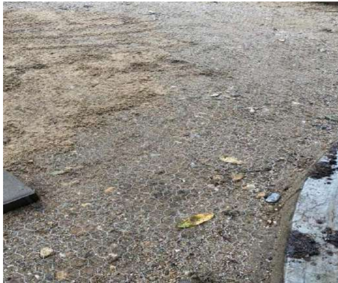
Figura 23. Instalación de malla electrosoldada
