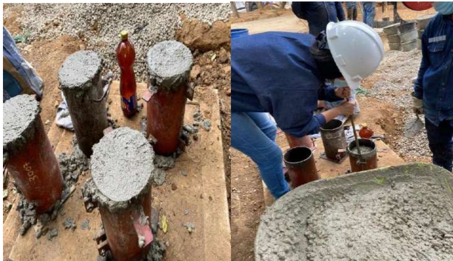
Figura 14. Toma de muestras de cilindros en concreto
