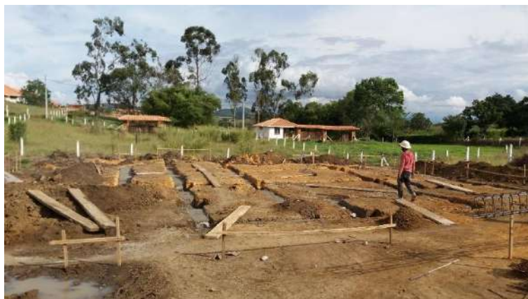
Fotografía 9 – Solado de Limpieza, Fuente: Propia
