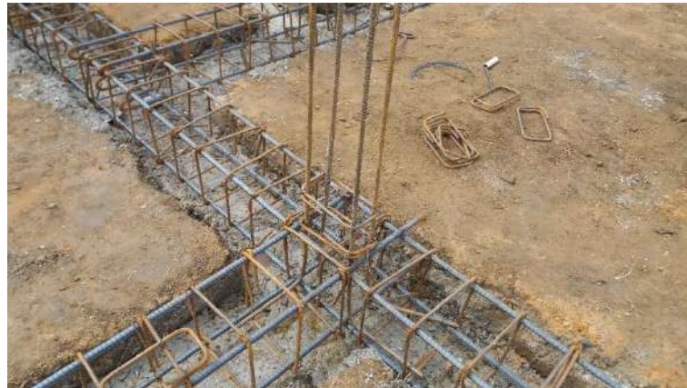
Fotografía 12 – Figurado, Armado y Colocación Vigas de Cimentación, Fuente: Propia
