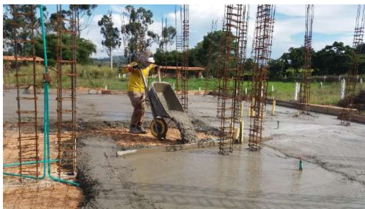
Fotografía 24 – Placa Contrapiso, Fuente: Propia
