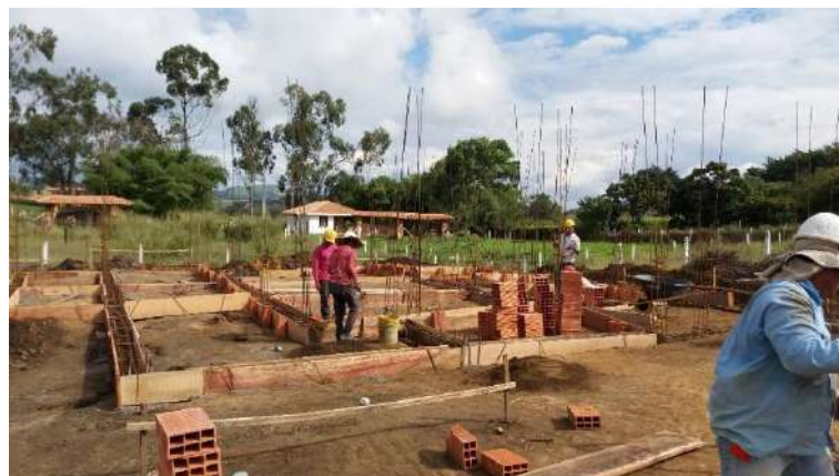
Fotografía 13 – Vigas de Cimentación, Fuente: Propia
