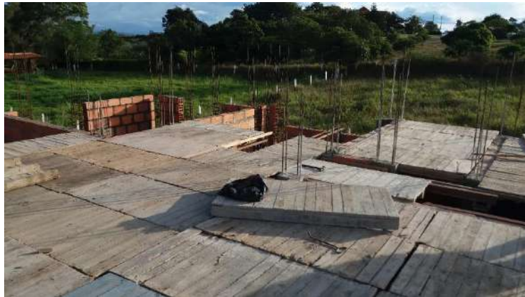
Fotografía 30 – Armado e Instalación Formaleta Placa Entrepiso, Fuente: Propia
