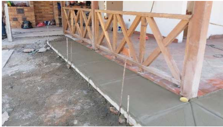
Fotografía 64 – Andenes, Fuente: Propia
