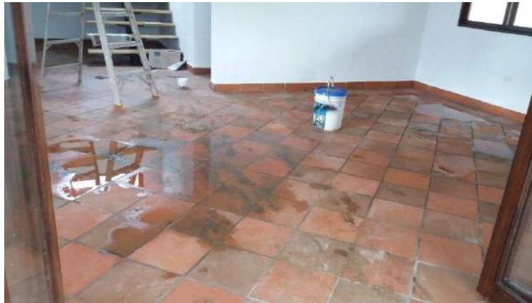
Fotografía 83 – Aseo Final, Fuente: Propia
