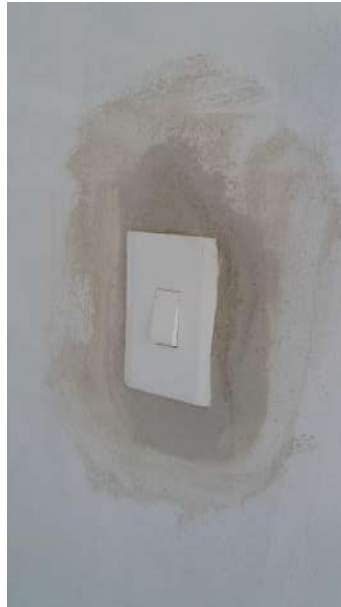
Fotografía 74 – Instalaciones Eléctricas Finales, Fuente: Propia
