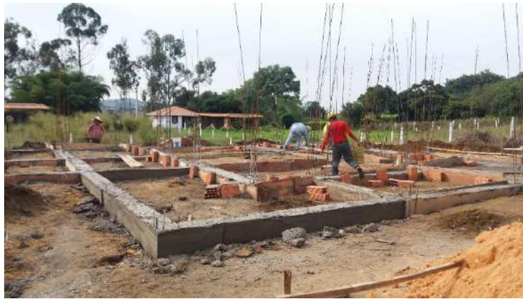
Fotografía 15 – Amarre Acero Columnas de Confinamiento, Fuente: Propia
