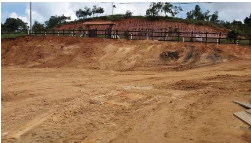
Fotografía 3 – Nivelación Terreno CASA CAMPESTRE, Fuente: Propia
