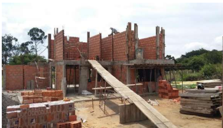
Fotografía 44 – Columnas de Confinamiento (Columnetas), Fuente: Propia
