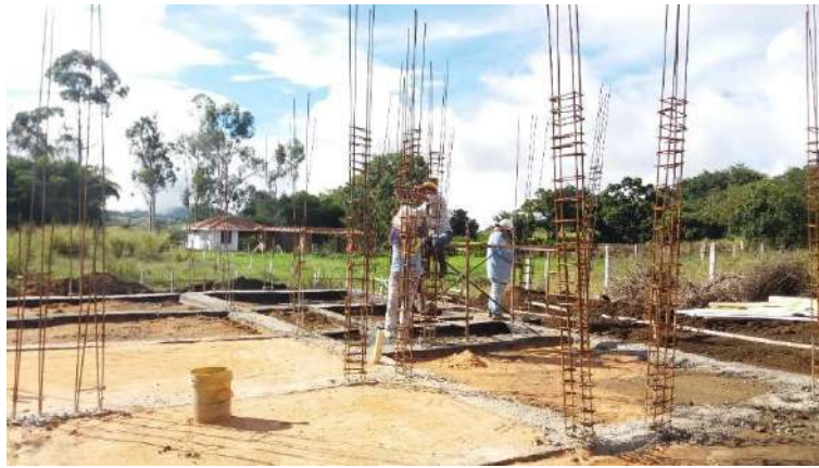
Fotografía 16 – Amarre Acero Columnas de Confinamiento, Fuente: Propia
