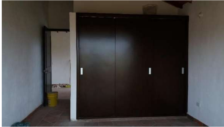
Fotografía 72 – Instalación Closets, Fuente: Propia
