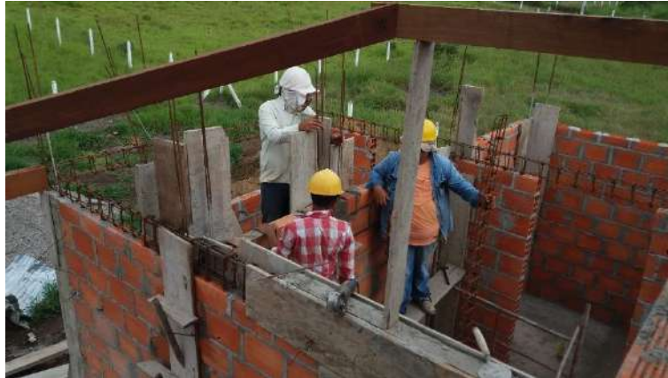
Fotografía 49 – Figurado y Amarre Viga Cinta, Fuente: Propia
