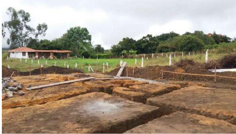
Fotografía 8 - Excavaciones Cimentación, Fuente: Propia
