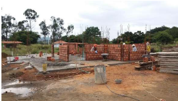
Fotografía 26 – Muros de Mampostería Planta Uno, Fuente: Propia
