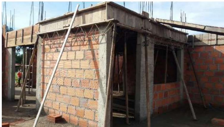
Fotografía 31 – Armado e Instalación Formaleta Placa Entrepiso, Fuente: Propia
