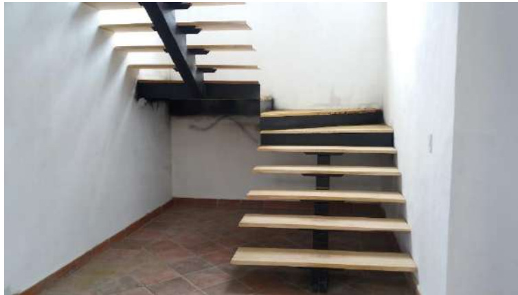
Fotografía 73 – Instalación Escalera, Fuente: Propia
