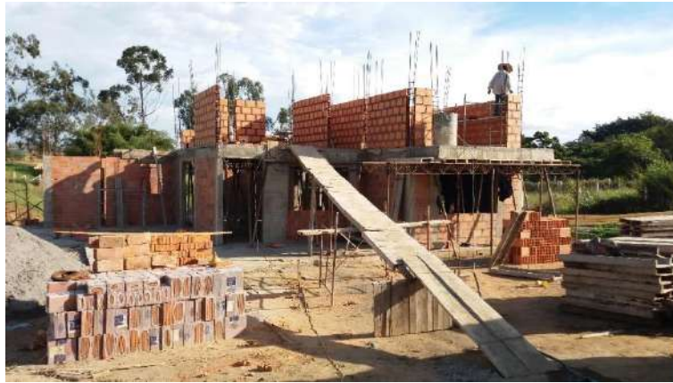
Fotografía 39 – Muros de Mampostería Planta Dos, Fuente: Propia
