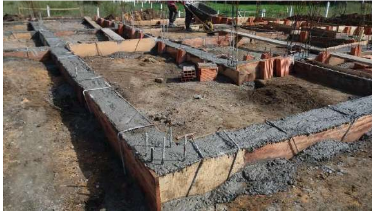
Fotografía 14 – Vigas de Cimentación, Fuente: Propia
