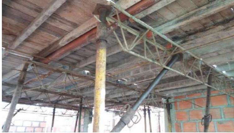
Fotografía 29 – Armado e Instalación de Formaleta de Placa Entrepiso, Fuente: Propia
