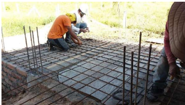
Fotografía 43 – Tanque de Agua para Almacenamiento, Fuente: Propia
