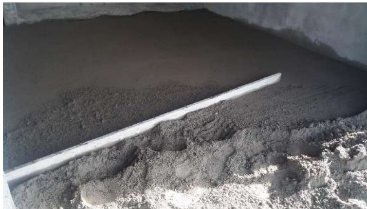
Fotografía 62 – Mortero de Nivelación, Fuente: Propia
