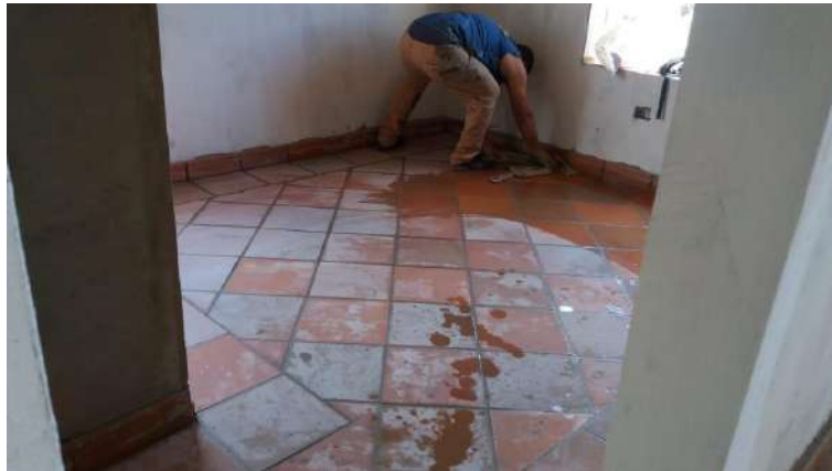
Fotografía 70 – Enchape Pisos, Fuente: Propia
