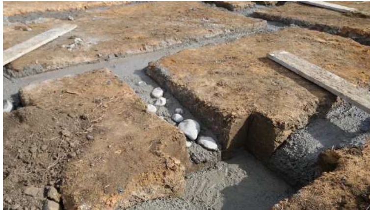
Fotografía 10 – Vaciado de Concreto Ciclópeo, Fuente: Propia
