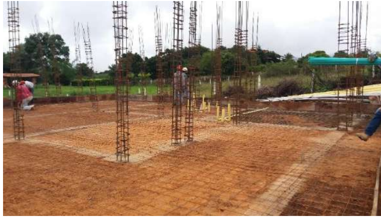
Fotografía 21 – Instalación Malla Electrosoldada, Fuente: Propia
