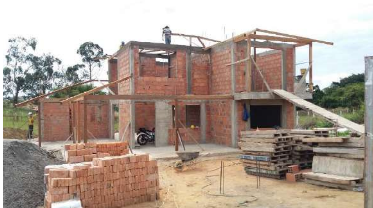
Fotografía 50 - Viga Cinta, Fuente: Propia
