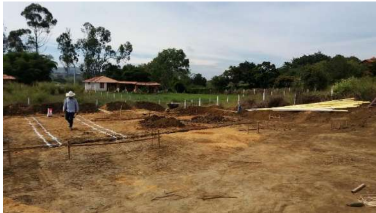
Fotografía 7 – Replanteo y Marcación Casa, Fuente: Propia
