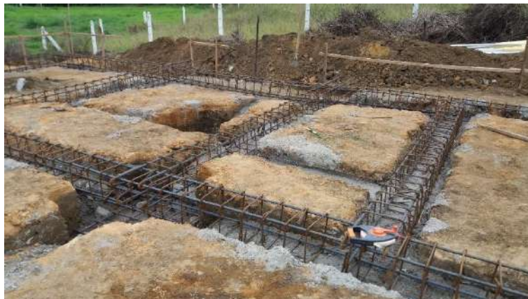
Fotografía 11 – Figurado y Armado Acero Vigas de Cimentación, Fuente: Propia
