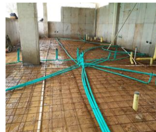
Instalación tubería hidráulica, sanitaria y eléctrica. Imagen 12.
