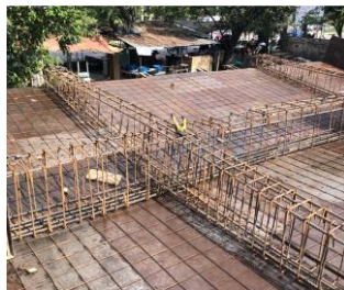
Instalación malla electrosoldada. Imagen 10.
