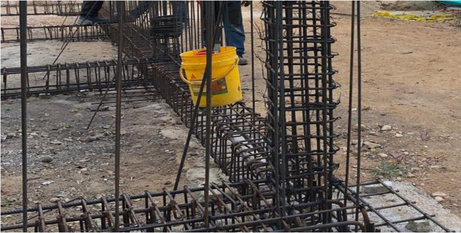
Imagen 5. Acero de refuerzo para vigas y columnas
