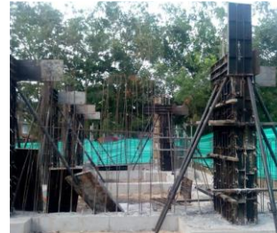
Armado de formaleta para columnas. Imagen 9.
