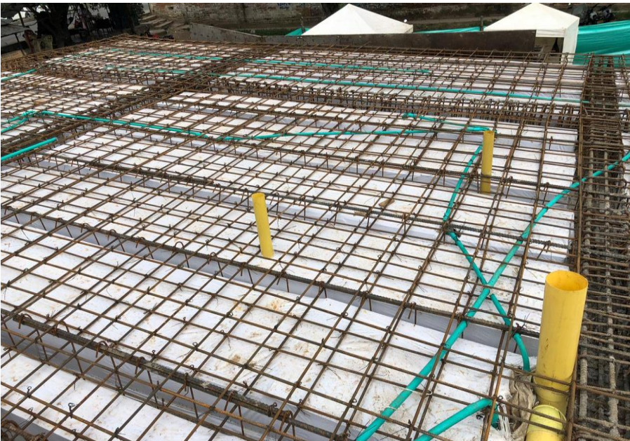
Imagen 6. Acero de refuerzo para placa
