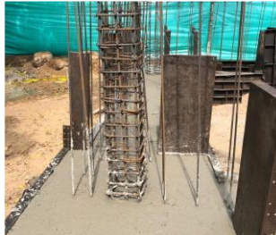
Fundida de vigas y zapatas Imagen 8.
