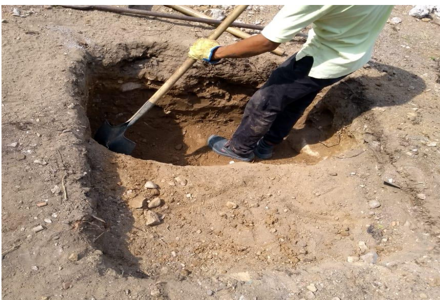
Imagen 3. Excavación para cimentación.
