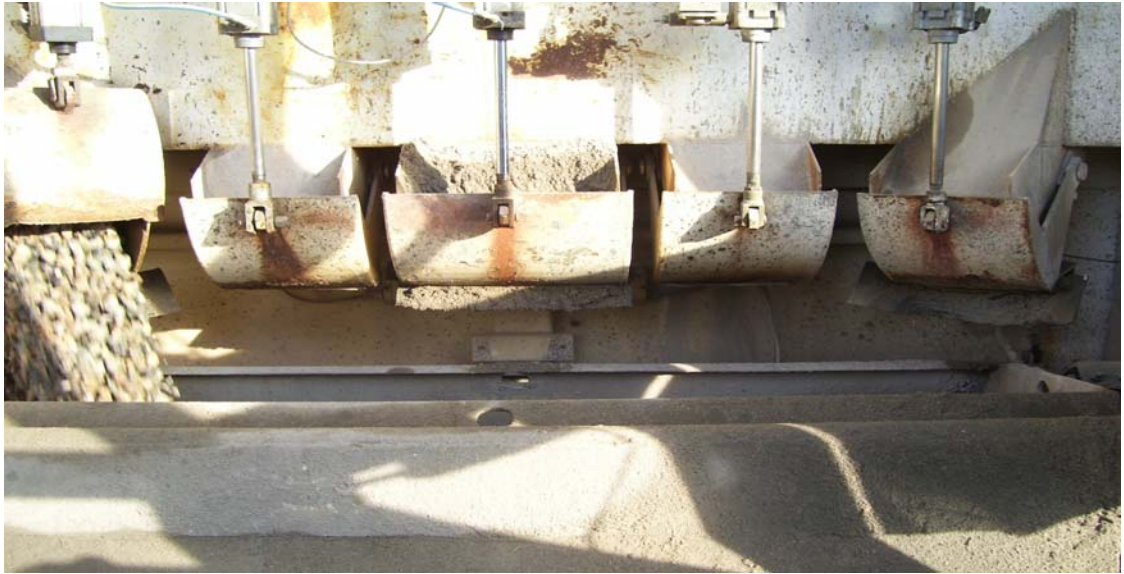
Figura 9. Vaciado de Agregado en el Ski.
