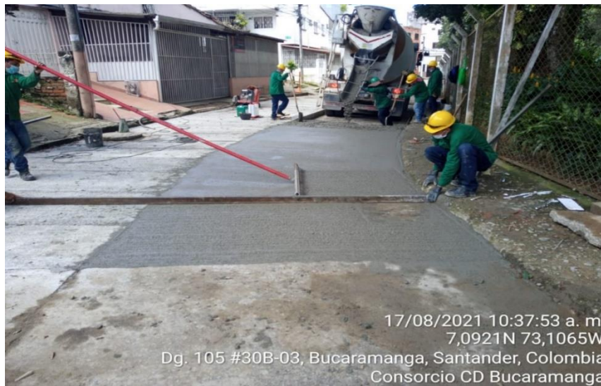
Imagen 5. Fundida de losas en concreto.
