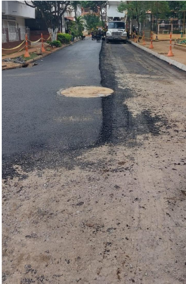
Imagen 9. Cambio de estructura en pavimento flexible
