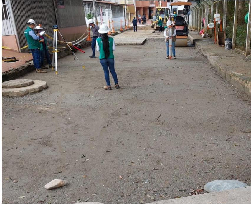
Imagen 4. Conformación de la base.
