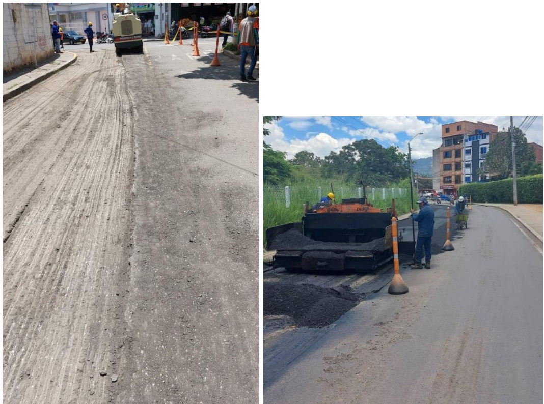
Imagen 7 – 8. Fresado y pavimentación
