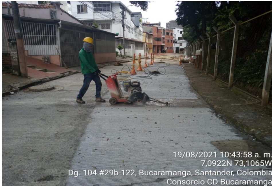
Imagen 6. Corte de juntas y división de losas.
