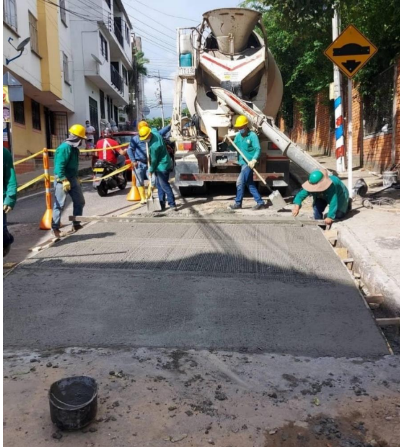
Imagen 10. Construcción de pompeyanos
