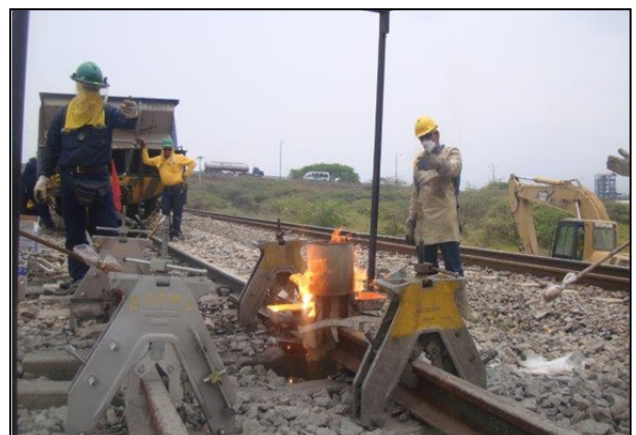
Imagen 81. Vaciado de la soldadura aluminotérmica en los moldes
