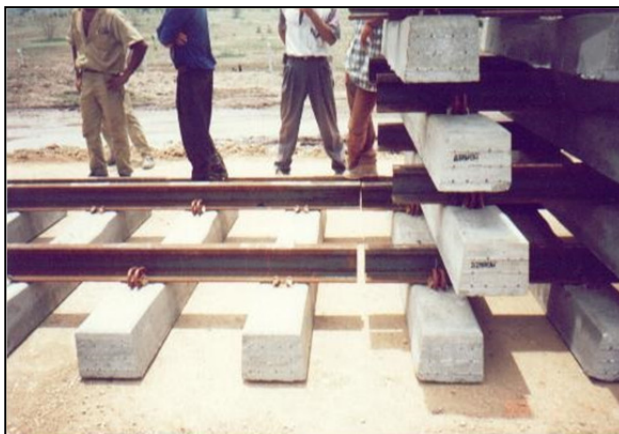
Imagen 46. Posicionadora centrando las escaleras con referencia al eje de vía identificado sobre el subbalasto mediante una estaquilla.
