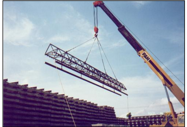
Imagen 38. Cargue de los rieles ( 18 m ) para el premontaje de escaleras
