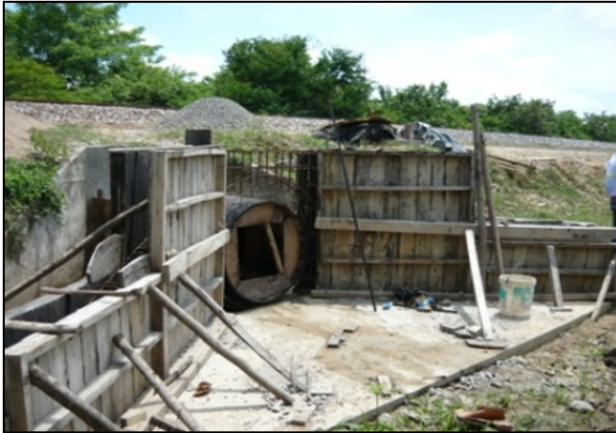
Imagen 82. Alcantarillas ampliadas con la construcción de la nueva línea
