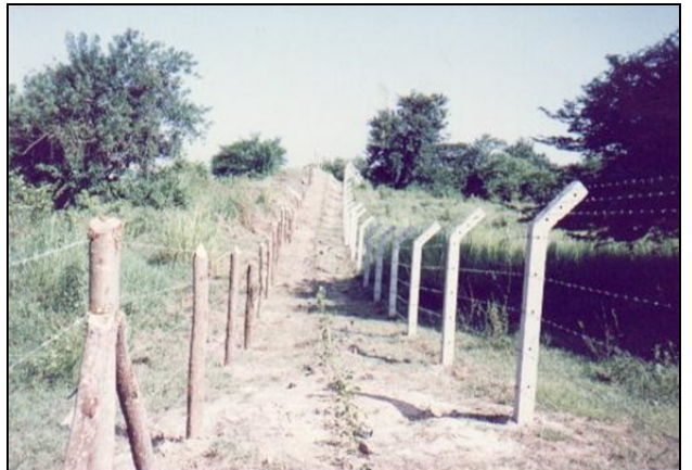
Imagen 10. Delimitación del sector de los apartaderos con cercas de concreto, de madera y cercas vivas
