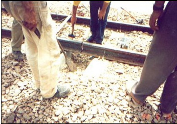
Imagen 52. Alineación previa de los rieles para efectuar la soldadura aluminotérmica
