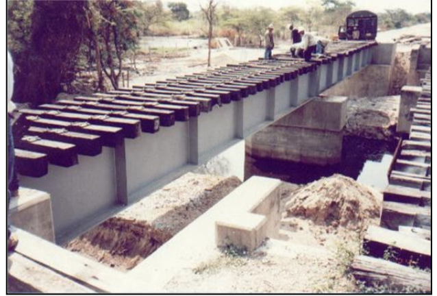
Imagen 8. Puentes (L = 30 m) localizados en la vía rehabilitada
