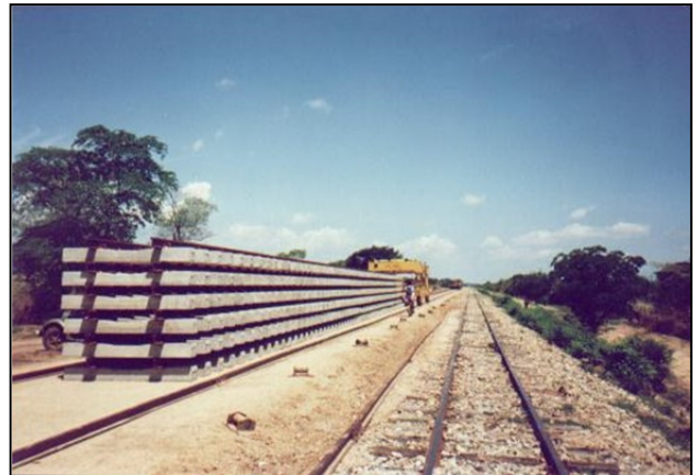
Imagen 43. Etapa de acopio de escaleras utilizando pórticos GEISMAR PDR-350
