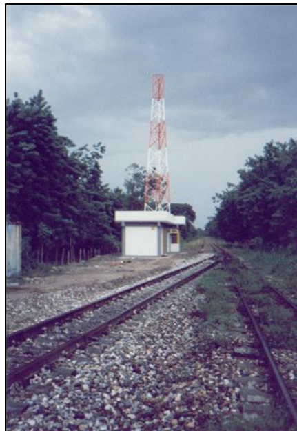
Imagen 88. Caseta nueva para acceso de trenes a Puerto Drummond. Obsérvese la antena para comunicaciones con Centro de Control y con otras estaciones.
