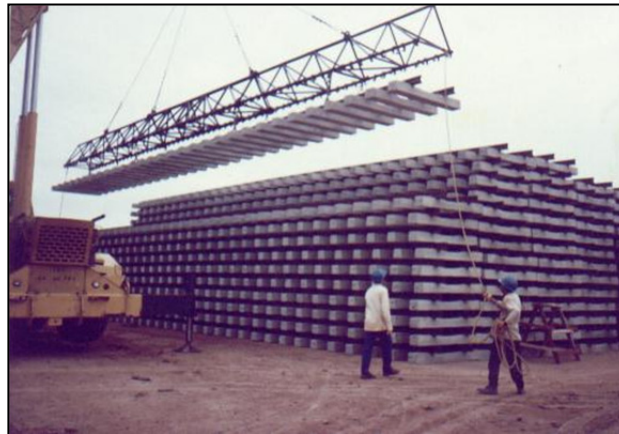
Imagen 41. Etapa final de premontaje de escaleras, secuencia del retiro del tramo montado y colocación en acopio
