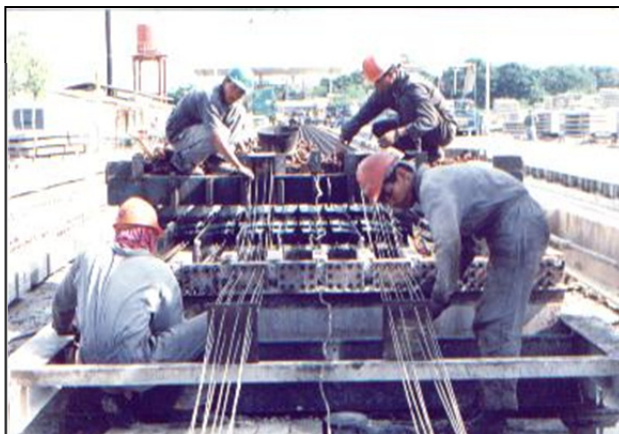
Imagen 15. Colocación de platinas separadoras horizontales y verticales para garantizar posición correcta de los alambres
