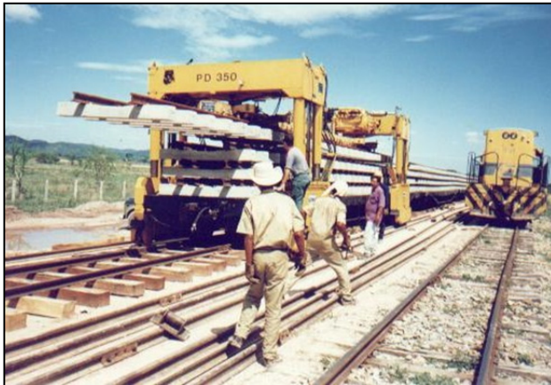
Imagen 42. Desmonte de las escaleras de la plataforma utilizando pórticos GEISMAR PDR-350
