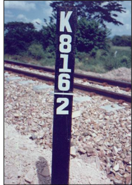
Imagen 71. Postes kilométricos ubicados cada 250 m en todo el trayecto La Loma - Puerto Drummond. K816-2 = Kilometro 816 poste 2 = K816+500
