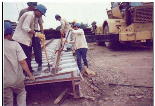
Imagen 40. Colocación de las fijaciones ( intercaladas de lados y de traviesas)
