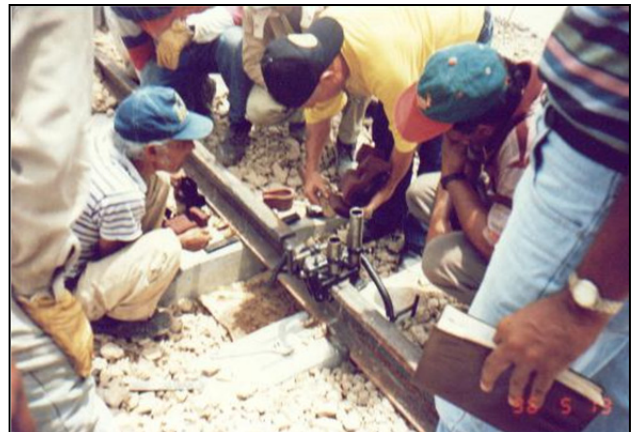
Imagen 55. Colocación del soporte universal en el cual se ubica el crisol y el equipo de precalentamiento y se aseguran los moldes para la soldadura
