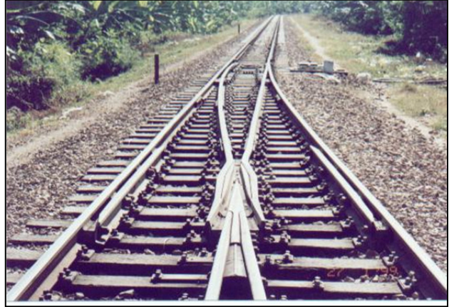
Imagen 97. . Cambiavías utilizado en línea rehabilitada.
