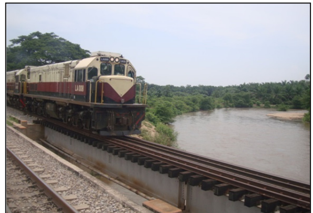
Imagen 87. Tránsito de tren de la Drummond circulando sobre las líneas nuevas ya construidas
