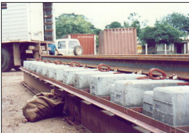
Imagen 39. Detalle del molde para armado de las escaleras. Dos escaleras con separación de 60 cm entre traviesas.
