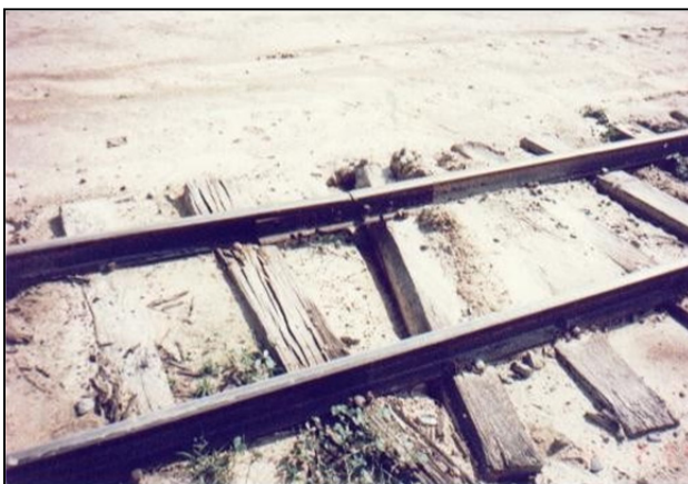
Imagen 1. Estado inicial de la línea a rehabilitar. Obsérvese el mal estado de las traviesas y la contaminación del material de soporte.
