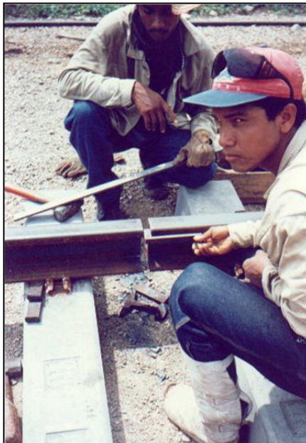
Imagen 54. Chequeo de la cala para efectuar la soldadura
