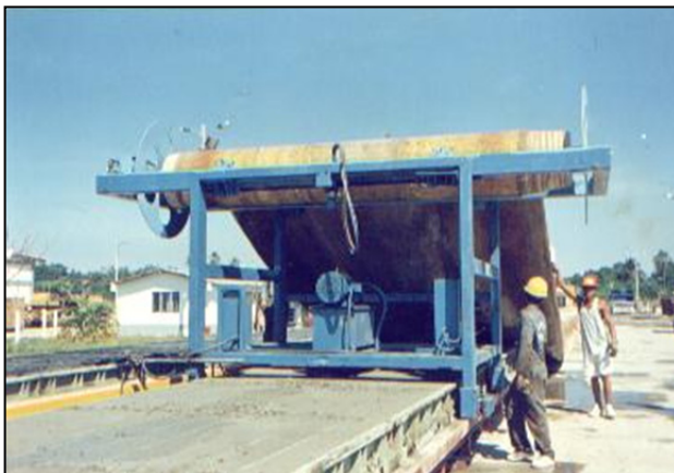
Imagen 21. Colocación de la carpa para iniciar el curado a vapor
