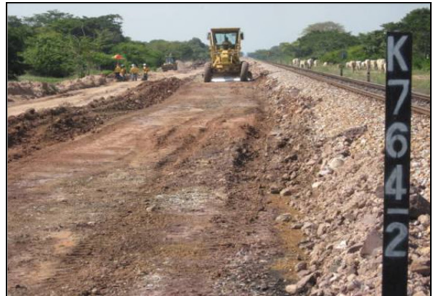
Imagen 77. Trabajos de explanación y mejoramiento del terreno de fundación de la nueva línea
