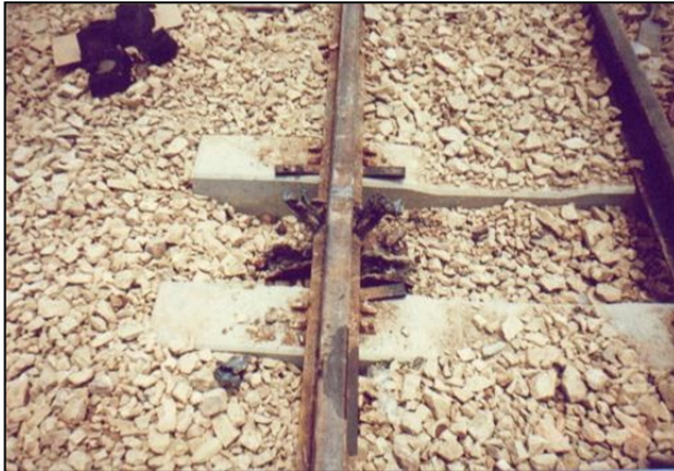
Imagen 62. Soldadura en enfriamiento sin excesos de material. Obsérvese las toberas de llenado
