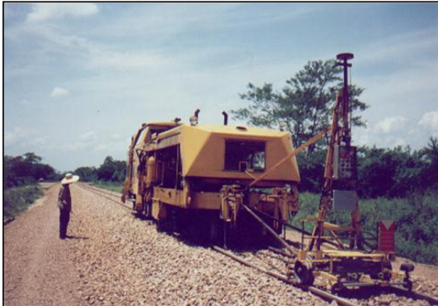
Imagen 68. Bateadora de mira óptica utilizada en el proyecto.
