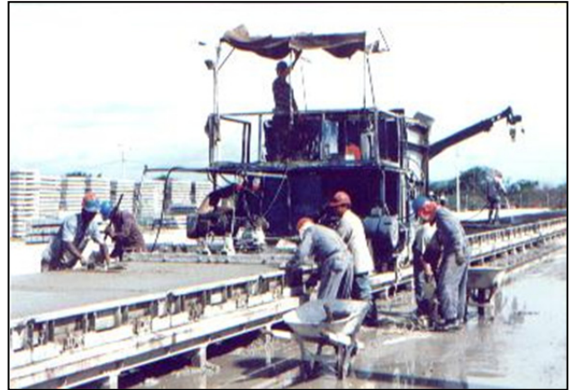
Imagen 20. Retiro de las platinas separadoras de las traviesas después del fraguado inicial
