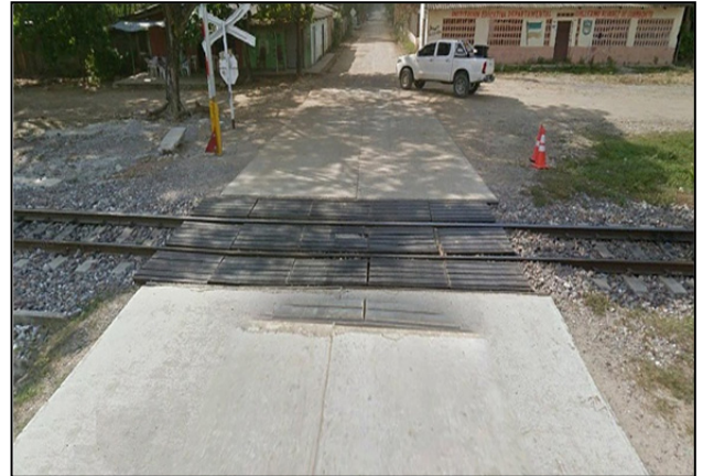
Imagen 73. Paso a nivel elaborado con contrarrieles en el cruce con vía secundaria en Guamachito
