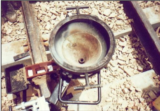
Imagen 56. Detalle del crisol, el molde y los soportes para iniciar el pre calentamiento para la soldadura
