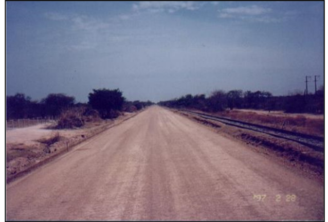
Imagen 6. Céreo de la capa de sub-balasto. Antesala al tendido de escaleras.
