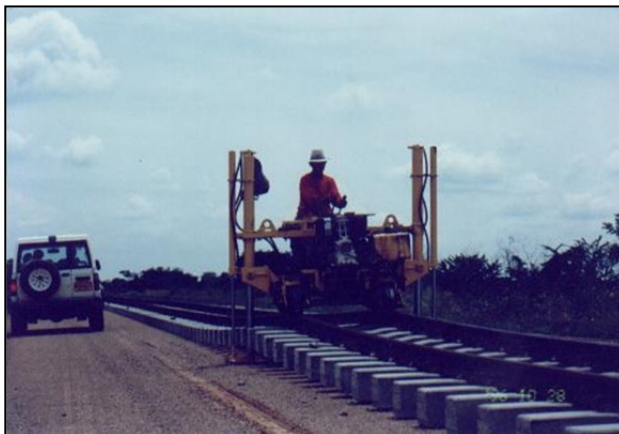
Imagen 46. Posicionadora centrando las escaleras con referencia al eje de vía identificado sobre el subbalasto mediante una estaquilla.
