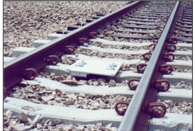
Imagen 93. Sensores pasivos (Balizas) localizados en puntos determinados de la vía para identificar la posición de los trenes.
