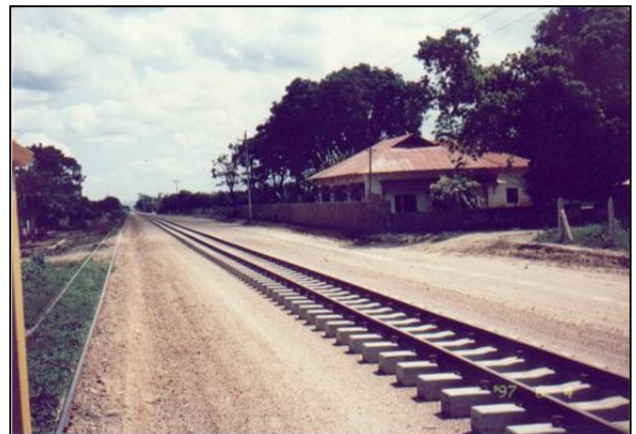
Imagen 47. Tendido de línea prealineada lista para riego de balasto y soldado de juntas.
