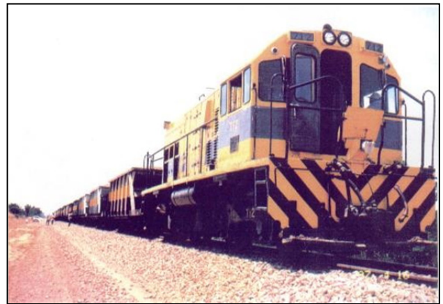
Imagen 51. Locomotoras de Ferrovías realizando el primer riego de balasto sobre la vía ya soldada.
