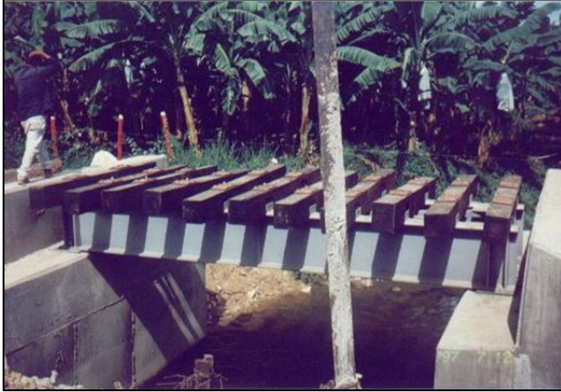
Imagen 7. Pontones (L = 5 m) localizados en la vía rehabilitada
