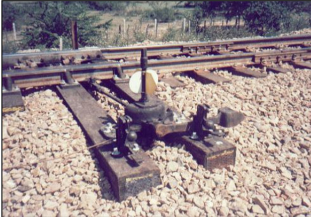
Imagen 100. Mecanismo de cambiavías utilizados en línea vieja.
