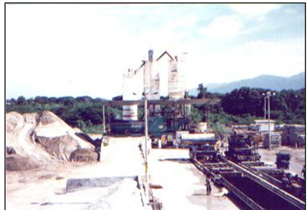
Imagen 16. Acopio de agregados pétreos para la producción del concreto de las traviesas
