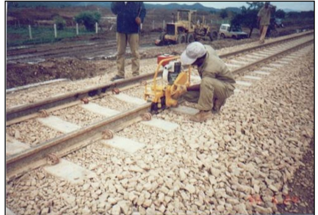
Imagen 63. Esmeriladora para acabado final de la soldadura
