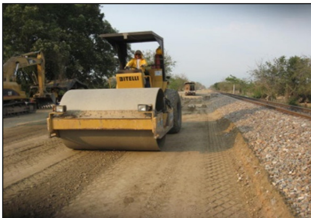
Imagen 78. Compactación del material del terraplén, antesala a la colocación de la capa de subbalasto
