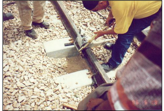
Imagen 53. Corte del riel para obtener la cala o separación de los rieles para efectuar la soldadura aluminotérmica
