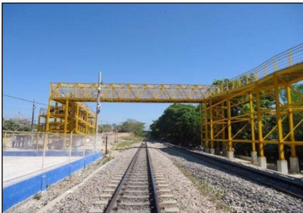
Imagen 86. Puente peatonal y de vehículos de 2 ruedas construido en reemplazo de los pasos a nivel convencionales
