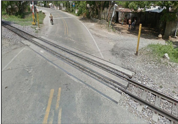
Imagen 72. Paso a nivel empotrado en losa de concreto en el cruce con vía principal en Aracataca
