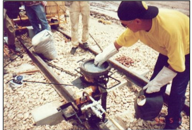
Imagen 57. Encendido de la carga para reaccionar el metal fundido
