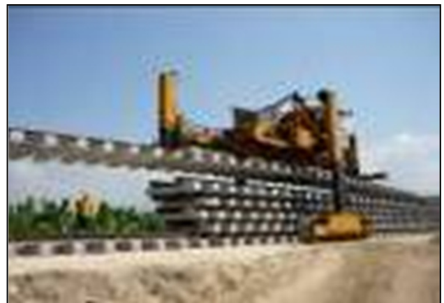
Imagen 79. Tendido de las escaleras
