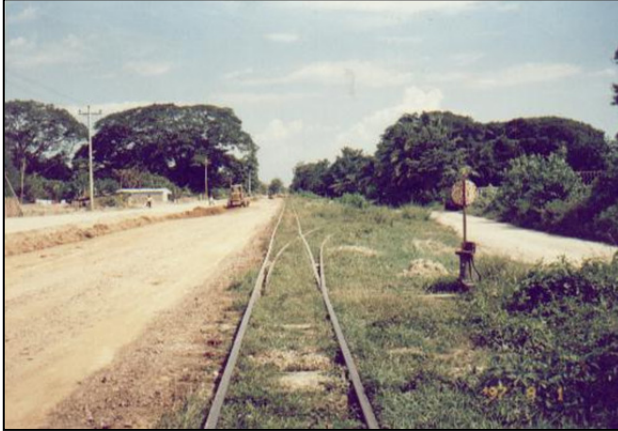
Imagen 96. Cambiavías utilizado en línea vieja
