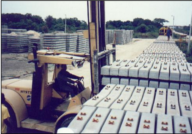
Imagen 37. Acopio de traviesas para transporte a sitio de premontaje de escaleras
