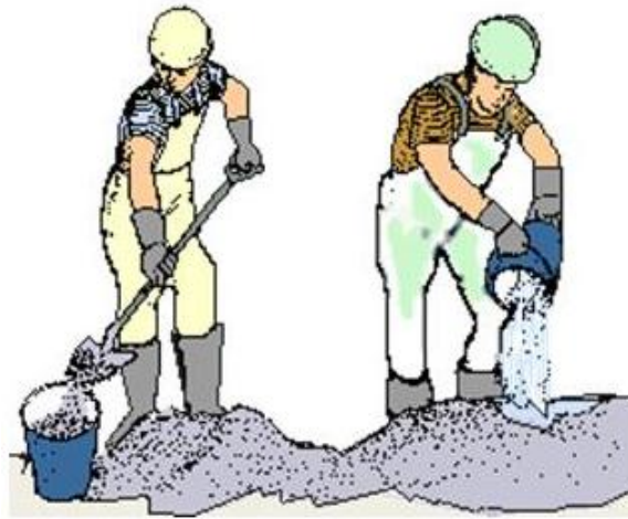
Figura 40. Preparación de mortero de pega
