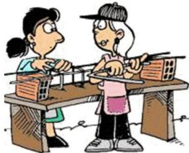
Figura 15. Armado de canasta para viga y columna
