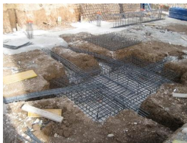
Figura 64. Colocación de acero inferior de la zapata
