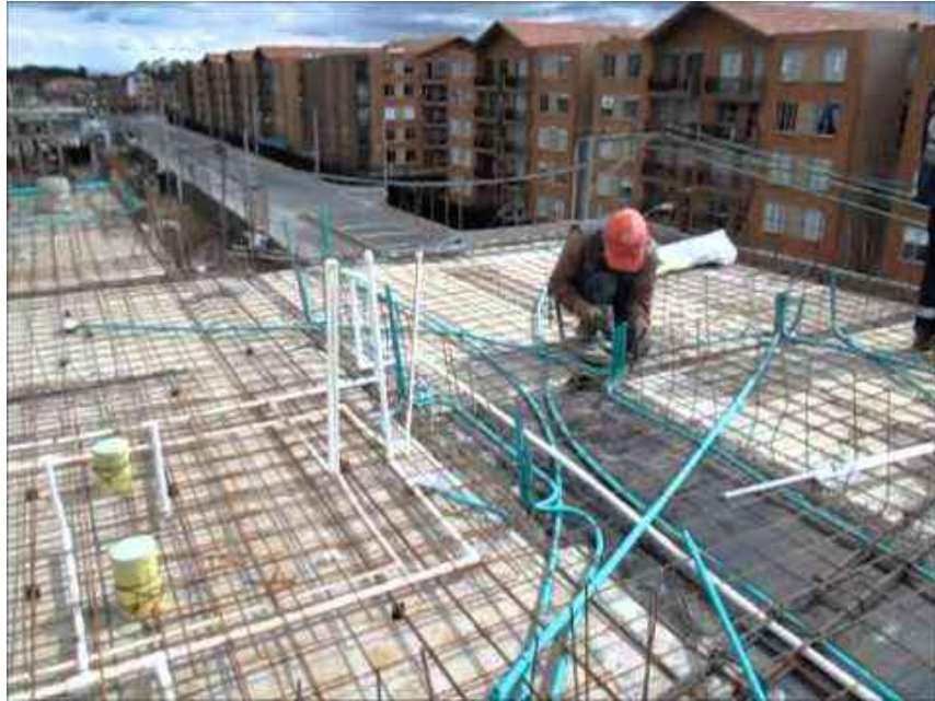
Figura 85. Instalación de ductos eléctricos
