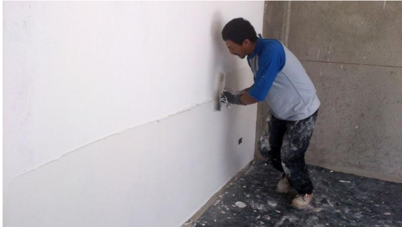
Figura 104. Preparación de la superficie
