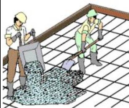
Fundida de losa maciza
