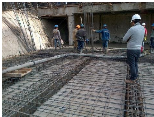
Figura 74. Fundida de la viga
