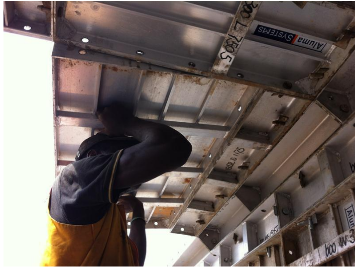
Figura 89. Desencofrado o retiro de formaletas
