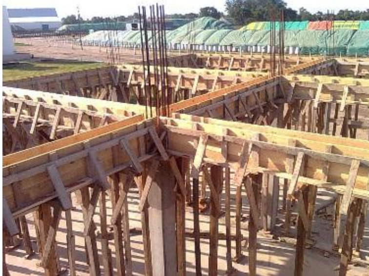
Figura 71. Trasladar y emplazar la canasta
