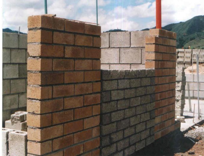
Figura 95. Acabado del muro
