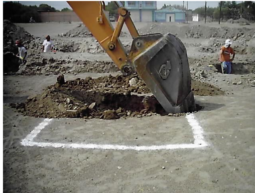
Figura 60. Trazo a excavación
