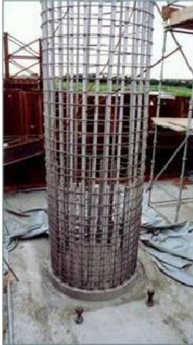
Figura 73. Clavar y arriostrar el encofrado
