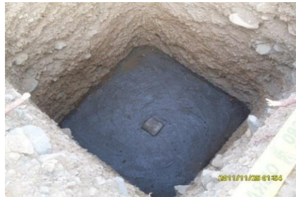
Figura 63. Colocación del concreto pobre.
