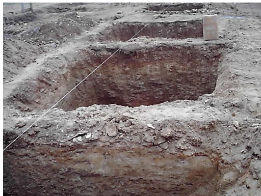
Figura 61. Excavación del terreno
