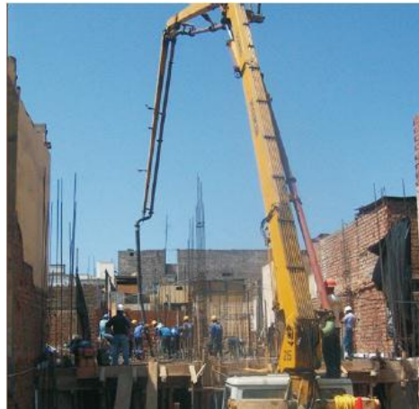
Figura 81. Vaciado de concreto vibrándolo
