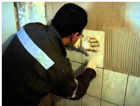
Figura 113. Instalación del enchape
