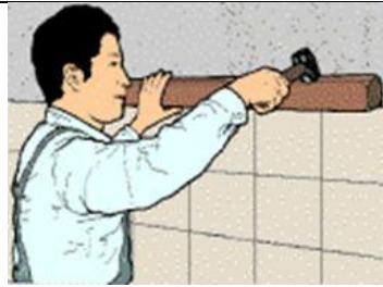
Figura 54. Horizontalidad de las hiladas de enchape
