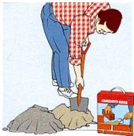
Figura 98. Preparar mortero según dosificación
