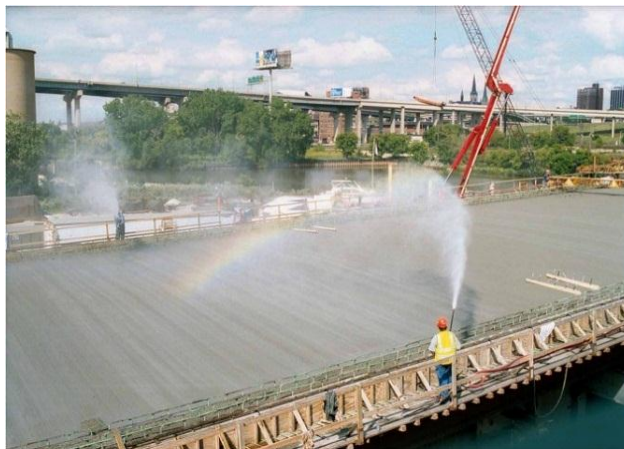
Figura 88. Curado y protección del hormigón
