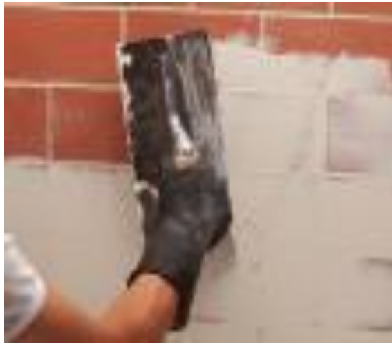
Figura 106. Proceso de aplicación del estuco
