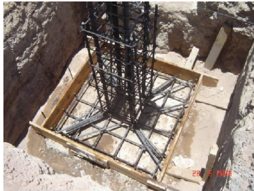
Figura 65. Colocación de acero vertical del dado de la columna
