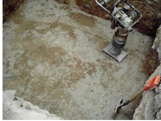
Figura 62. Compactación del terreno.
