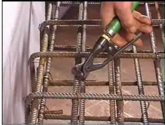
Figura 69. La figuración de los estribos
