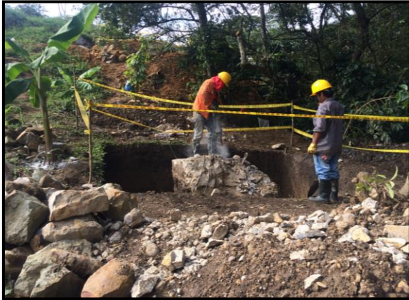
Figura 79: Demolición de estructura en concreto existente en el pórtico A
