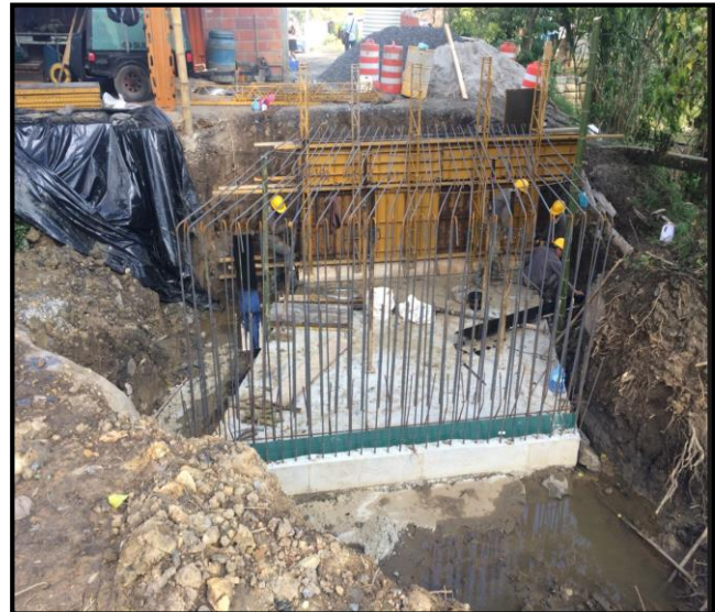
Figura 85: Colocación de formaleta para el muro del BOX COULVERT N° 1
