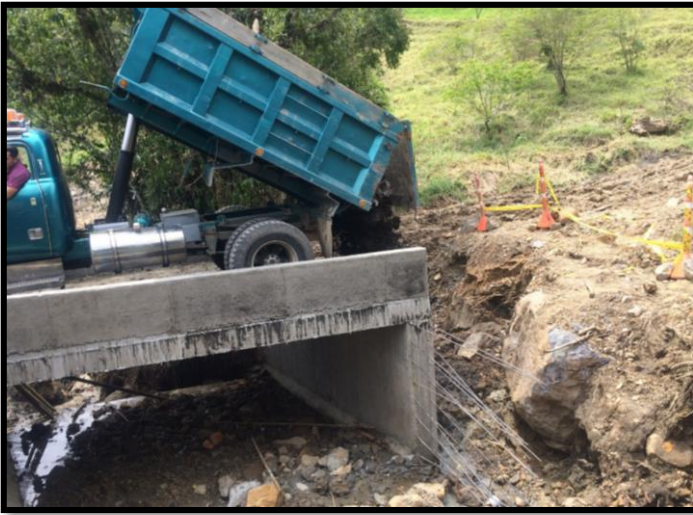
Figura 150: Relleno de material a los costado del BOX COULVERT N°1
