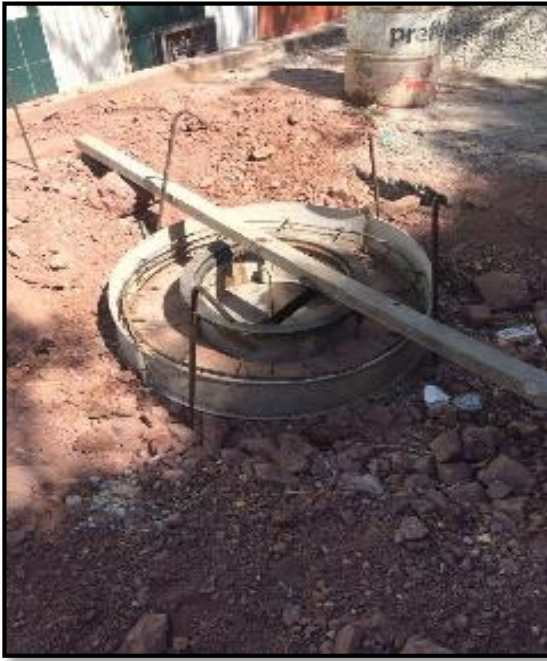
Figura 18: Corona del pozo de inspección
