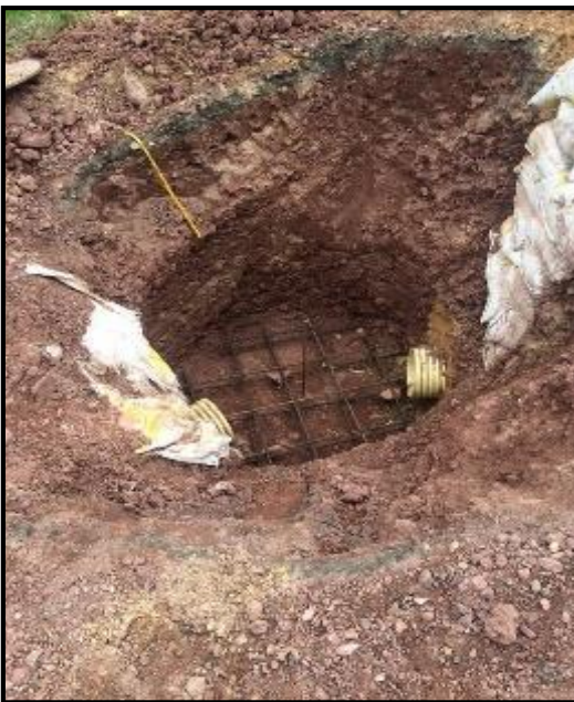
Figura 12: Armado de acero de refuerzo para placa del pozo de inspección
