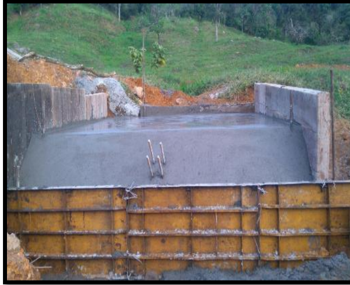
Figura 83: Fundida del contrafuerte N°2
