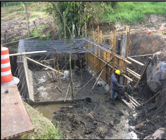
Figura 92: Instalación de formaleta del muro lateral derecho.
