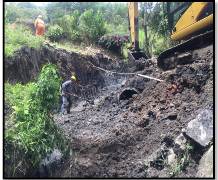
Figura 141: Demolición de alcantarilla existente y excavación para el BOX COULVERT N°2
