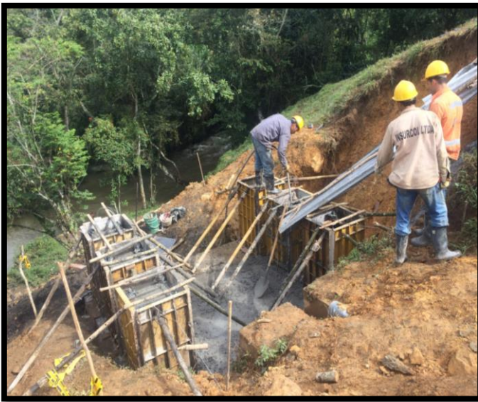
Figura 130: Vibrado del pedestal del pórtico B
