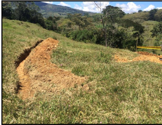
Figura 51: Solución a las inundaciones
