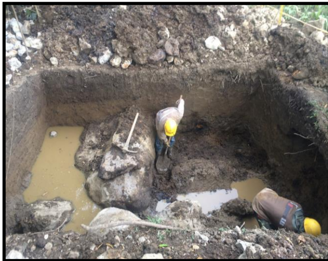
Figura 107: Excavación manual para el cimiento del pórtico A y filtración en la excavación
