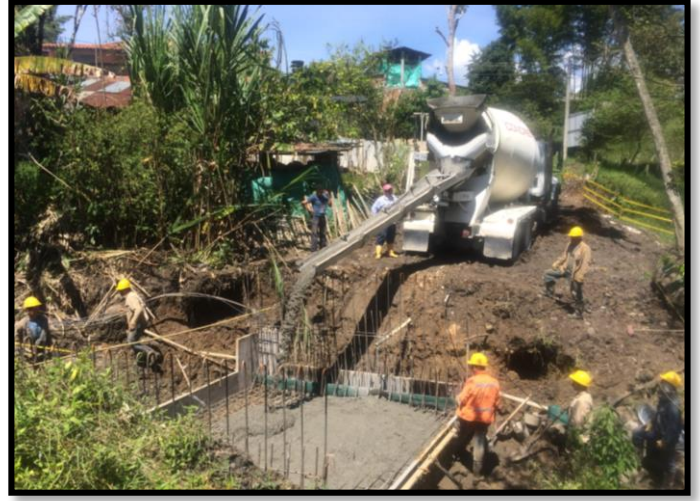
Figura 149: Fundida de la placa piso del BOX COULVERT N°2
