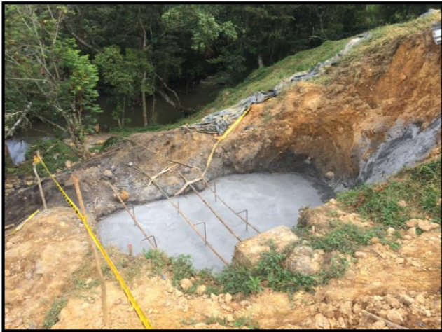
Figura 75: Concreto ciclópeo y anclado de hierro en el pórtico B
