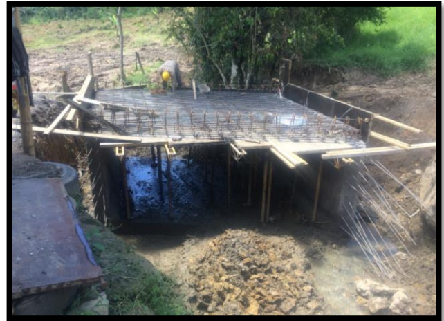
Figura 94: Armado de acero de refuerzo e instalación de formaleta de la placa superior del BOX COULVERT 1
