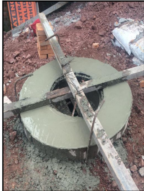
Figura 18: Corona del pozo de inspección
