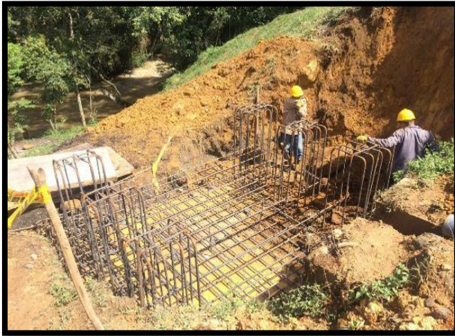
Figura 99: Armado de acero de refuerzo del pedestal para el pórtico B
