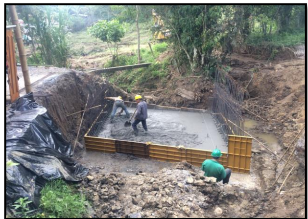
Figura 74: Acabado del concreto
