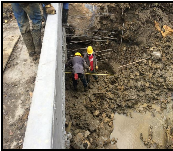
Figura 163: Excavación para la aleta de entrada del muro lateral derecho del BOX COULVERT N°1
