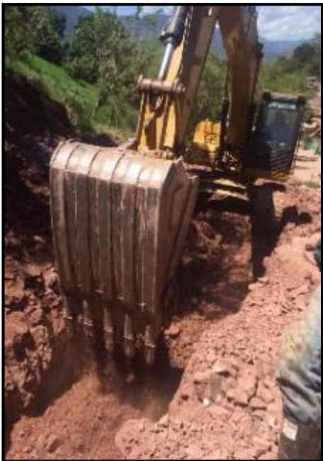
Figura 9: Excavación e Instalación de tubería de 42"
