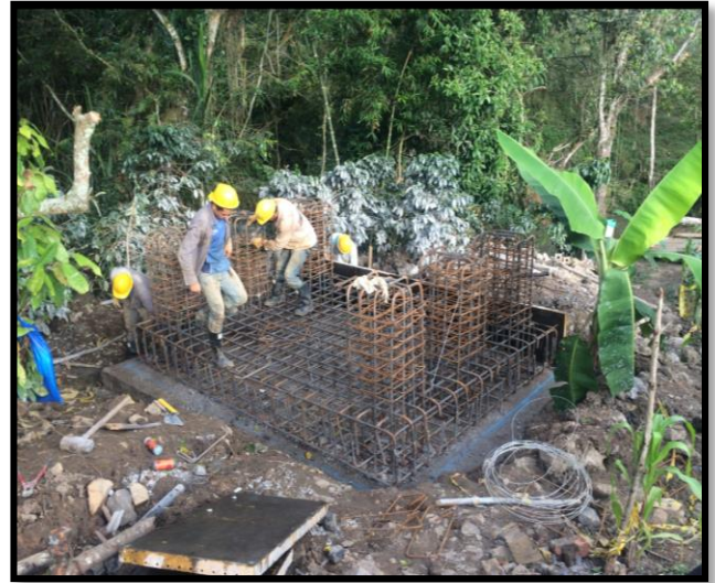
Figura 133: instalación de acero de refuerzo para el pedestal del pósito A
