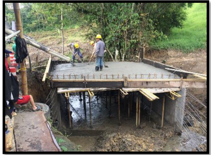
Figura 111: fundida con mixer de la placa superior del BOX COULVERT N°1
