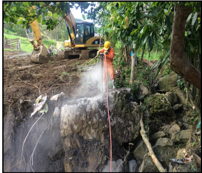
Figura 93: Demolición de roca en el canal de la quebrada Barinas.
