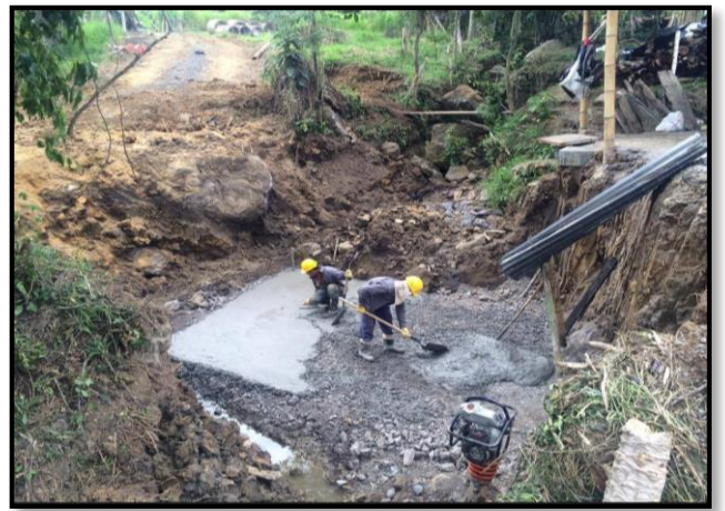
Figura 70: Mejoramiento de la resistencia del terreno
