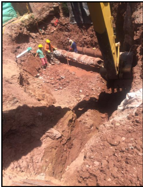
Figura 28: Excavación tramo para tubería de 27" agua negra
