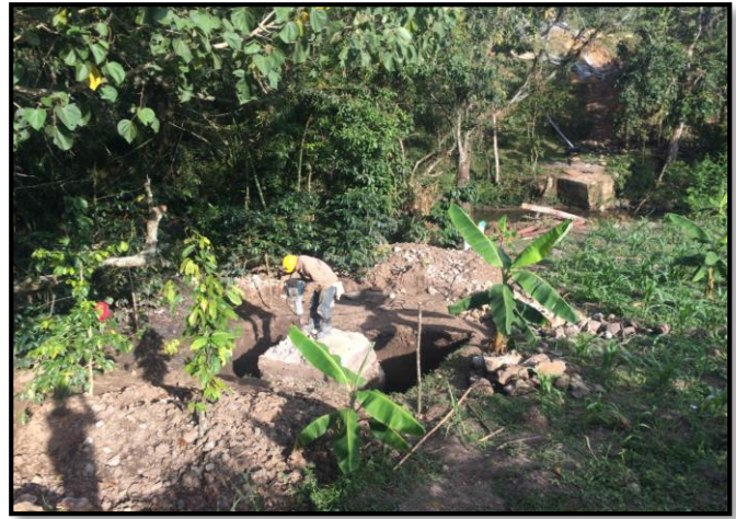
Figura 76: Demolición de estructura en concreto existente en el pórtico A
