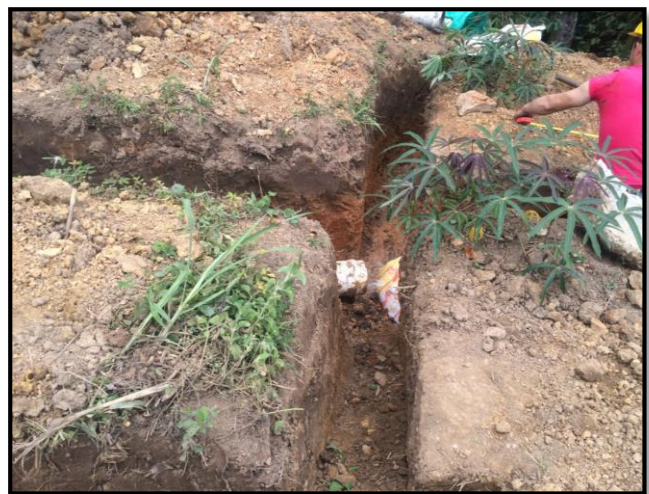
Figura 62: Desvió del agua de la tubería del acueducto existe
