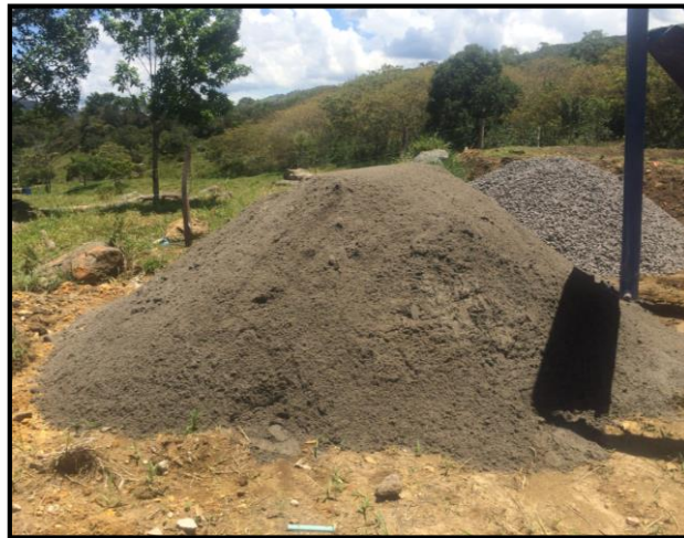
Figura 50:Suministro de material
