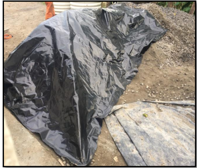
Figura 121: Tapado de material acopiado en obra.
