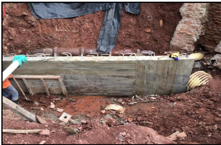
Figura 32: muro de la estructura de separación
