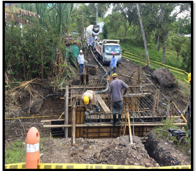
Figura 164: Fundida y vibrado para los muros del BOX COULVERT N°2
