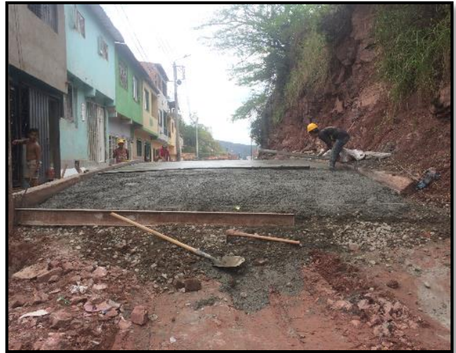
Figura 36: Reparación de losa de concreto
