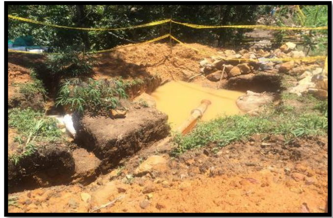
Figura 102: inundación de excavación del contrafuerte N°1
