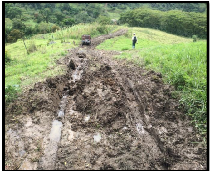
Figura 127: Condiciones del terreno que conduce al lugar de trabajo
