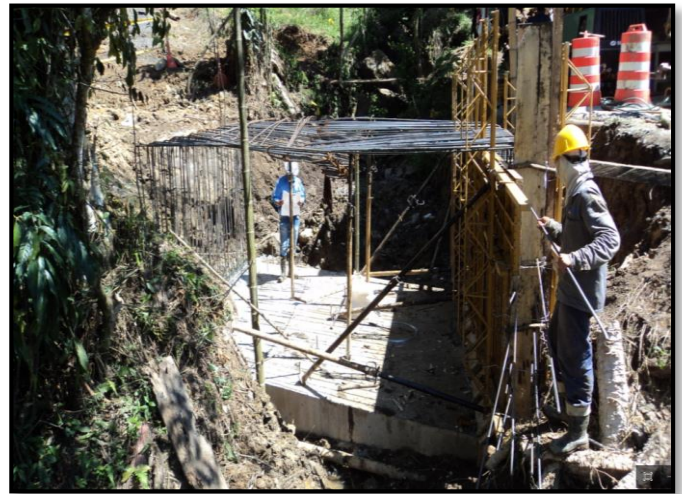
Figura 87: Instalación del acero de refuerzo de la aletas en el BOX-COULVERT N°1
