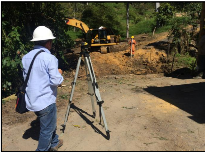
Figura 65: Replanteo topográfico
