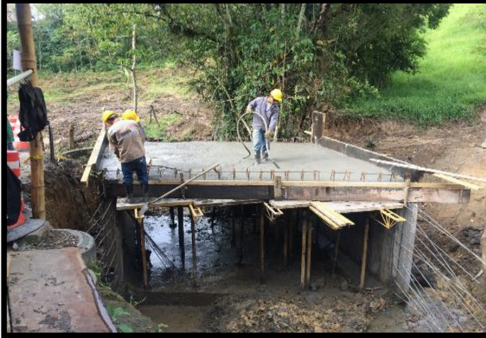
Figura 112: vibrado de la placa superior del BOX COULVERT N°1
