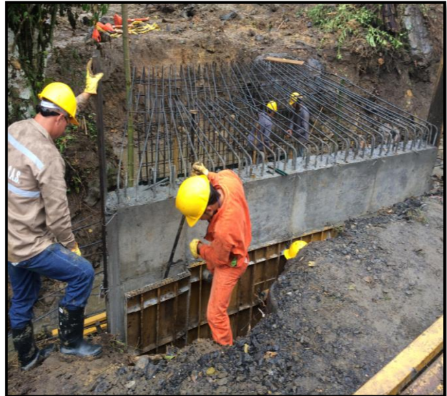
Figura 91: Retiro de la formaleta del muro lateral izquierdo del BOX-COULVERT N°1
