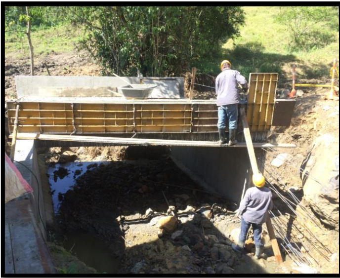
Figura 138: fundida del guarda ruedas ubicado en el sentido norte
