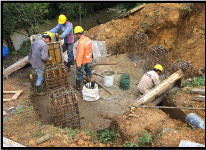
Figura 128: Instalación del acero de refuerzo y formaleta para el pedestal del pórtico B
