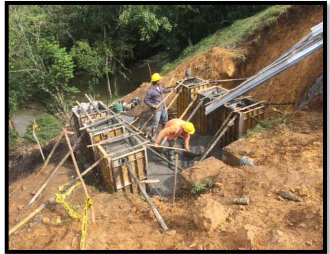
Figura 129: Fundida del pedestal del pórtico B
