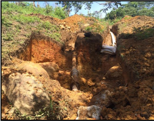
Figura 59: Excavación manual para cimiento de contrafuerte N° 1
