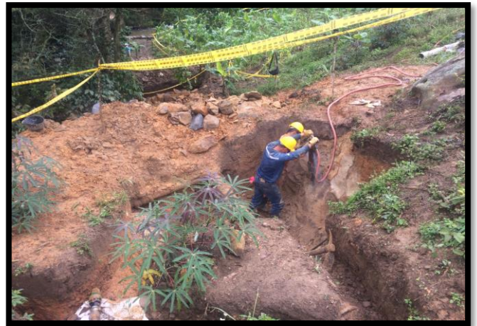
Figura 135: Demolición de material rocoso en la excavación del contrafuerte n°1
