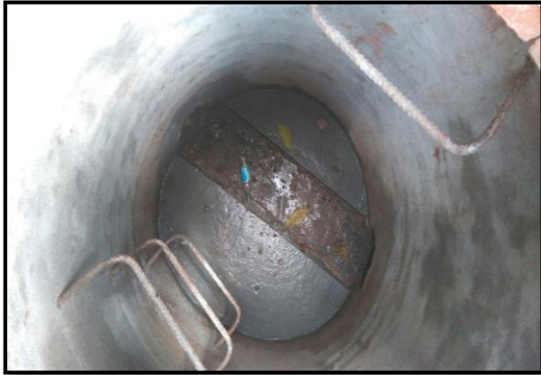
Figura 37:Cañuela de los pozos de inspección
