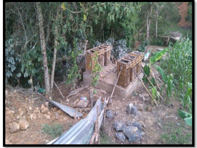
Figura 159: Instalación de platinas de acero, pernos y formaleta para el pedestal del pórtico A
