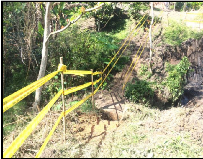
Figura 142: Sendero peatonal al costado occidental del BOX COULVERT N°2
