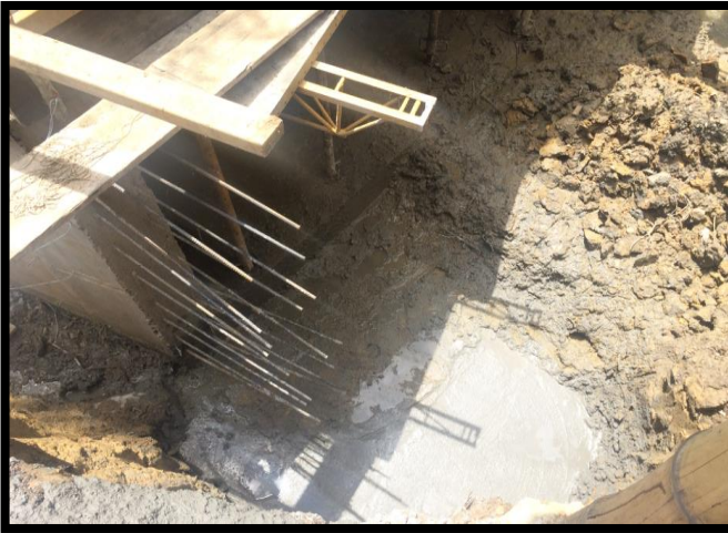
Figura 95: Fundida de solado de la aleta de entrada del muro lateral izquierdo
