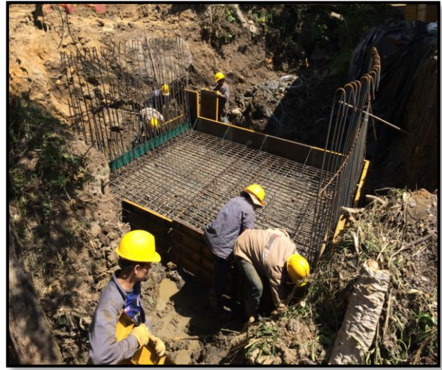
Figura 72: Colocación de formaleta para la placa del BOX COULVERT N°1
