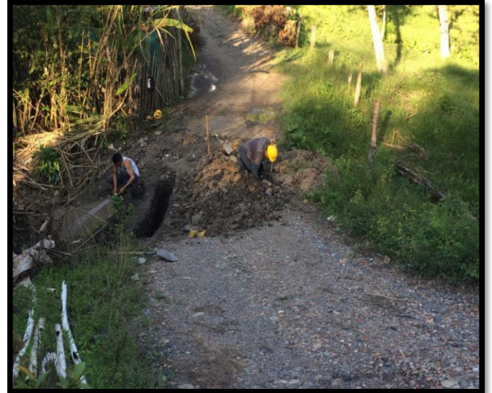
Figura 137: apiques de las redes domiciliarias que atraviesan el paso donde se procederá a construir el BOX COULVERT 2
