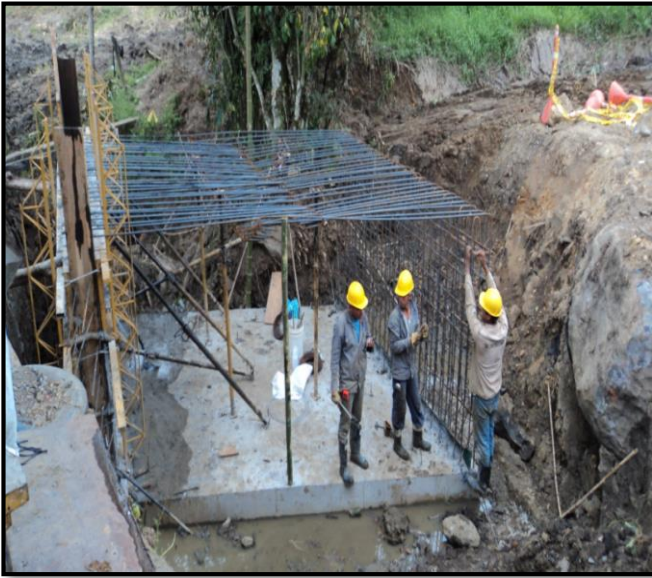
Figura 90: Armado del acero de refuerzo del muro lateral derecho.
