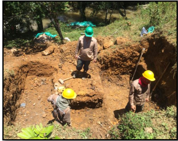
Figura 42: Excavación manual para cimiento del contrafuerte N°2 y pórtico B
