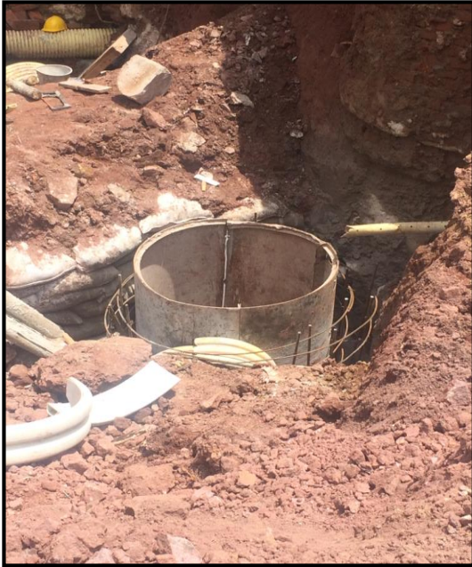
Figura 16: Cilindro del pozo de inspección
