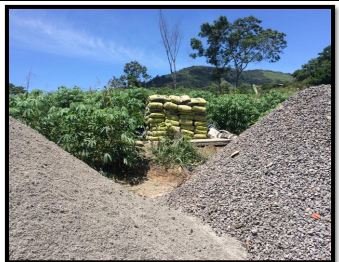
Figura 123: Acopio de materiales
