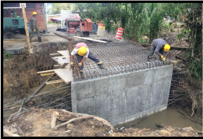
Figura 94: Armado de acero de refuerzo e instalación de formaleta de la placa superior del BOX COULVERT 1
