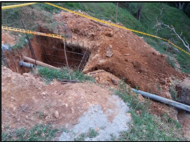
Figura 81: Armado de acero de refuerzo para el contrafuerte N° 2 y Zanja para la tubería de acueducto que conecta al contrafuerte N° 2 y el pórtico B
