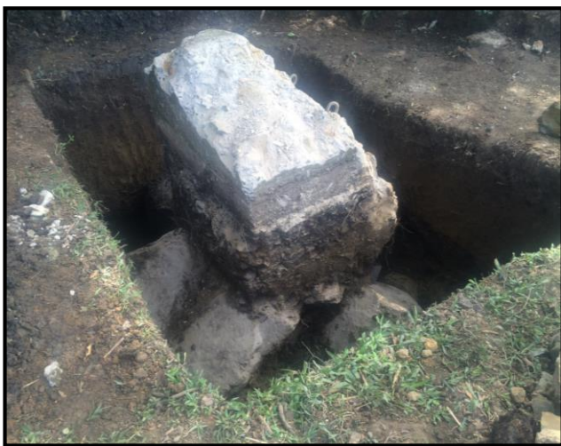
Figura 61: Roca en la excavación para cimiento del pósito A y demolición de estructura en concreto existente
