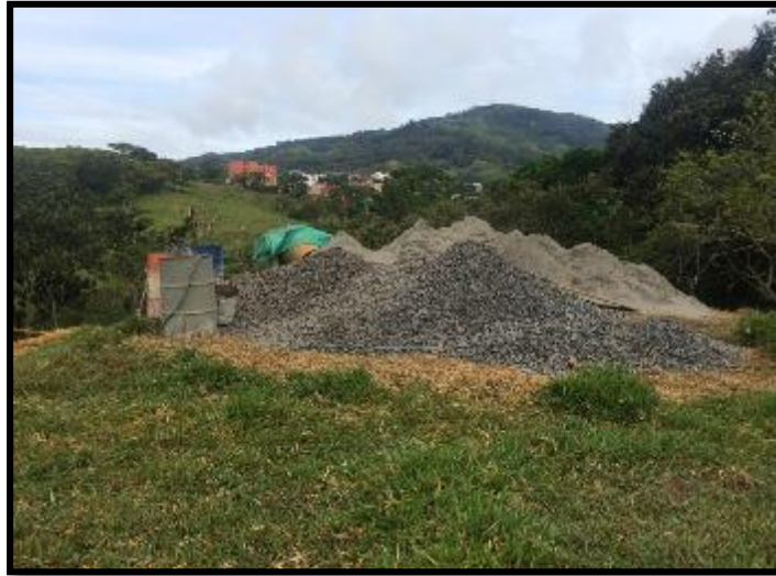
Figura 176: Adecuación del lugar para los materiales en obra
