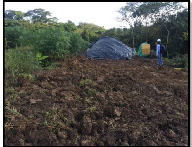
Figura 125: Tapado del material puesto en obra
