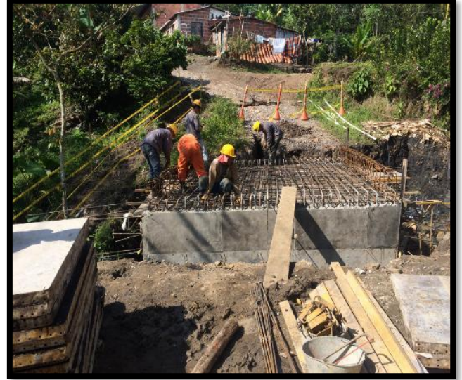
Figura 166: Instalación de acero de refuerzo y formaleta para la placa superior del BOX COULVERT N°2
