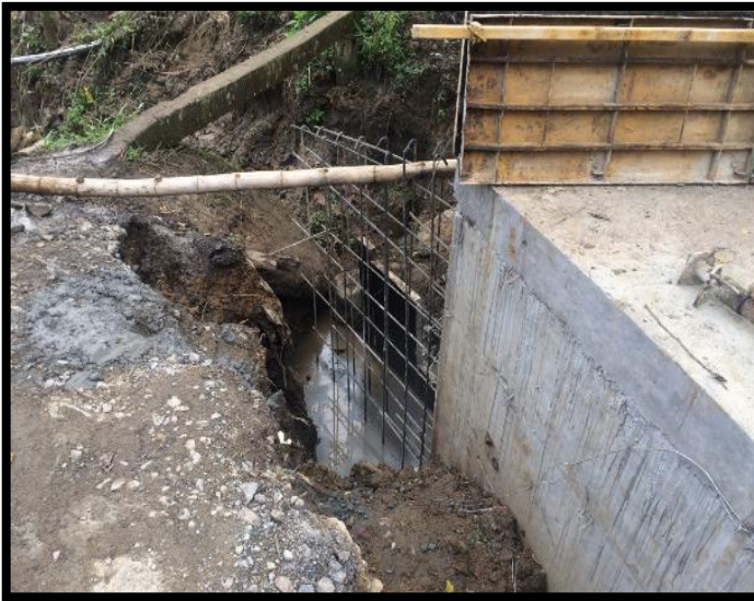
Figura 120: Instalación de acero de refuerzo para la aleta de salida del muro lateral izquierdo del BOX COULVERT N°1
