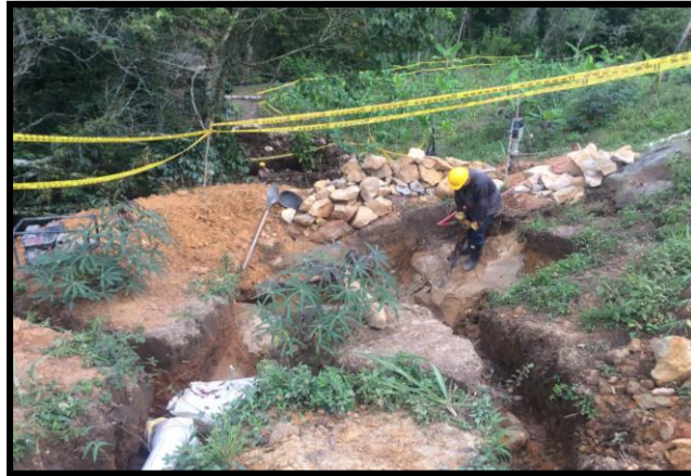
Figura 109: Demolición de roca en el contrafuerte N°1
