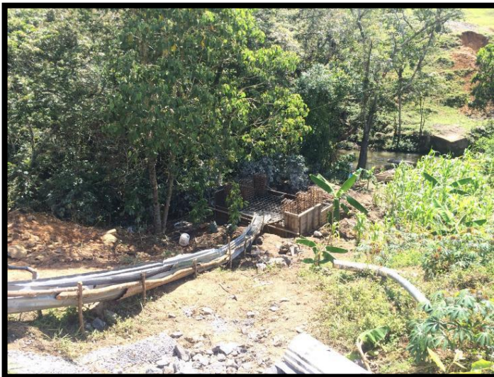
Figura 154: Fundida del pedestal del pórtico A
