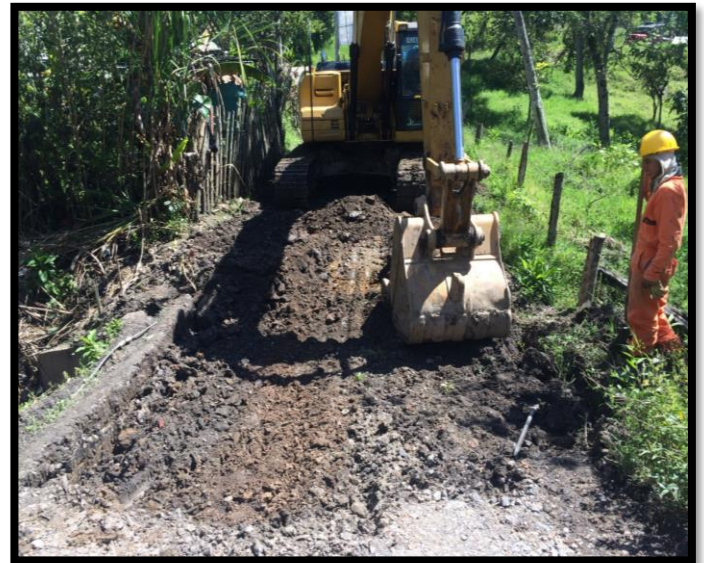
Figura 139: Búsqueda de tubería existente en el paso donde se construirá el BOX COULVERT N°2
