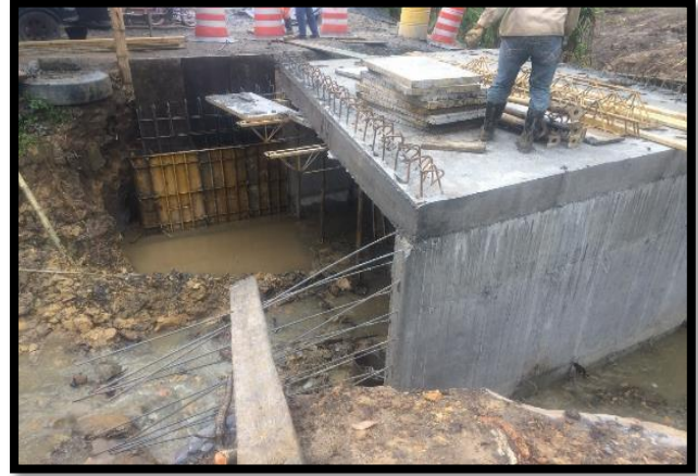
Figura 115: Armado de acero de refuerzo e instalación de la formaleta de la aleta de entrada del muro lateral izquierdo
