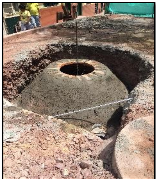
Figura 17: Mampostería del pozo de inspección
