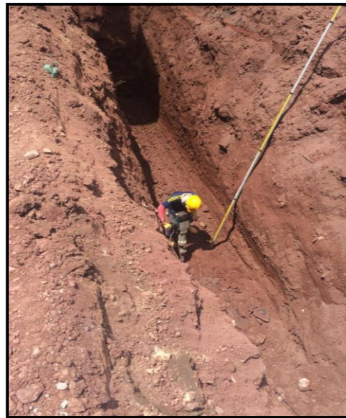
Figura 28: Excavación tramo para tubería de 27" agua negra
