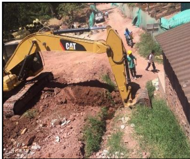
Figura 19: Excavación estructura de separación
