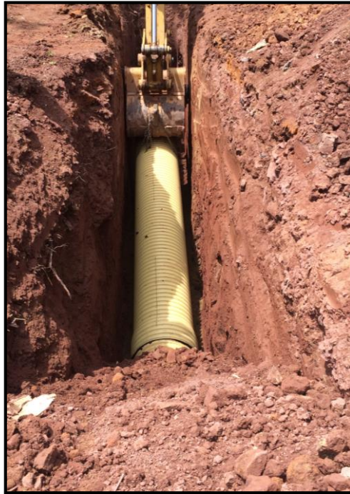
Figura 29: Instalación tubería 27" agua negra
