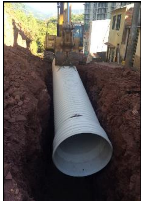
Figura 9: Excavación e Instalación de tubería de 42"
