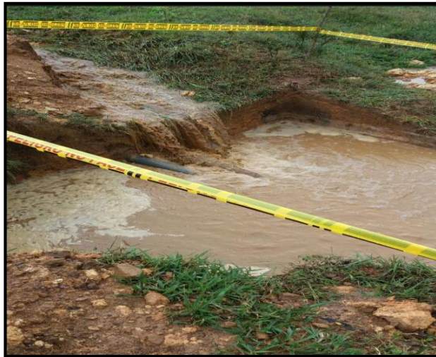
Figura 46: Inundación en las excavaciones
