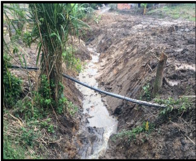
Figura 118: arreglo con máquina del derrumbe en el canal
