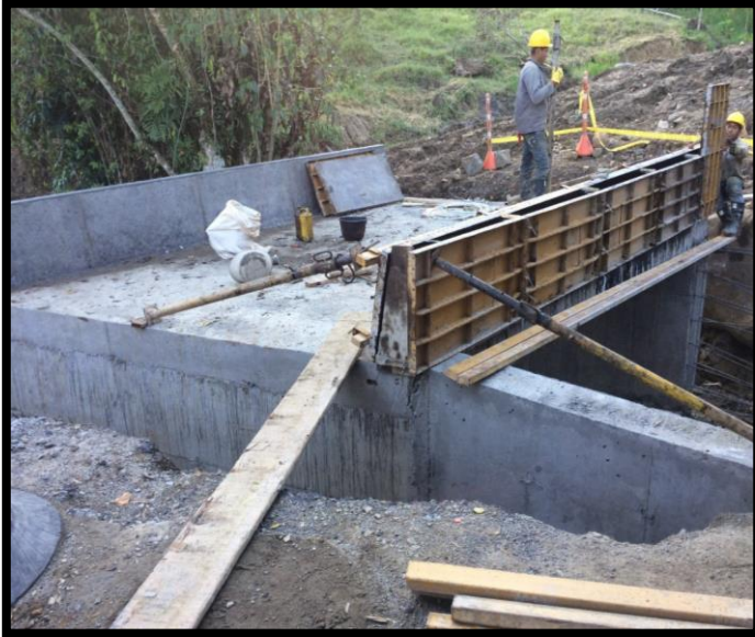
Figura 136: instalación de formaleta para el guarda ruedas ubicado en sentido norte del BOX COULVERT N°1
