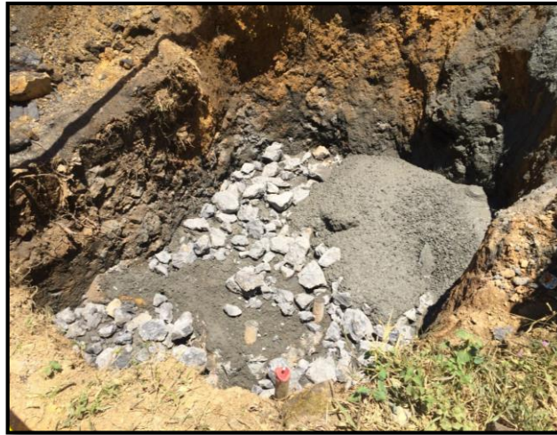
Figura 58: fundida ciclópeo pórtico B
