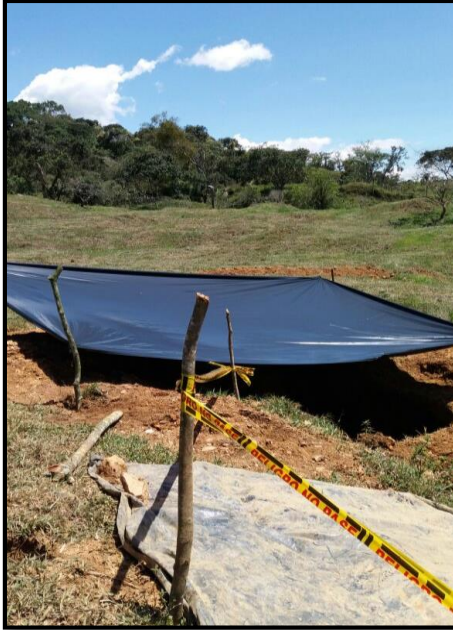
Figura 52: Plástico para prevenir la saturación del terreno
