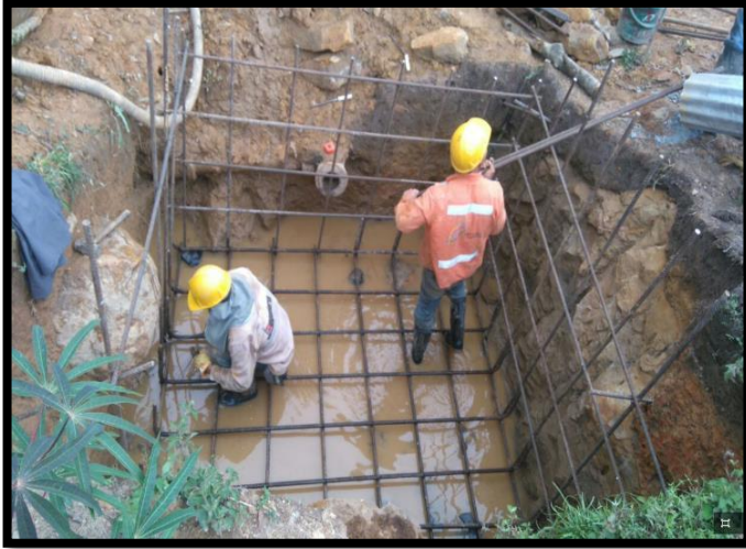
Figura 158: Instalación de acero de refuerzo para el contrafuerte N°1
