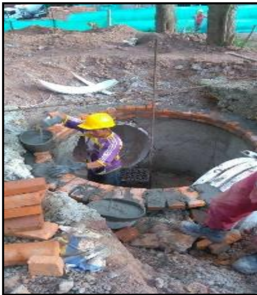
Figura 17: Mampostería del pozo de inspección
