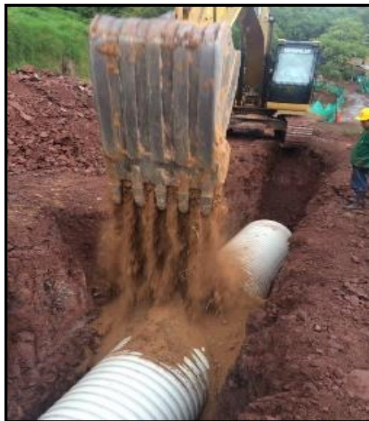
Figura 22: relleno y compactación de material seleccionado
