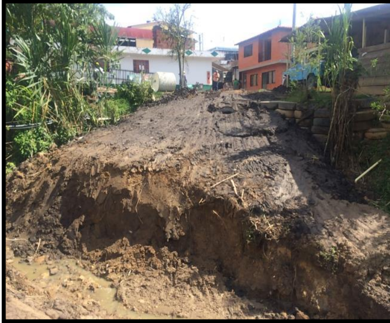
Figura 169: Relleno con material seleccionado
