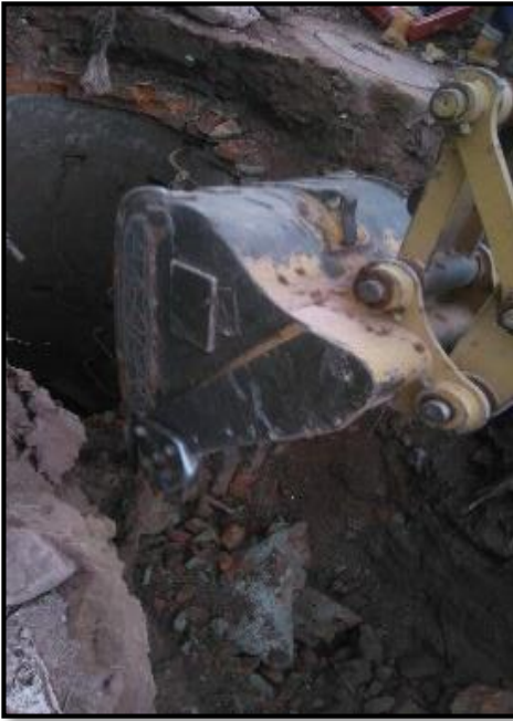
Figura 20: Demolición pozo P(CB-CRA2)L1
