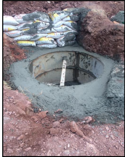
Figura 16: Cilindro del pozo de inspección
