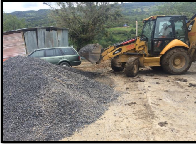
Figura 124: Transporte de material
