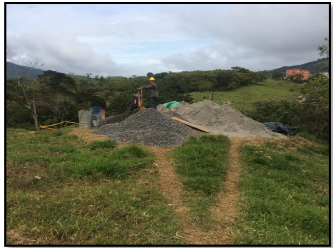
Figura 64: Transporte de material para la elaboración de concretos
