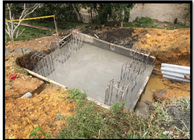
Figura 100: fundida de la base del pedestal del pórtico B
