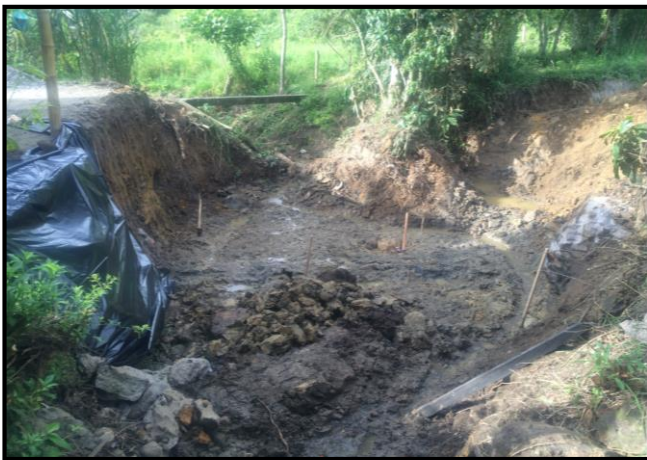
Figura 69: Excavación BOX COULVERT N°1
