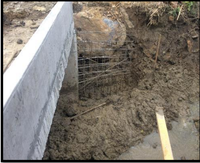
Figura 165: Instalación de acero de refuerzo para la aleta de entrada del muro lateral derecho del BOX COULVERT N°1
