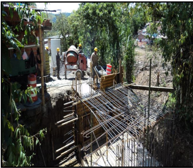
Figura 88: Fundida del muro lateral izquierdo del BOX-COULVERT N°1
