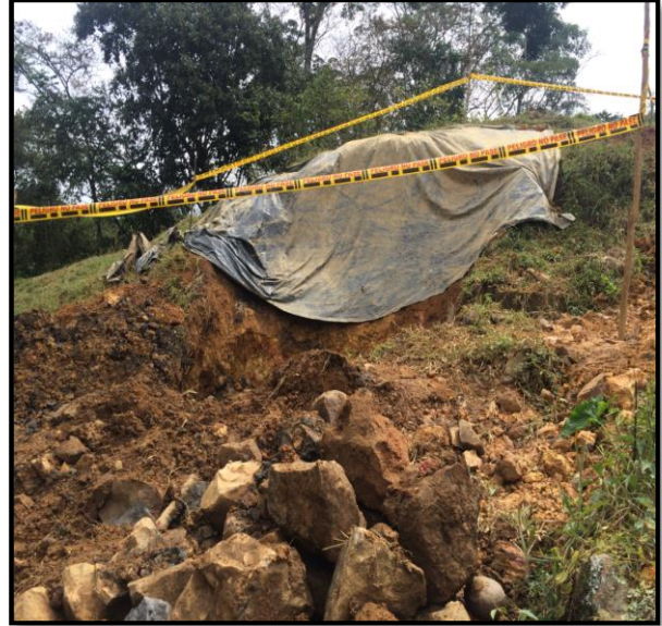
Figura 52: Plástico para prevenir la saturación del terreno
