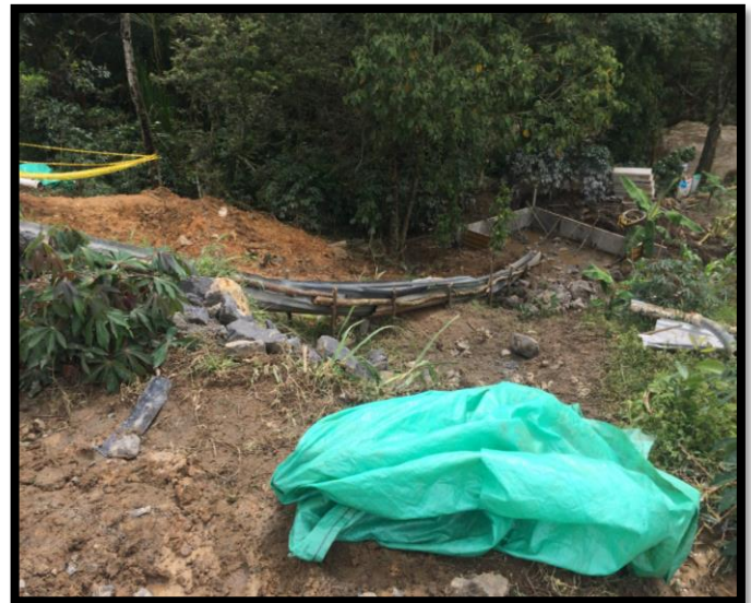
Figura 131: Fundida del ciclópeo del pórtico A
