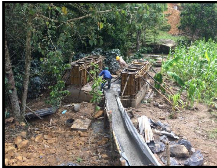
Figura 160: Fundida del pedestal del pórtico A
