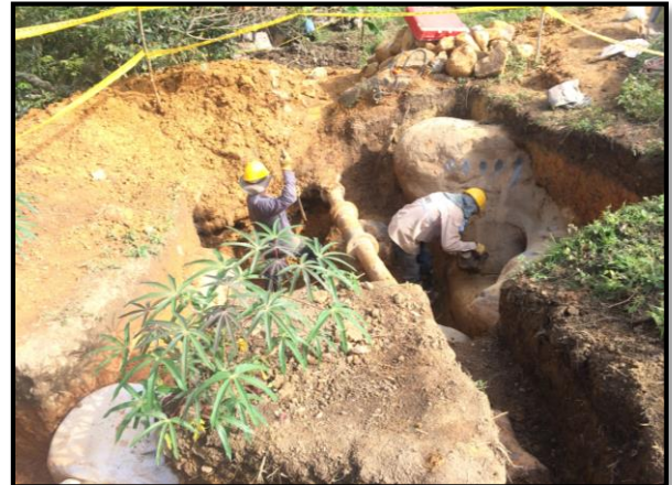
Figura 80: Aplicación de cemento cras al material rocoso y excavación manual del contrafuerte N°1
