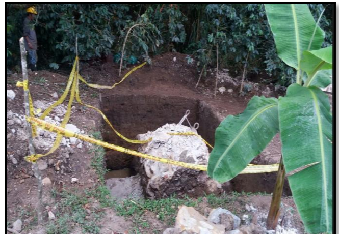
Figura 82: Excavación del pórtico A
