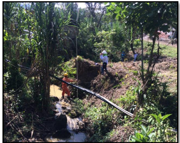
Figura 66: Localización del eje para el canal en la quebrada BARINAS
