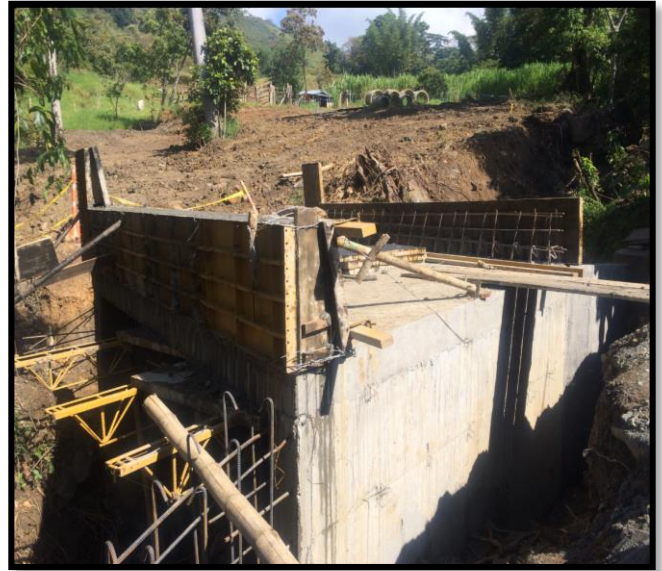
Figura 117: fundida del guarda rueda ubicado en sentido sur e instalación de acero de refuerzo para guarda rueda ubicado en sentido norte
