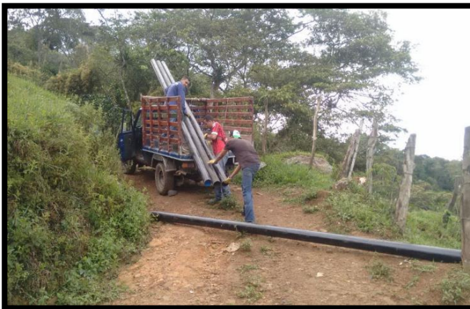
Figura 156: Transporte de tubería de acero al carbón D:5"
