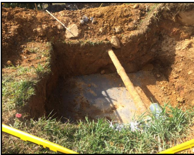
Figura 77: Solado del contrafuerte N°2
