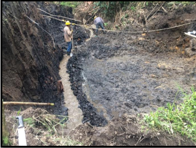
Figura 144: zanja para encauzar el agua en el BOX COULVERT N°2
