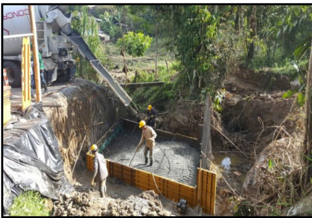
Figura 73: Fundida con mixer de la placa del BOX COULVERT N°1
