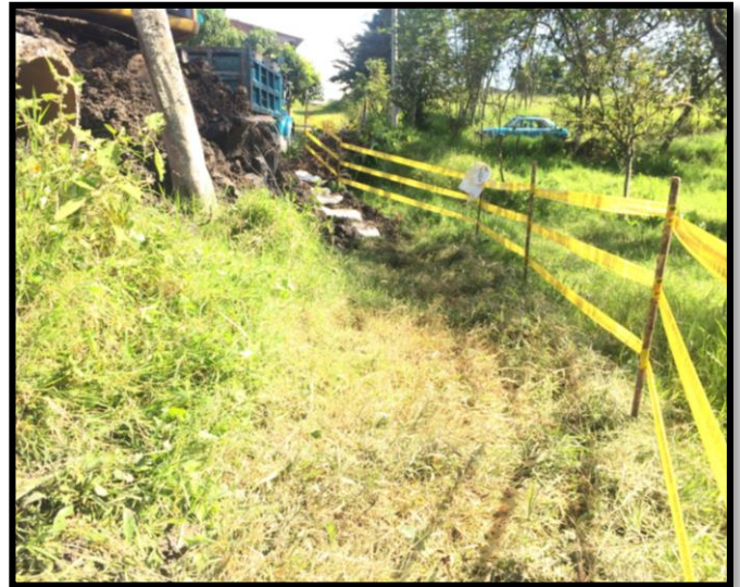
Figura 143: Sendero peatonal al costado occidental del BOX COULVERT N°2
