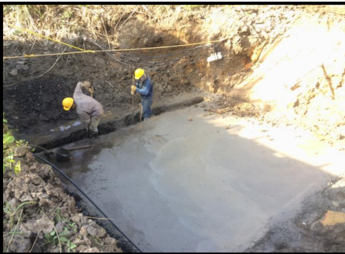
Figura 146: Fundida de solado y excavación de dentellón para el BOX COULVERT N°2
