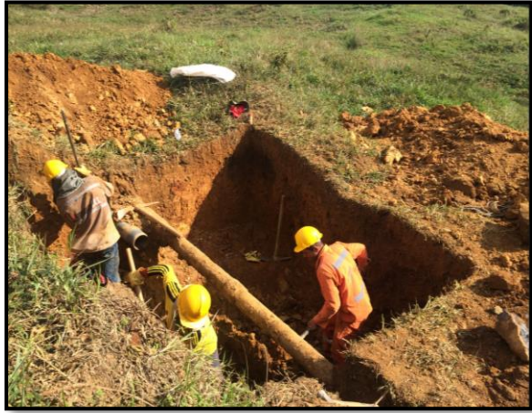
Figura 42: Excavación manual para cimiento del contrafuerte N°2 y pórtico B
