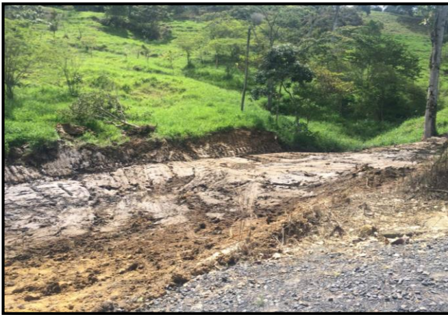
Figura 67: Desvió del cauce proveniente de la finca de Don Hugo García
