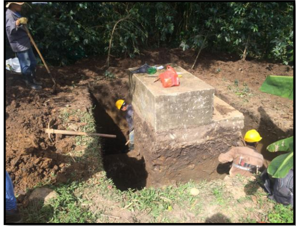
Figura 60: Excavación manual para cimiento de pósito A
