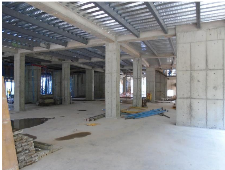
Fig 10. Sistema de sótanos Fuente: Autor
