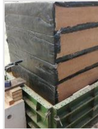
Fotografía 28. Instalación del geotextil y separación entre capas
