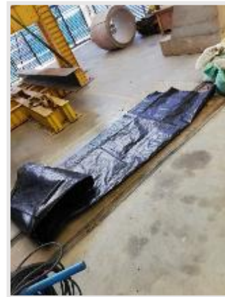
Fotografía 24. Corte del geotextil.
