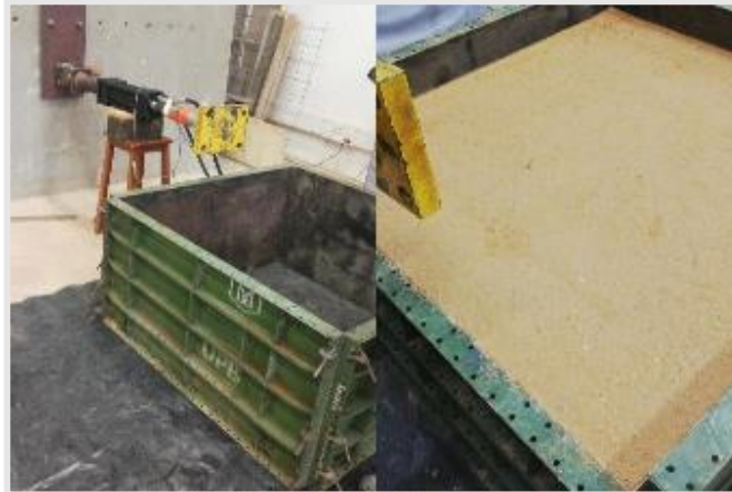
Figura 16. Modulación y compactación del suelo de fundación Fuente: Elaboración propia.
