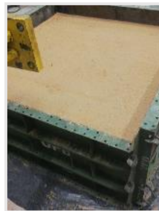
Fotografía 26. Nivelación del suelo de fundación
