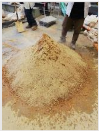
Fotografía 23. Dosificación del material con la humedad óptima.
