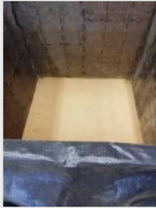
Fotografía 27. Instalación del geotextil
