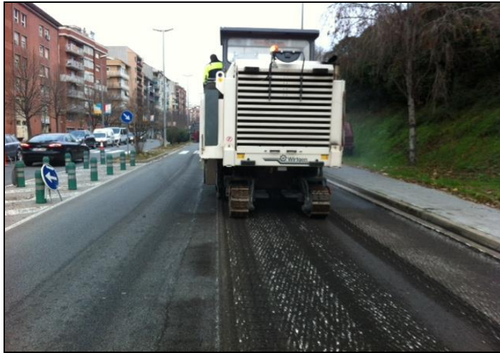
Fotografía 4 – Fresado poco profundo Fuente: WIRTGEN GROUP, Alemania (2016)
