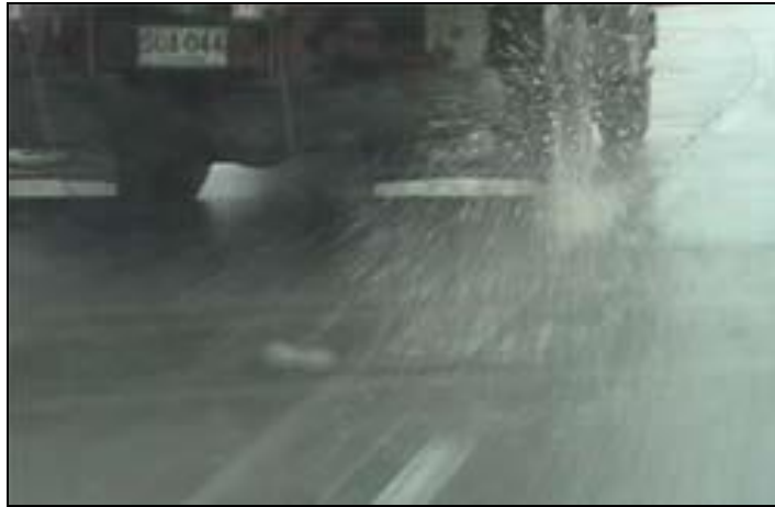
Fotografía 12. Efecto “Bombeo” en un pavimento de concreto Fuente: Elaboración propia
