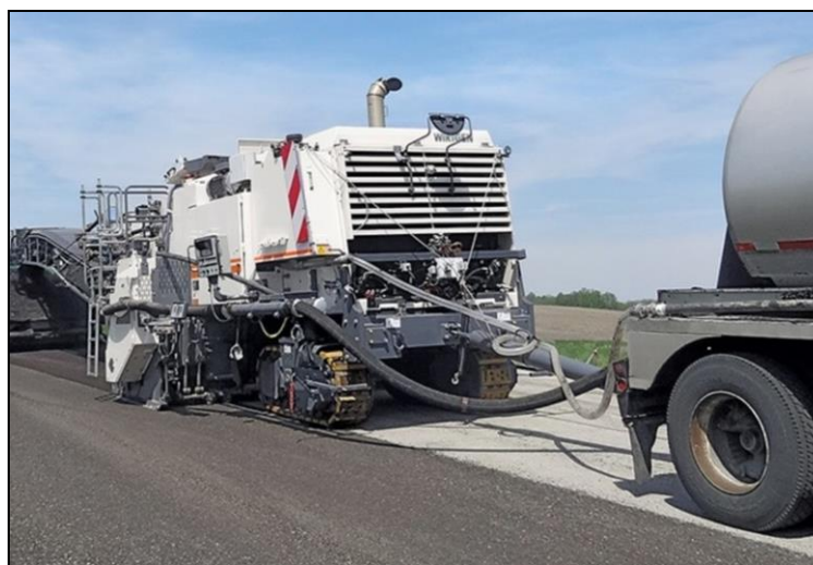
Fotografía 2. Proceso de intervención del RAP con adición de afirmado granular por técnica de reciclado Fuente: WIRTGEN GROUP, EUA (2016)
