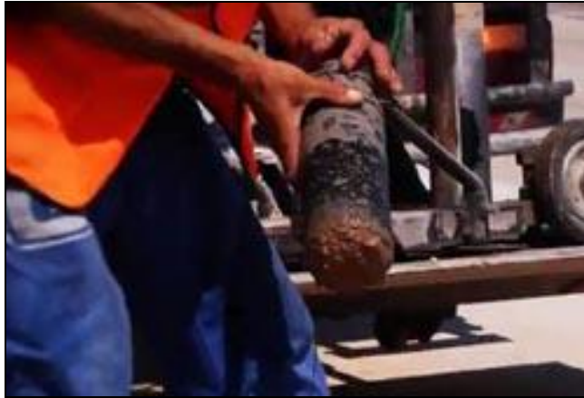
Fotografía 10. Extracción de núcleo en un pavimento tipo “Whitetopping” Fuente: Elaboración propia
