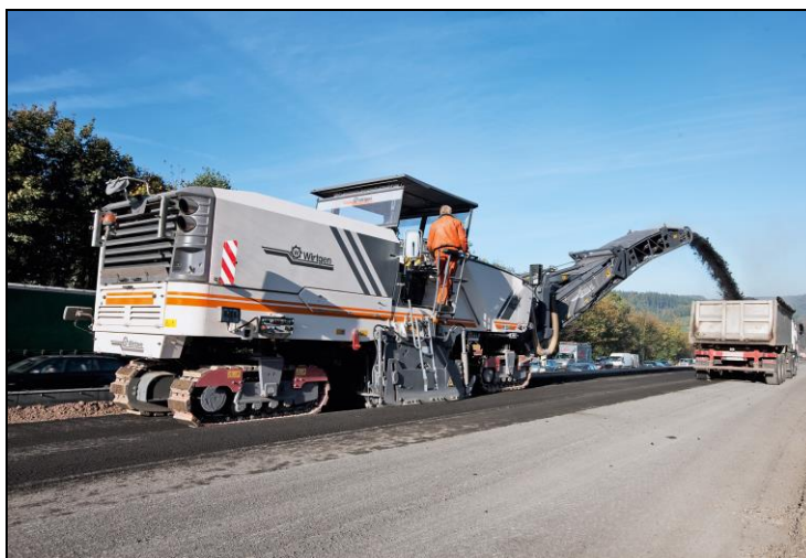
Fotografía 1. Proceso de intervención y obtención del RAP por técnica de fresado Fuente: WIRTGEN GROUP, EUA (2016) 2
