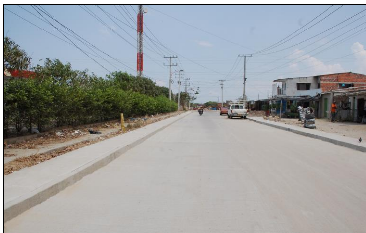
Fotografía 11. Condición de confinamiento – no condición de berma Fuente: Elaboración propia
