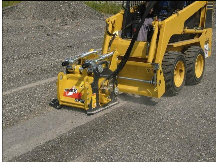
Fotografía 3. Fresado superficial Fuente: SIMEX GROUP, Francia (2016)
