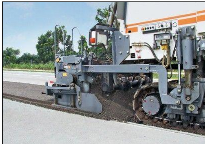
Fotografía 5 – Fresado profundo Fuente: WIRTGEN GROUP, Alemania (2016)
