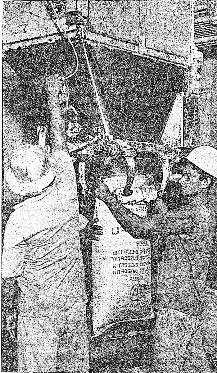
Los productos Abocol tienen un doble empaque: uno exterior de fique y uno interior de polietileno, para garantizar la calidad. En la gráfica se observa un aspecto de la máquina empacadora.
