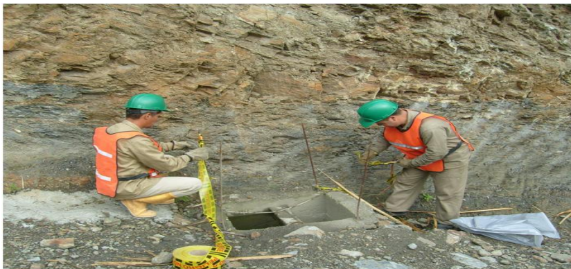
Foto 18. Señalización Estructuras de Drenaje.
