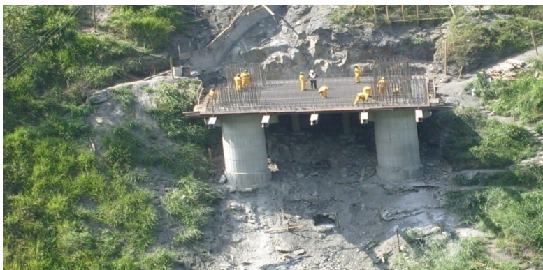
Foto 1. Proyecto Puente el Tigre, Frente de Obra Pila 1.
