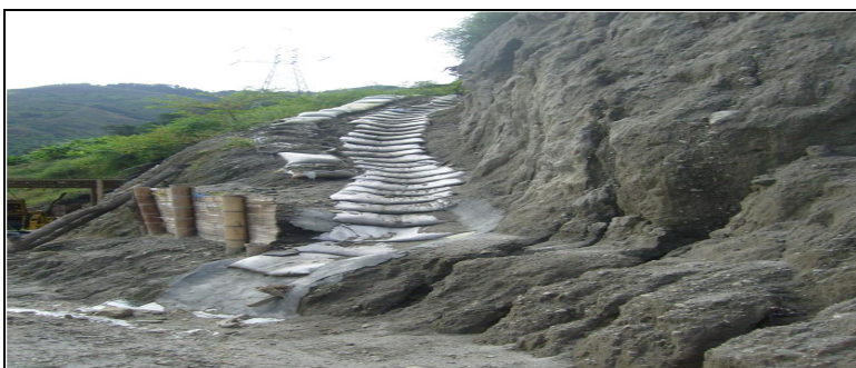
Foto 8. Cunetas en Saco-Suelo
