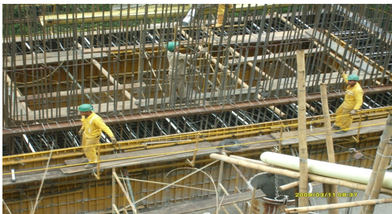
Foto 27. Colocación de Hierro Pila 1.
