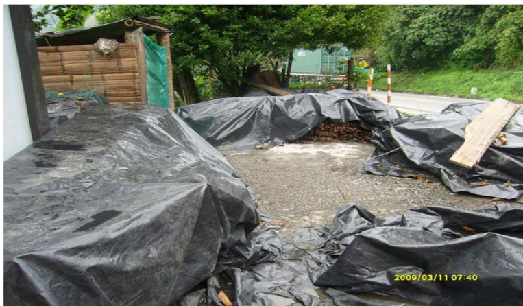
Foto 6. Protección de material metálico
