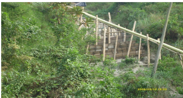
Foto 10. Trinchos en Esterilla, Estabilización de Taludes
