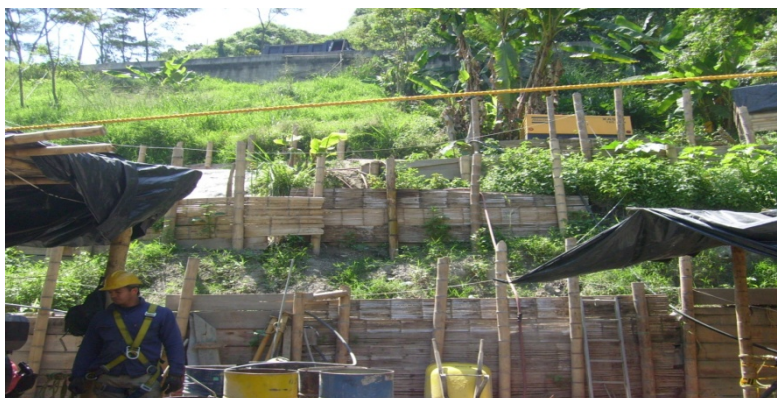
Foto 9. Trinchos Control de Erosión.
