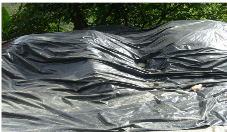
Foto 7. Protección de Agregados Pétreos
