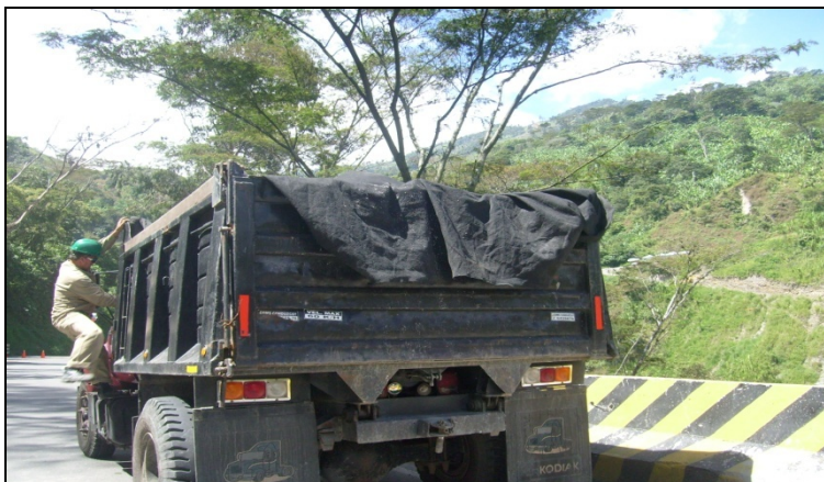
Foto 24. Medidas de Control, para Transporte de Material de Excavación.
