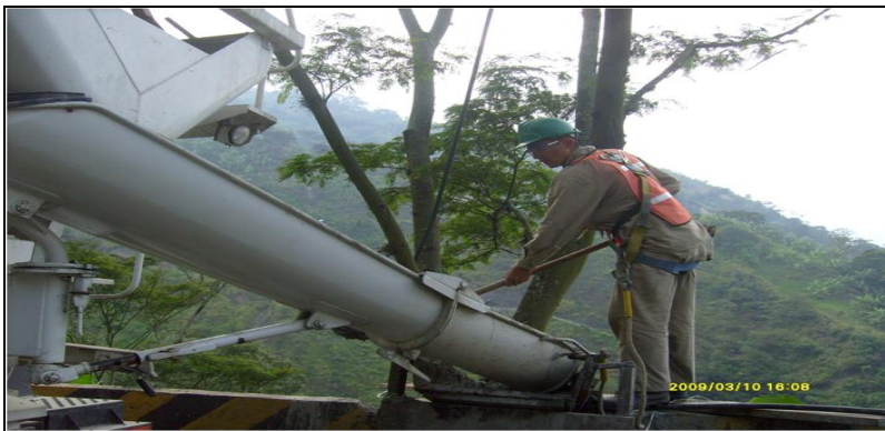
Foto 16. Colocación de Concreto en Obra
