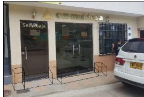
Fotografía 12. Ubicación vigas corridas en edificación del municipio de Ocamonte
