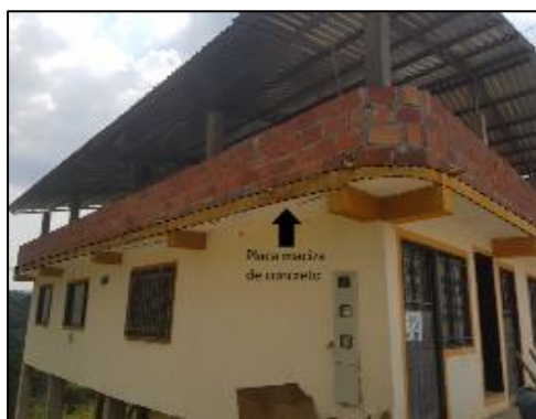
Fotografía 13. Ubicación placa maciza en edificación del municipio de Ocamonte
