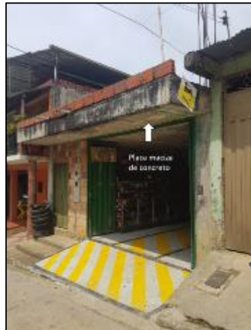
Fotografía 15. Ubicación placa en concreto en edificación del municipio de Ocamonte
