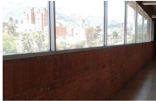
Figura 34. Entrada de luz natural. Oficinas del Grupo Éxito. La entrada de luz difusa es un elemento que puede llegar a utilizarse para minimizar el uso de luminarias en horas de la mañana. La distribución de los paneles evita la entrada de luz difusa.
