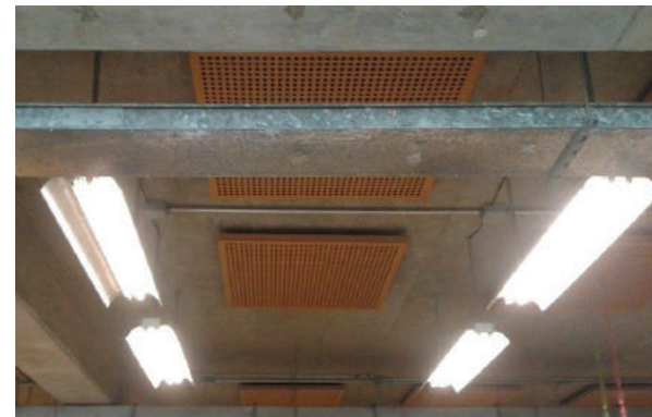
Figura 29. A. Sistema de iluminación, oficina principal del Grupo Éxito. B. Foto representativa. La disposición oriente - occidente de las luces, sumada a las disposiciones de los puestos de trabajo generan baja calidad de la iluminación.
