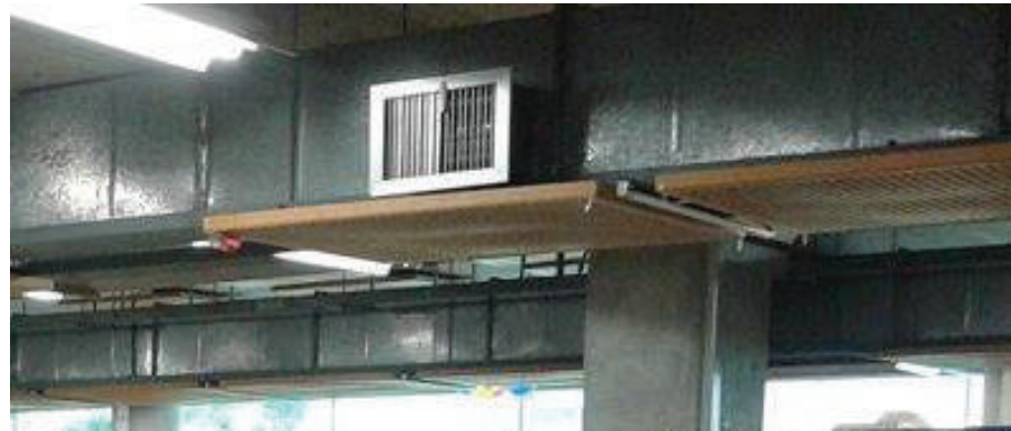
Figura 28. A. Sistema de aire acondicionado, oficina principal del Grupo Éxito. B. Foto representativa. Sistema de agua helada con entrega por difusores laterales de una vía.
