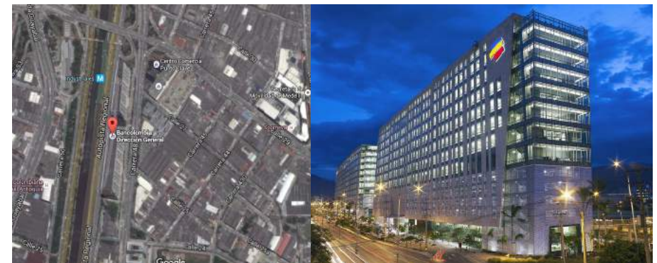
Figura 9. Vista aérea del edificio.
