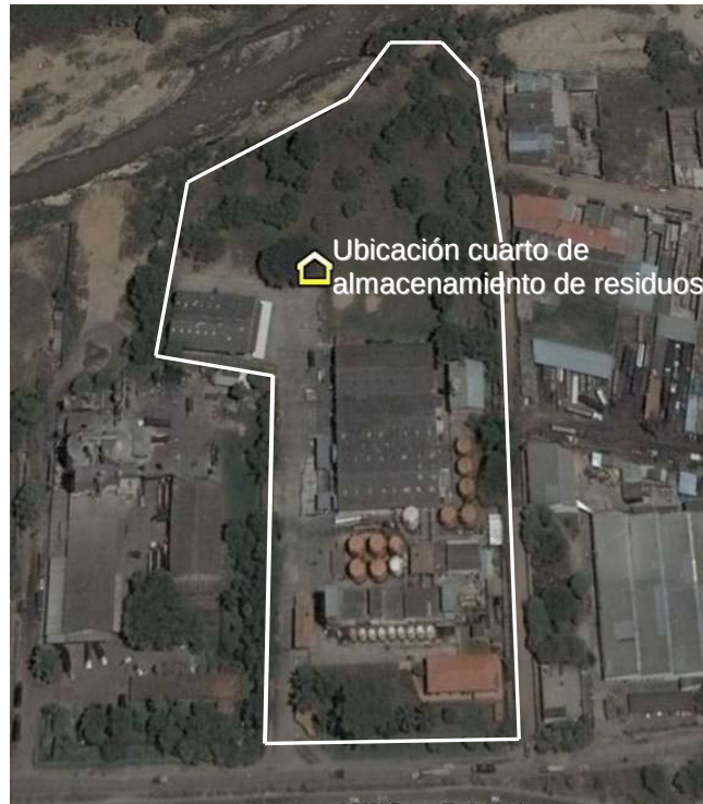
Figura 27. Ubicación cuarto de almacenamiento de residuos.
