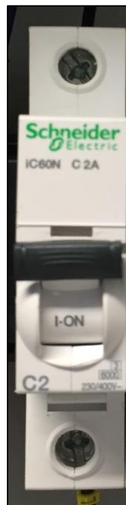
Figura 57. Protección para la fuente de 24V
