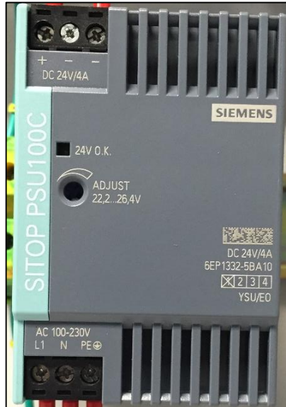
Figura 83. Fuente externa de 24VDC SIEMENS SITOP PSU100C
