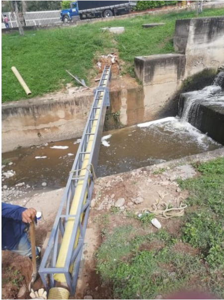
Figura 32: Estructura metálica instalada y soldada Figura33: Estructura metálica con lámina anticorrosiva.
