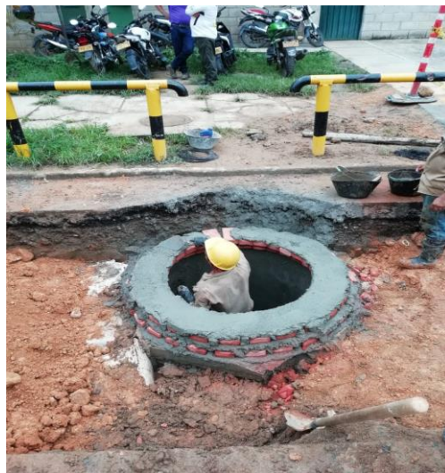
Figura17: cono de pozo hecho en mampostería.
