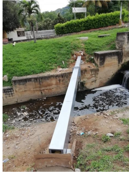
Figura 32: Estructura metálica instalada y soldada Figura33: Estructura metálica con lámina anticorrosiva.
