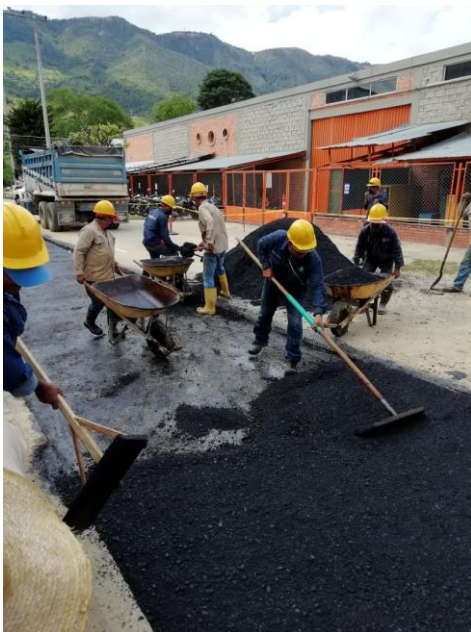
Figura27: Suministro de material bituminoso Figura28: Compactación de material bituminoso (pavimento flexible) con VIBROMAX.
