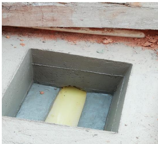
Figura 21: Caja de inspección o domiciliaria terminada sin tapa.
