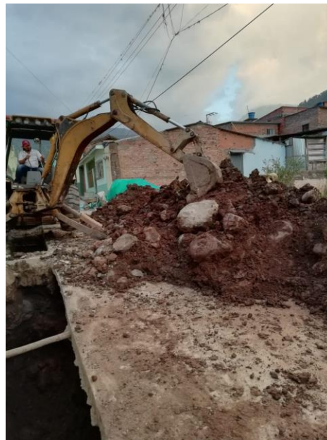
Figura 44: Material rocoso extraído de zanja.
