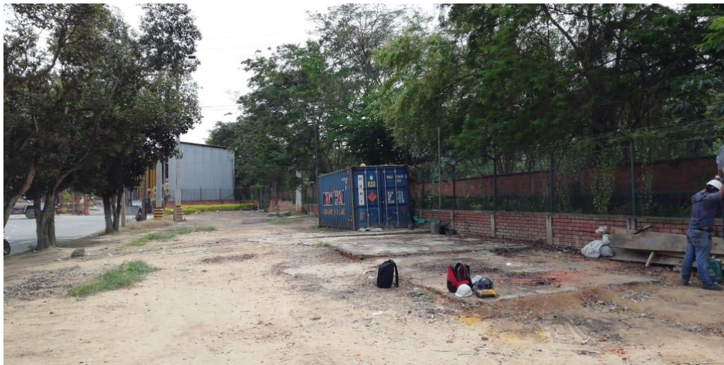
Figura 38: Limpieza y aseo de la zona donde estaba el campamento.
