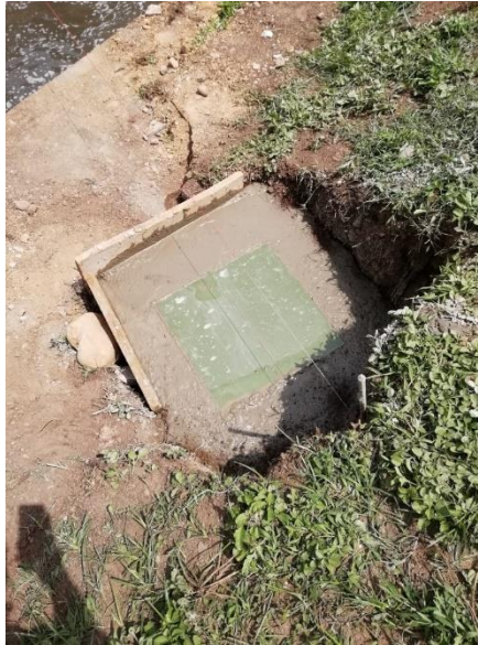
Figura30: Construcción de muertos o reposaderos de estructura de estructura metálica.
