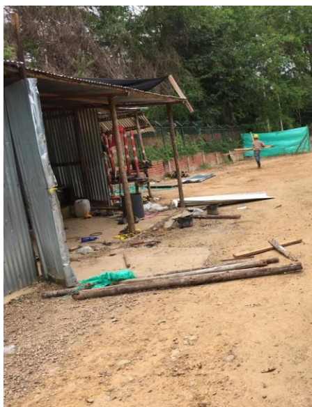
Figura37: Desmonte de paredes en tejas zinc del campamento.
