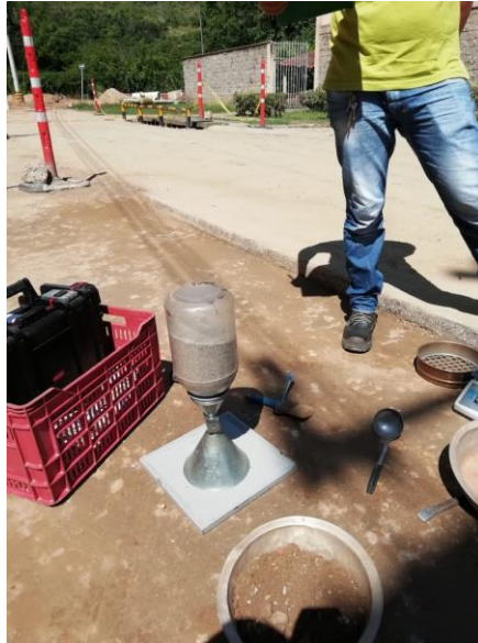
Figura 24: Suministro de arena con densidad conocida en excavación manual.
