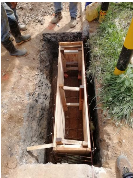
Figura19: Despiece de acero dentro de formaleta Figura20: Suministro de concreto de 3000 psi.
