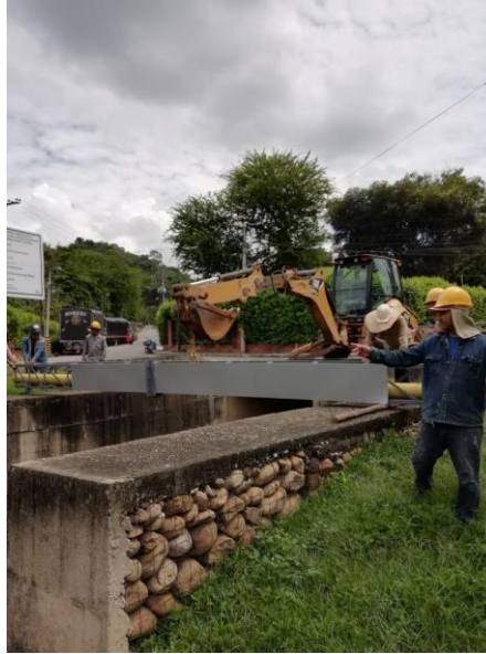
Figura31: Transporte y traslado de estructura metálica por retrocargador.
