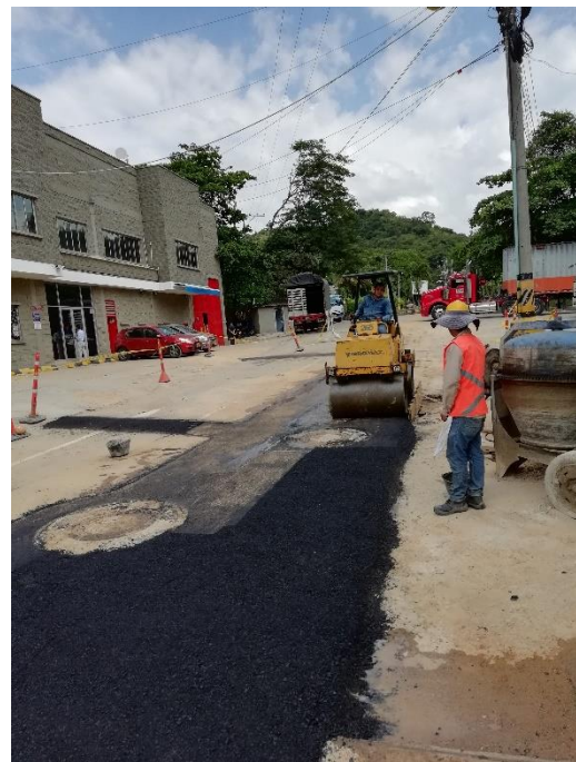
Figura27: Suministro de material bituminoso Figura28: Compactación de material bituminoso (pavimento flexible) con VIBROMAX.
