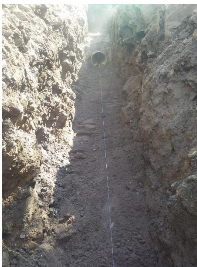
Figura 47: Instalación de tubería por reposición.
