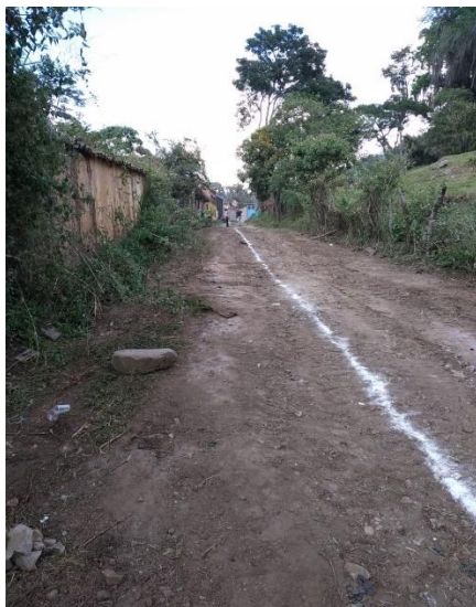
Figura 39: Replanteo sobre la carrera3 con calle 2.
