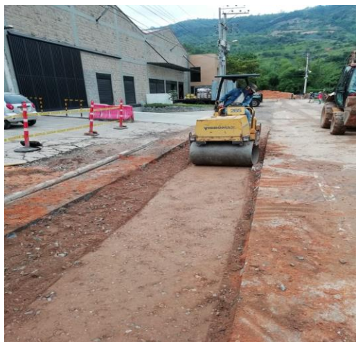
Figura 12: Suministro y compactación de base granular con vibro compactador.
