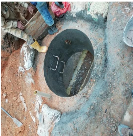
Figura16: Cilindro o cuerpo de pozo incluyendo pasos.
