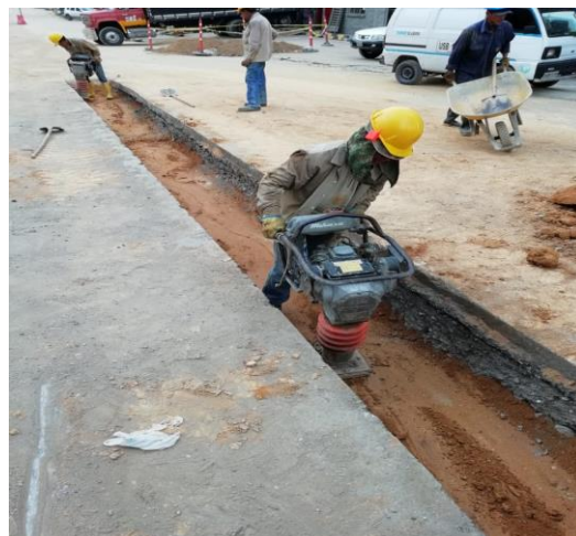
Figura11: Suministro y compactación de material seleccionado con apisonador manual.
