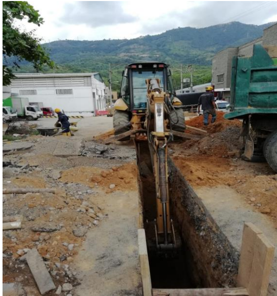
Figura8: Excavación de zanja por retro excavadora 416D.
