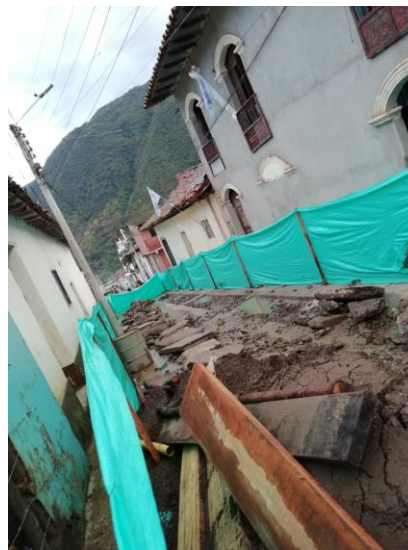
Figura 40: Cerramiento con lona verde sobre carrera 6 calle 8.
