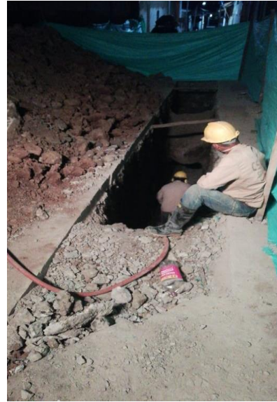
Figura 43: Demolición de rocas.
