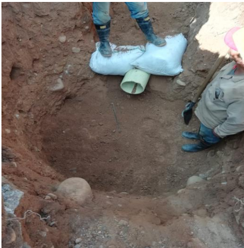
Figura14: Replanteo para fundición de solado de 2,500 psi.
