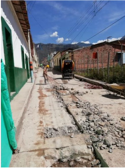
Figura 42: Corte y demolición de pavimento rígido.
