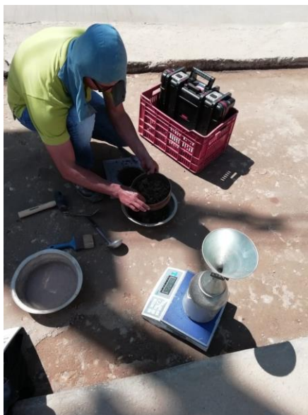
Figura 23: Excavación manual en base granular.
