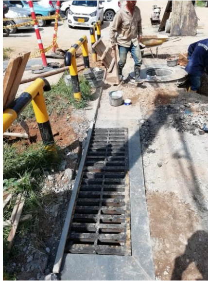
Figura18: Construcción de sumidero lateral.
