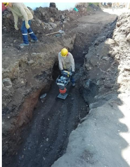
Figura 45: Compactación de material seleccionado
