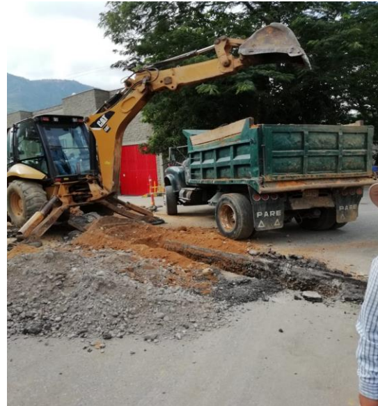
Figura9: Retiro de material no reutilizable (Escombros y piedras).
