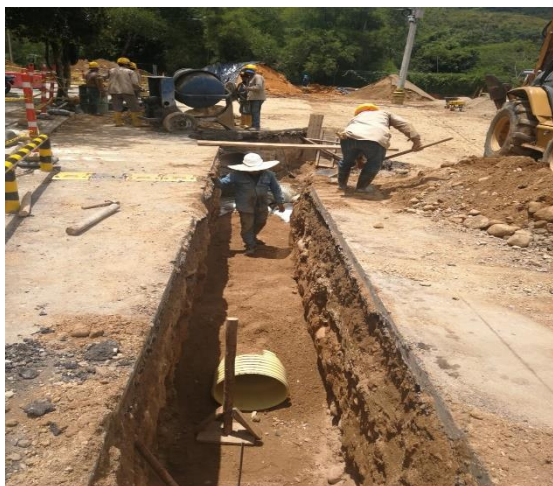
Figura10: Suministro y compactación de gravilla para cimentación de tubería.
