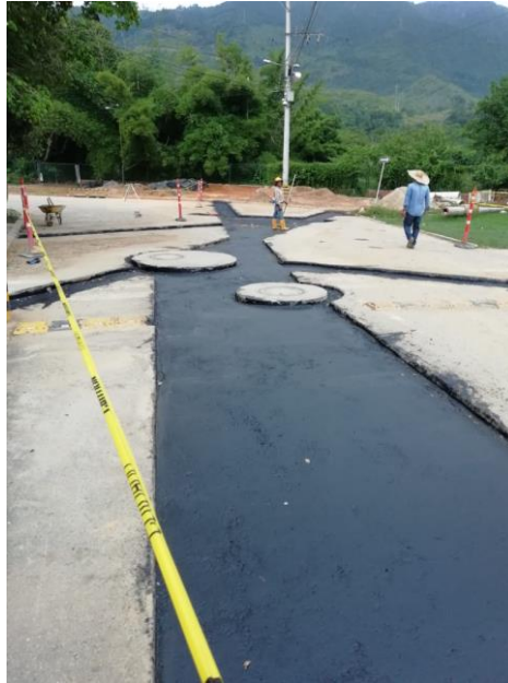
Figura 26: Suministro y riego de emulsión asfáltica.
