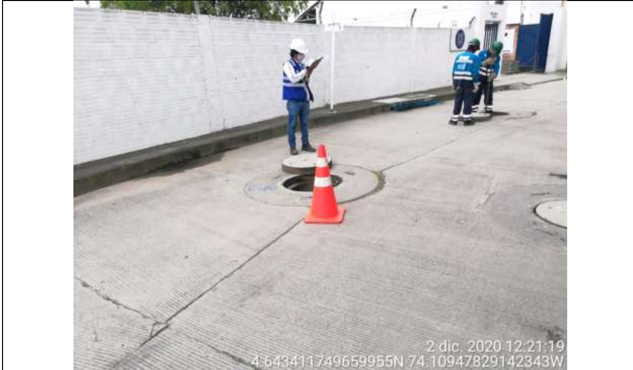
Imagen 9. Box Culvert PK5
