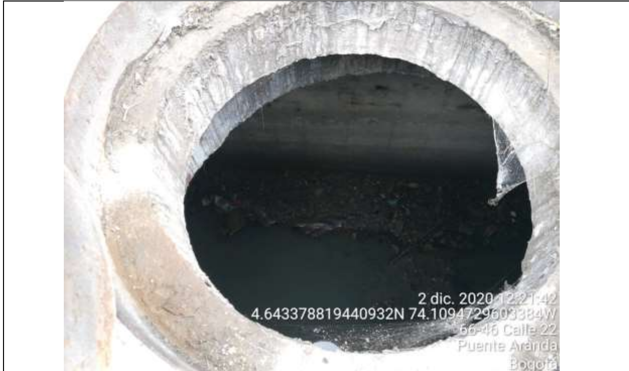
Imagen 8. Box Culvert PK5
