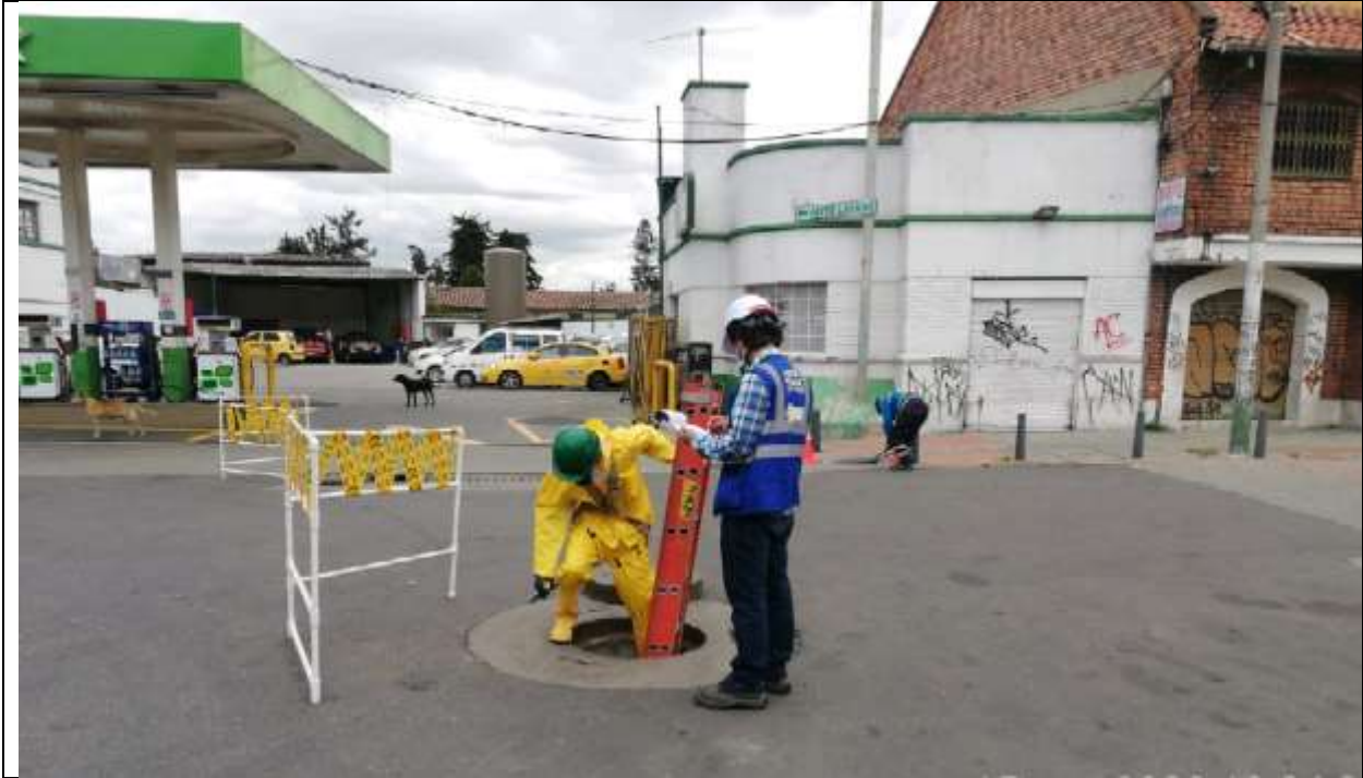
Imagen 1. Apertura pozo P001
